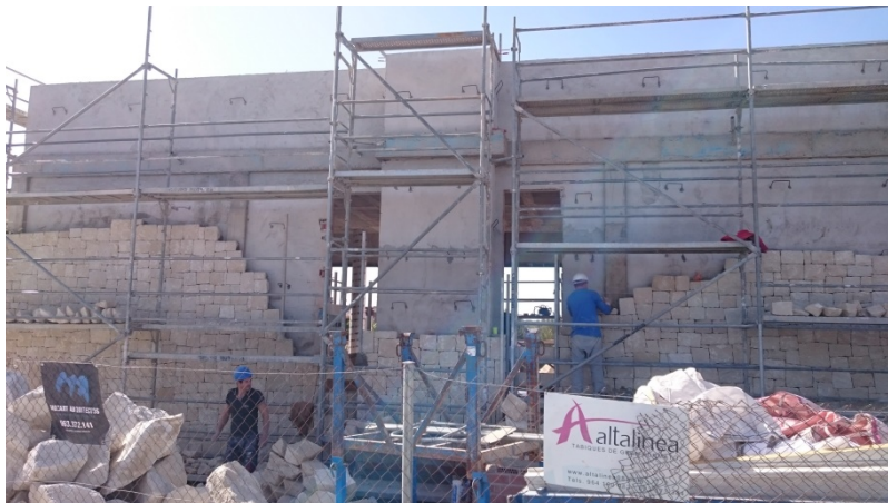
Imagen 27, ejecución fachada mampostería, fuente propia
