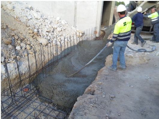
Imagen 20, hormigonado muro, fuente propia
