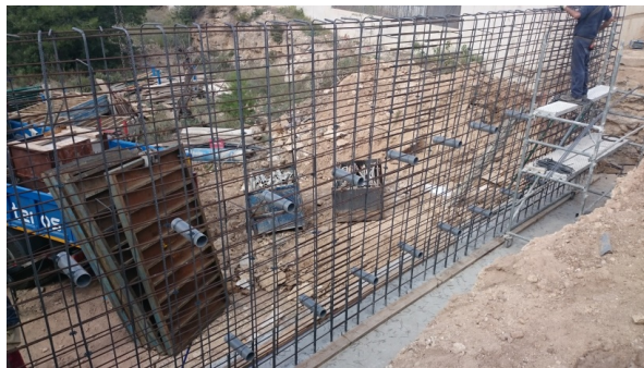
Imagen 8, mechinales muro, fuente propia
