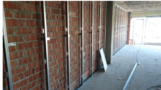
Imagen 41, colocación guías placa de yeso laminado, fuente propia
