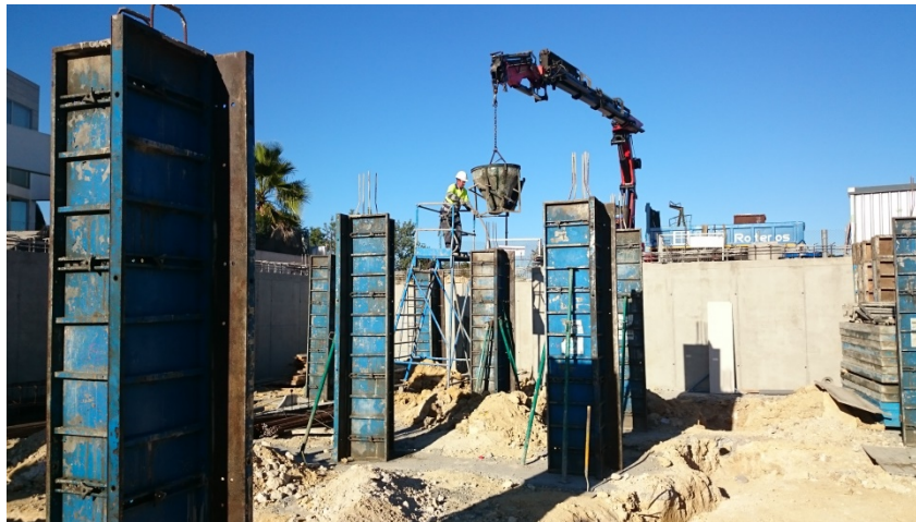
Imagen 13, hormigonado de pilares, fuente propia
