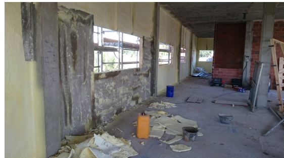
Imagen 33, retirada de aislamiento, fuente propia
