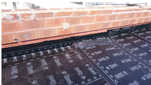
Imagen 42, impermeabilización azotea, fuente propia
