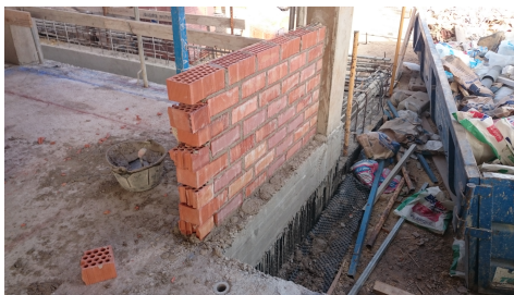
Imagen 24, ejecución fachada, fuente propia
