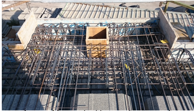
Imagen 16, armado chimenea, fuente propia
