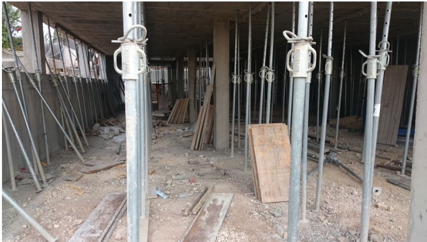
Imagen 18, apuntalamiento forjado, fuente propia
