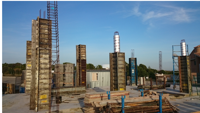
Imagen 17, encofrado pilares, fuente propia
