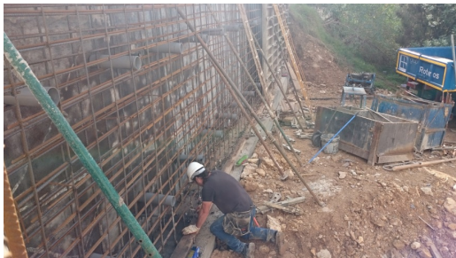
Imagen 9, limpieza muro, fuente propia
