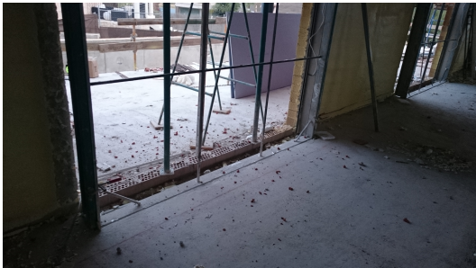
Imagen 40, colocación premarcos, fuente propia
