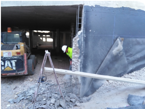
Imagen 22, corte muro, fuente propia
