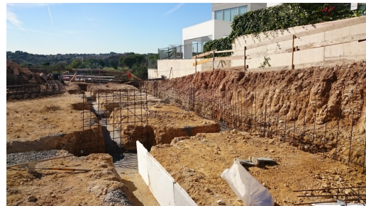
Imagen 10, cimentación, fuente propia
