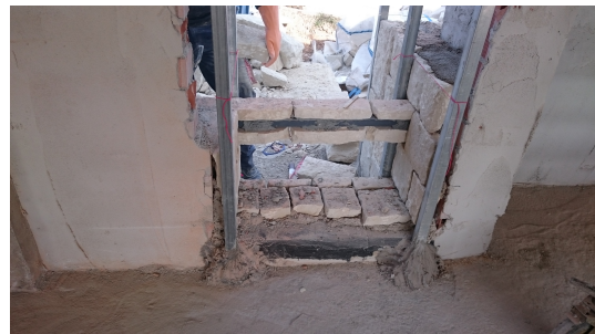
Imagen 30 y 31, ejecución dinteles, fuente propia
