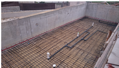
Imagen 44, ferrallado piscina, fuente propia
