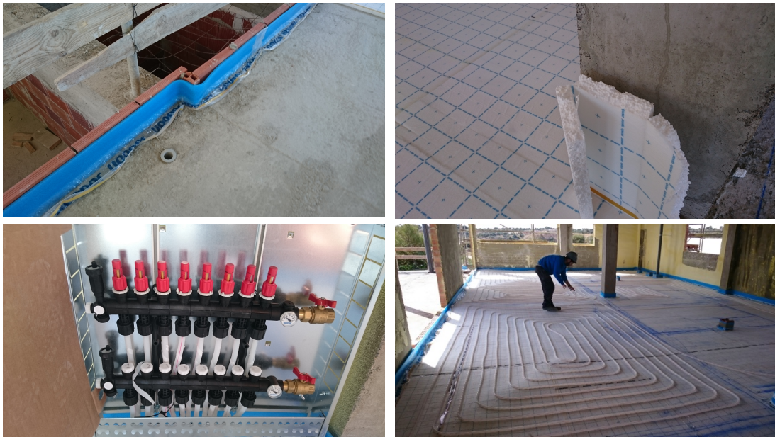
Imagen 34, 35, 36 y 37, colocación suelo radiante, fuente propia
