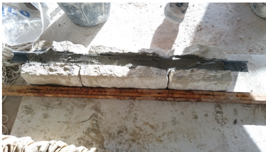
Imagen 30 y 31, ejecución dinteles, fuente propia
