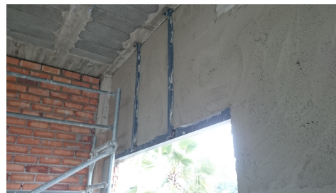
Imagen 25, colocación dinteles, fuente propia
