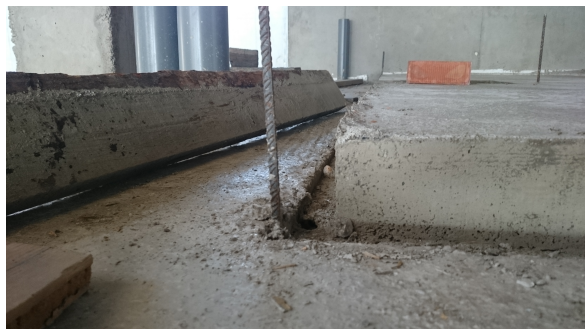
Imagen 23, hormigonado solera, fuente propia
