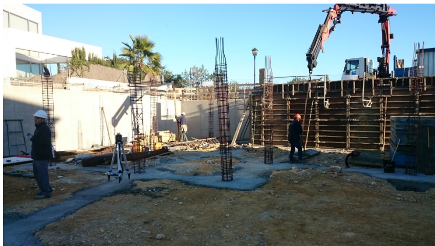
Imagen 12, armado de pilares, fuente propia
