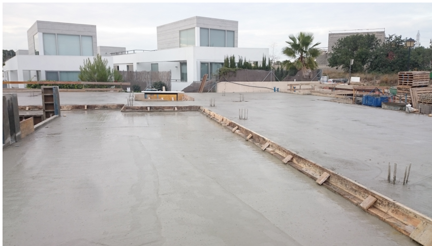
Imagen 15, hormigonado de forjado, fuente propia
