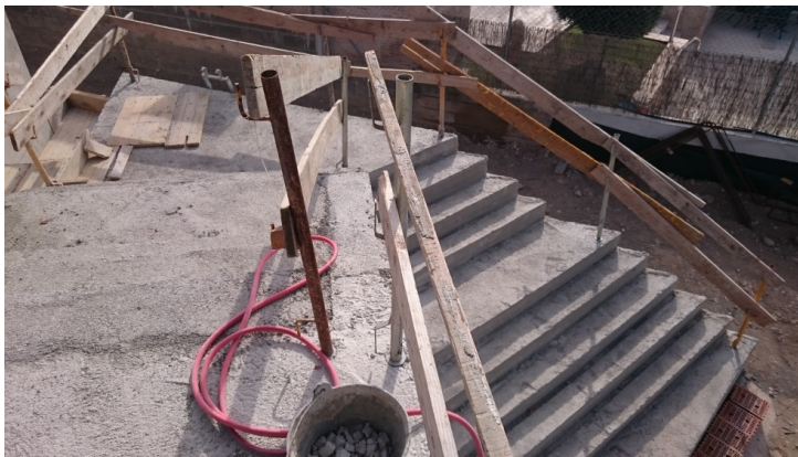
Imagen 26, ejecución escalera, fuente propia
