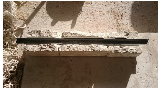
Imagen 28 y 29, ejecución dinteles, fuente propia
