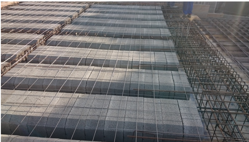
Imagen 14, armado de forjado, fuente propia
