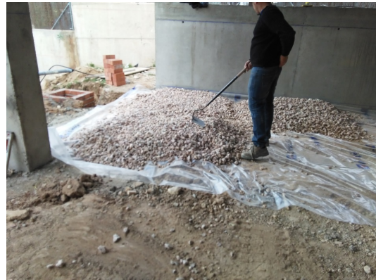
Imagen 21, encachado solera, fuente propia
