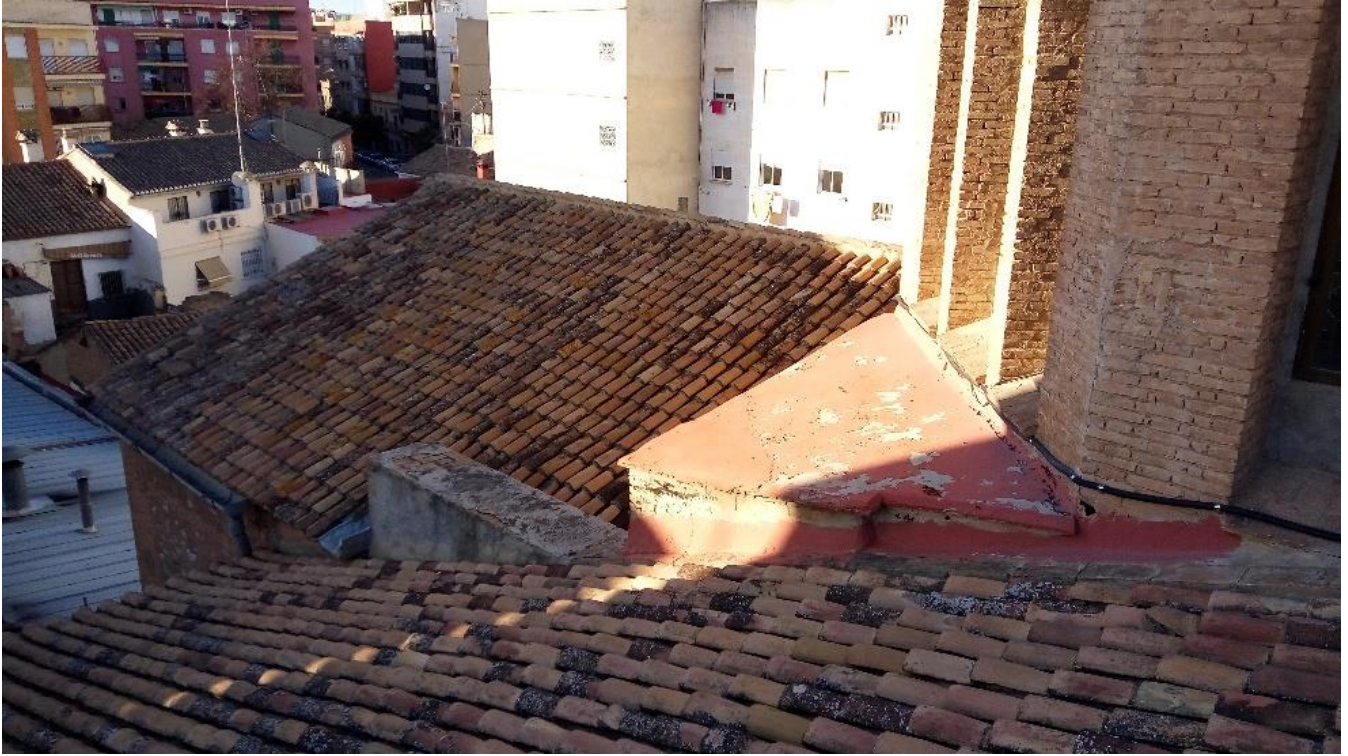
Figura 57: Recogida de aguas en cubierta. Fuentes propias
