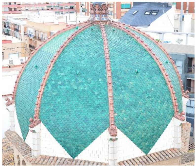
Figura 116: Cubierta desde el campanario. Fuentes propias
