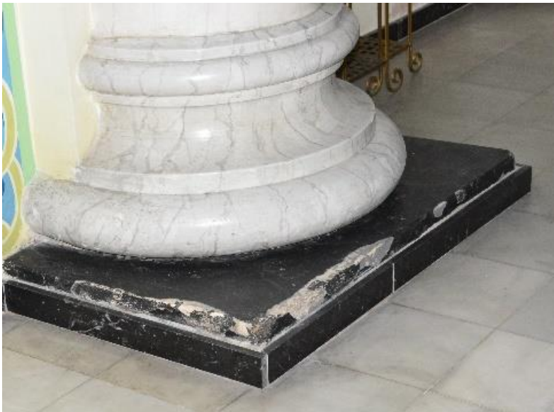
Figura 117: base de los pilares. Fuentes propias
