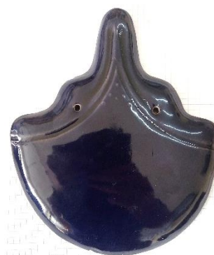
Figura 48a: Teja de lágrima de la aguja de la torre del Palacio de la Exposición en Valencia. Colección personal del profesor Juan Aznar Mollá.
