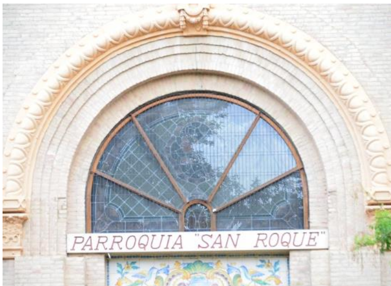
Figura 100: Arco medio punto fachada principal. Fuentes propias
