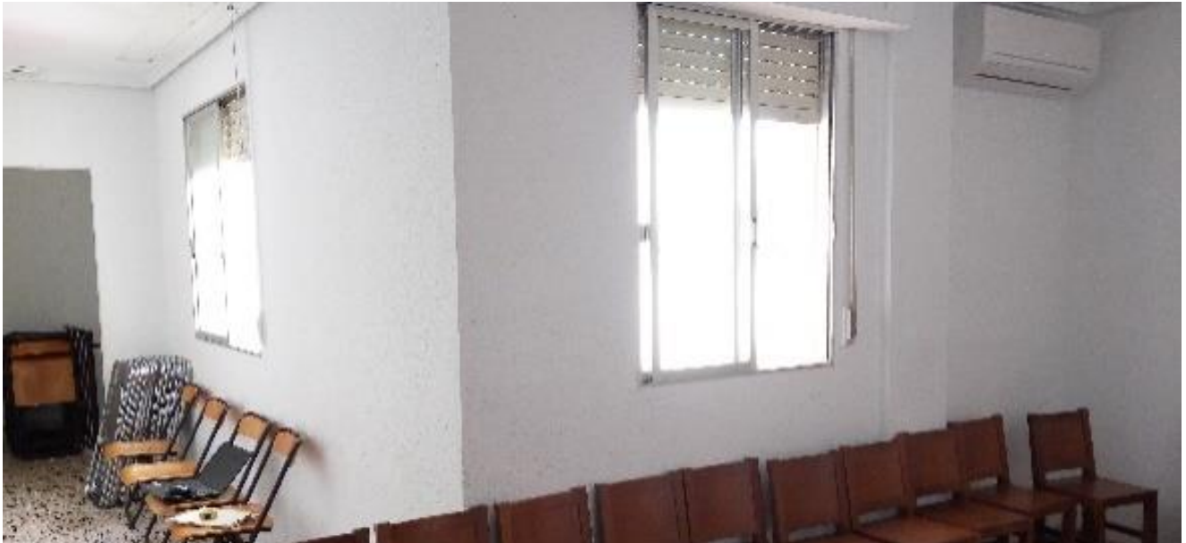
Figura 138: Locales anexos. Fuentes propias
