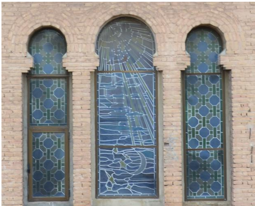
Figura 22: Vidrieras en el cimborrio. Fuentes propias.
