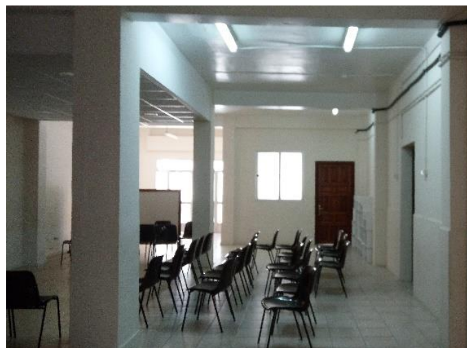
Figura 162: Locales anexos. Fuentes propias
