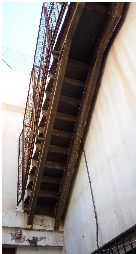
Figura 140: Escaleras de acceso a la cubierta. Fuentes propias
