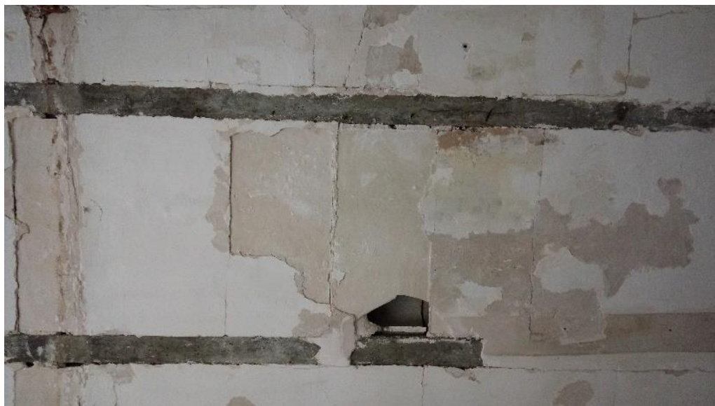
Figura 63: Aluminosis en viguetas pretensadas
