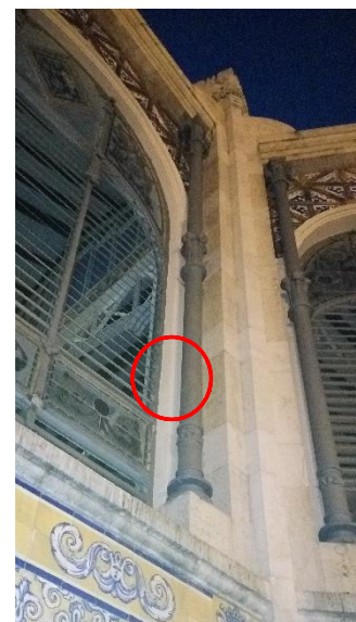
Figura 45a: Zócalo ruleteado columna en Templo Parroquial de San Roque (izquierda). Enfoscado ruleteado tras columna de fundición en fachada del Mercado Central de Valencia (derecha). Fuentes propias.
