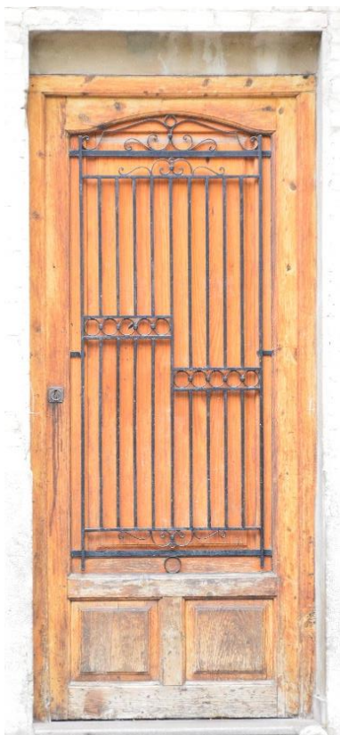
Figura 102: Puertas de acceso a la capilla. Fuentes propias
