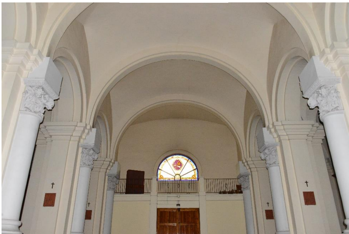
Figura 129: Bóvedas nave principal. Fuentes propias
