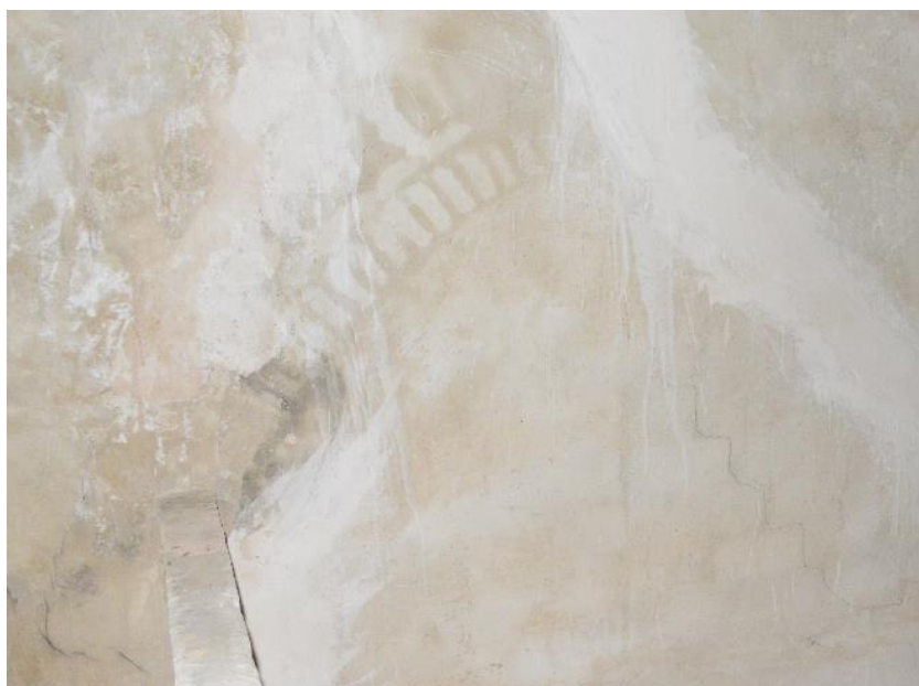
Figura 56: Arcos en el trasdós del muro. Fuentes propias.
