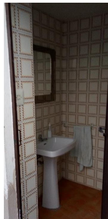
Figura 151: Cuarto de baño locales anexas. Fuentes propias
