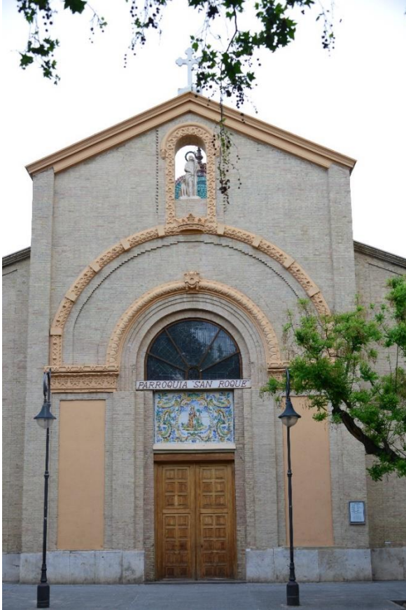
Figura 91. Fachada principal. Fuentes propias
