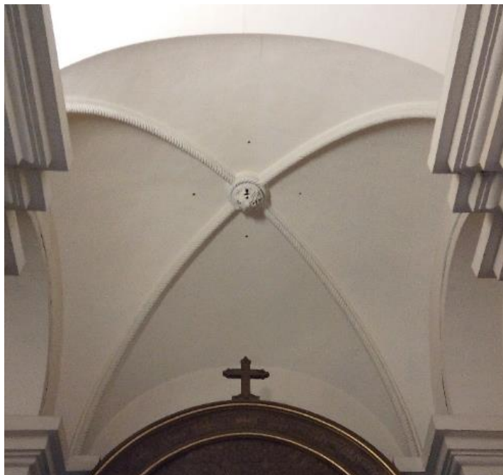
Figura 54: Bóveda de arista naves laterales. Fuentes propias
