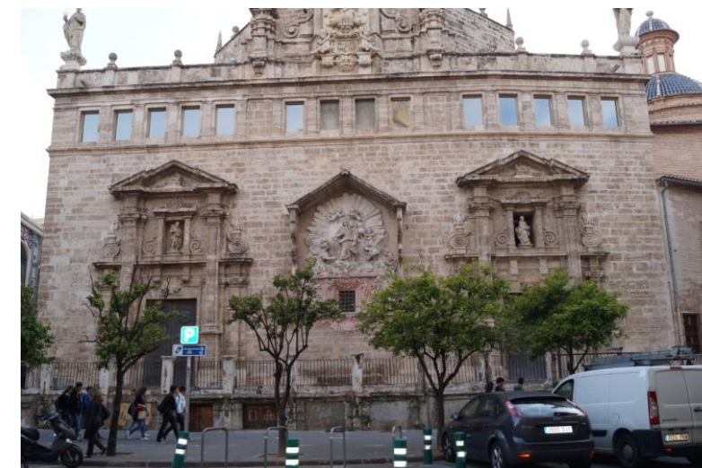
Fig. nº 39. Fotografía fachada. Fuente propia
