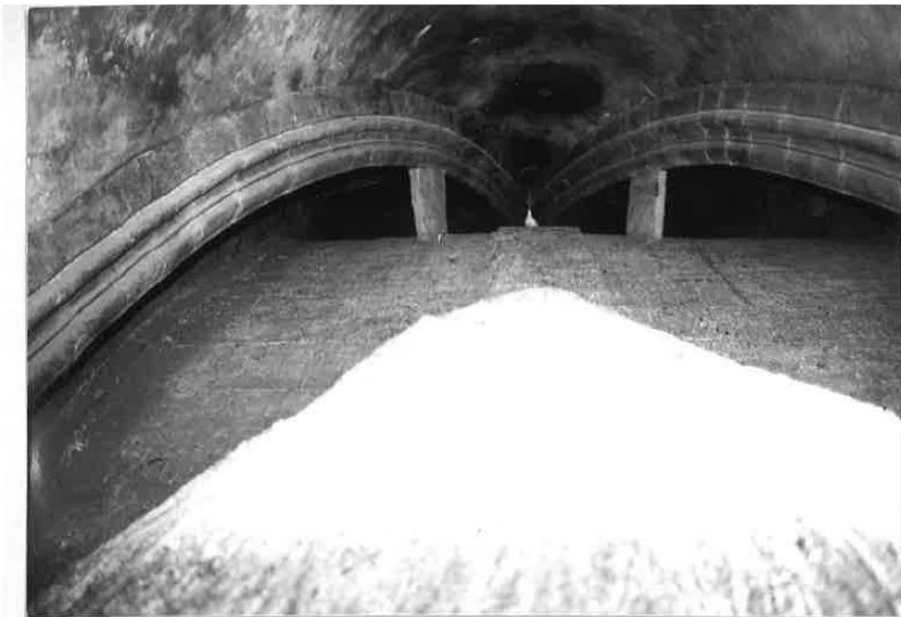
Fig. 27. Fotografía extradós luneto barroco. Fuente: (Estellés, J.J)
