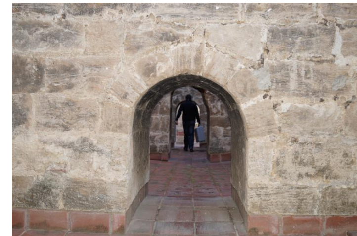
Fig. nº 35. Arcos de contrafuerte. Fuente: (propia)
