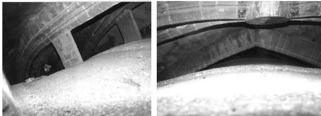
Fig. 45-46. Fotografía de la antigua bóveda gótica. Juan José Estellés.
