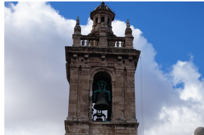
Fig. 39. Fotografía campanario. Fuente: (propia).
