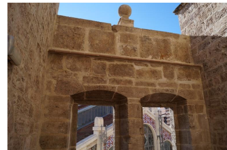
Fig. nº 36. Fotografía en cubierta. Fuente: (propia).
