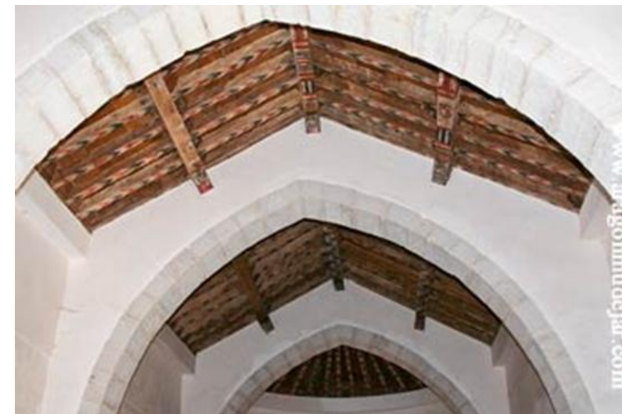
Figura 20: Sistema de arcos diafragmáticos.
