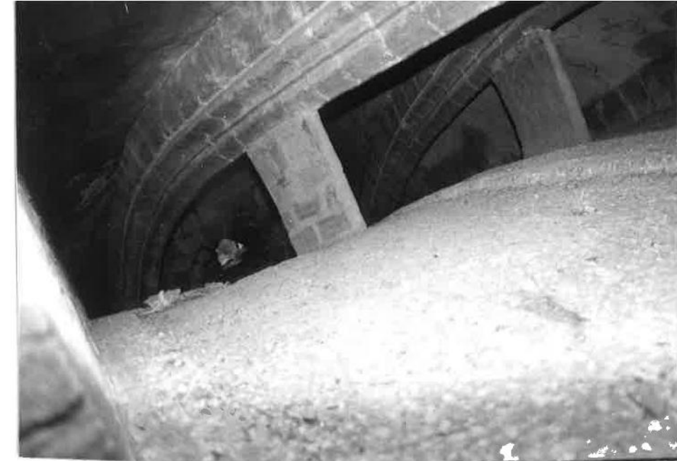
Fig. 33. Bóveda tabicada y su arriostramiento sobre los arcos cruceros de la primitiva bóveda gótica.
