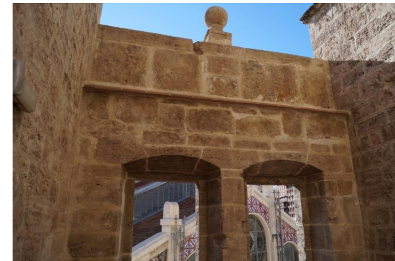
Fig. 50. Fotografía muros y contrafuertes desde cubierta. Fuente: (propia)
