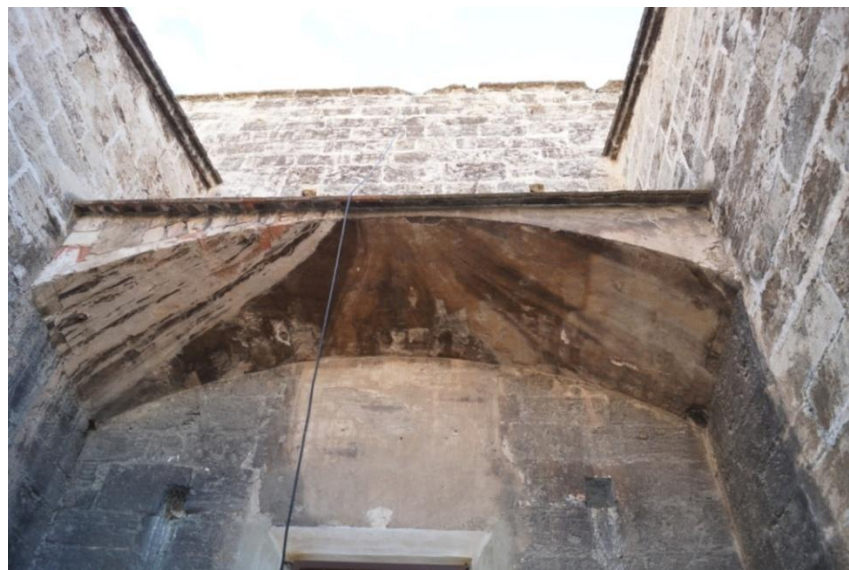
Fig. 48. Fotografía muros y contrafuertes desde cubierta. Fuente: (propia)
