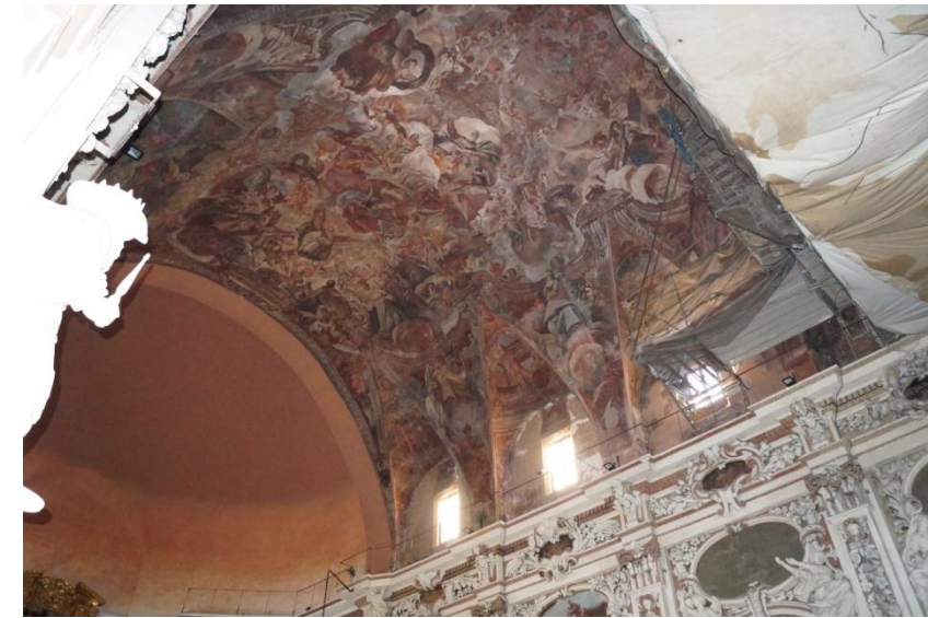
Fig. nº 37. Fotografía bóveda interior. Fuente: (propia)
