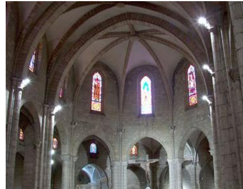
Fig. 28. Fotografía iglesia tipo gótico valenciano. Fuente: ( http://www.via-arquitectura.net/ )
