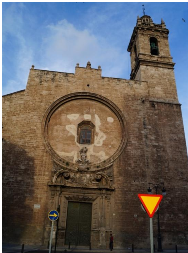
Fig. 42. Fachada Cementerio San Juan. Fuente: (propia)
