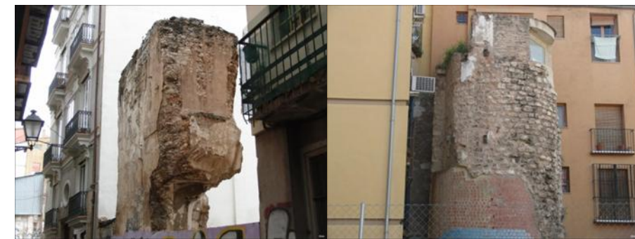
Fig. 16 y 17. Restos de muralla árabe en Valencia. Fuente: https://www.google.es
