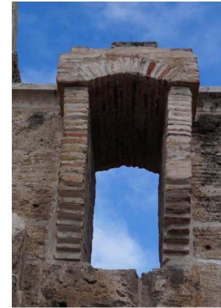
Fig. 49. Fotografía muros desde cubierta. Fuente: (propia)
