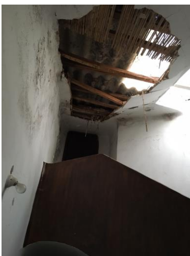
Detalle construcción de cubierta.
