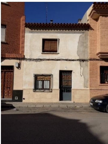
Fachada principal a calle Soledad
