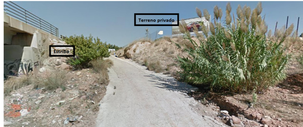
Figura VII IMAGEN DEL ESPACIO PARA COLOCACION ESTRIBO NORTE
