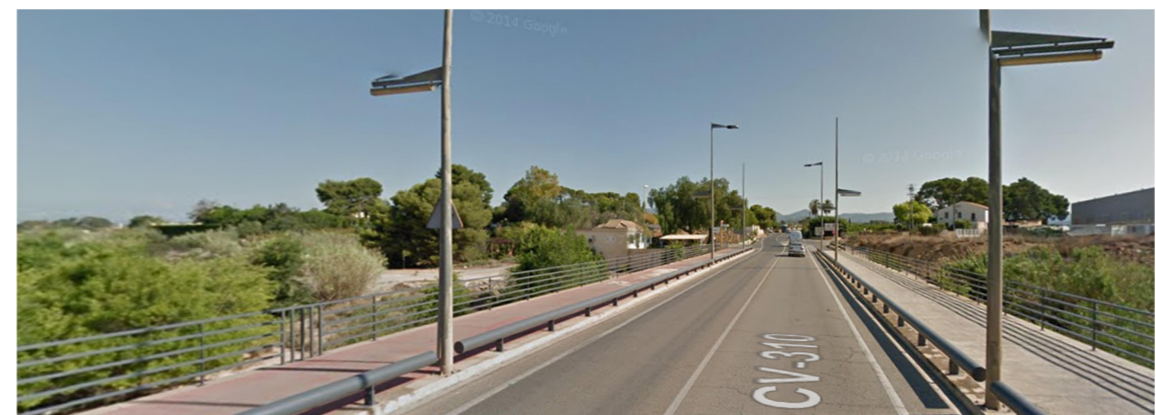
Figura III PUENTE DE LA CV-310 SOBRE EL BARRANCO DEL CARRAIXET
