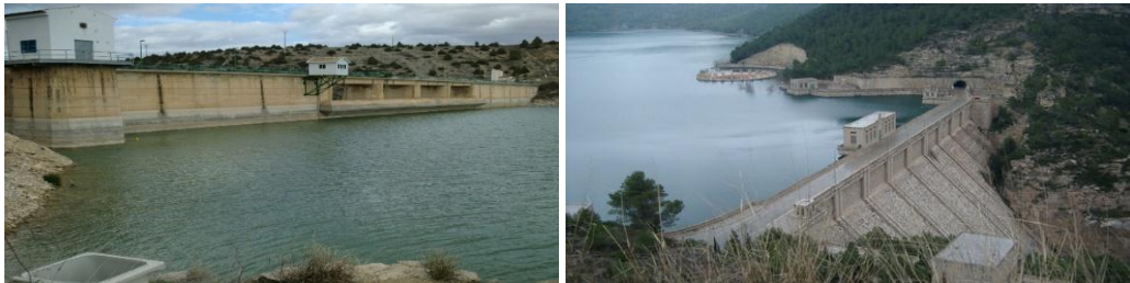
Imagen 18. a) Embalse del Arquillo de san Blas. y b) Embalse de Benagéber.
