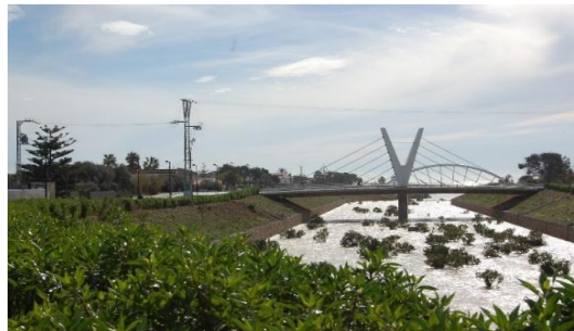
Imagen 3. Desembocadura del río Servol tras una avenida.
