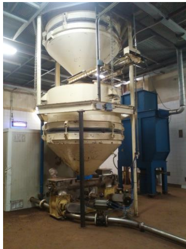
Imagen 12. Silo de control
