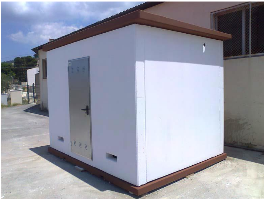
Imagen 9: Caseta prefabricada de hormigón.
