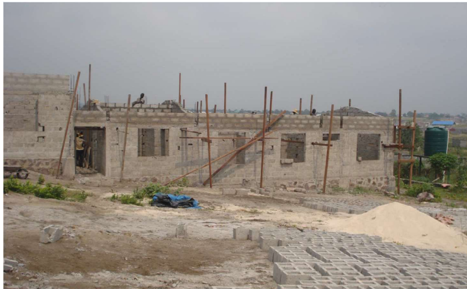
Figura 6: Distribución escuela, grifos, tanques y generador. Dispensario en construcción
