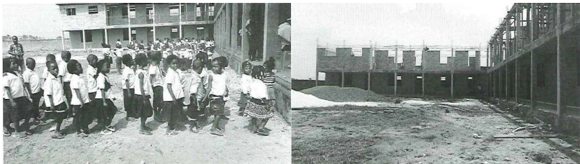
Figura 5: Colegio en construcción Fuente: Fundación Proclade y ONG Korima
