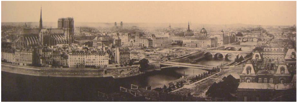
Figura 1.2.18.: Imagen antigua de los trabajos de demolición en la Isla de la Cité (1867), recogida por F. Loyer en “Paris nineteenth century”. Ed. Abbeville Press, NY 1988.
