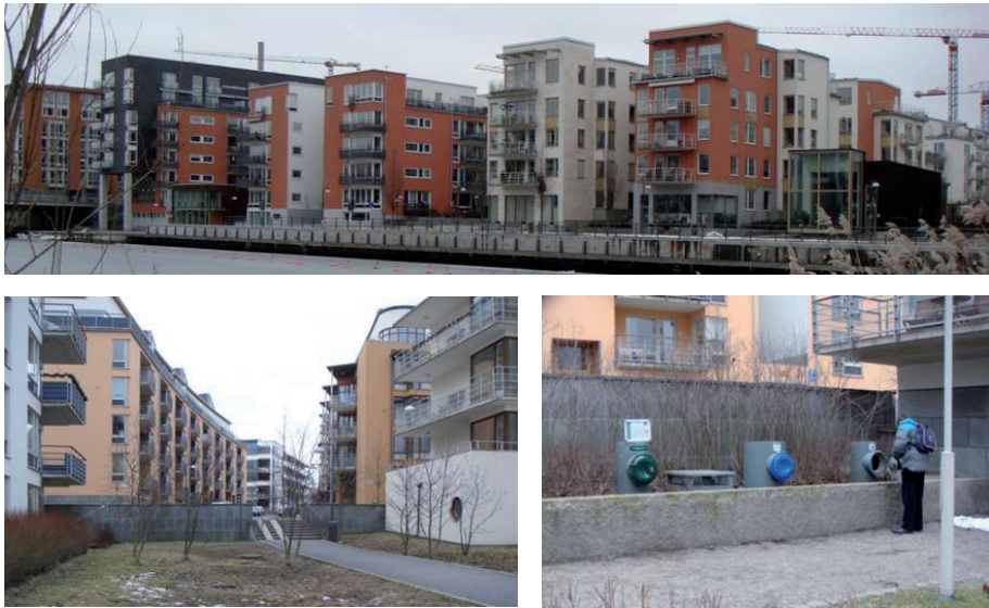
Figura 3.4.11.: Vistas de la evolución de las obras. En la parte superior aparecen los bloques abiertos (70x100m) hacia uno de los brazos de agua que rodea la actuación en los que dominan las 5 plantas y destaca a la derecha de la imagen uno de los elementos de cierre del frente, se trata de edificios menores con uso comercial. En la parte inferior aparece un paso peatonal entre bloques y a la derecha el sistema exterior de recogida selectiva de residuos (archivo autores).
