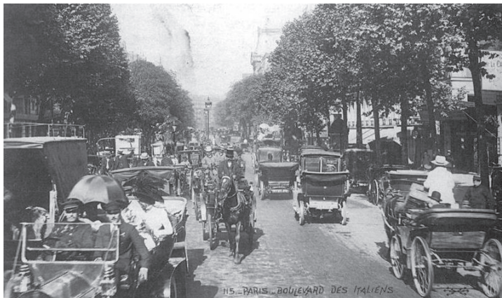
Figura 1.2.4.: Postal antigua que refleja los trabajos de apertura de los bulevares en París.
