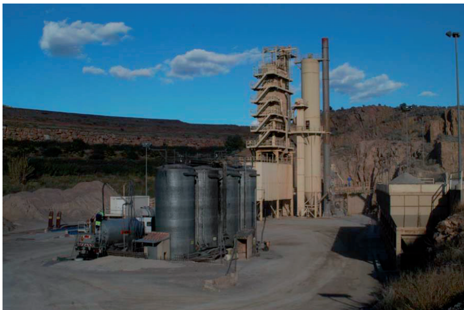
Imagen 2. Planta de aglomerado asfáltico en caliente
