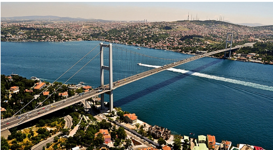
Fig. 11: Vista del primer puente del Bósforo.
