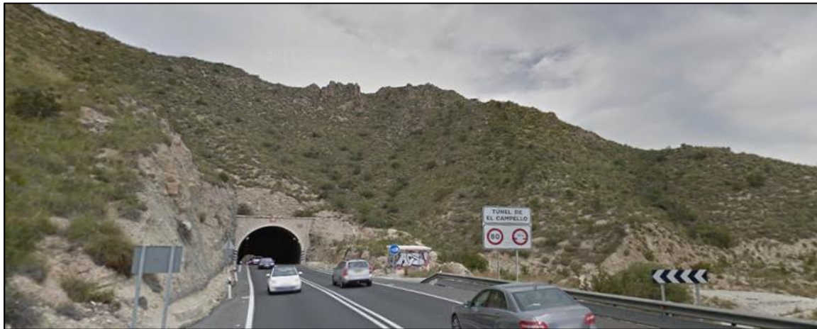
Imagen 11.- Vista de la entrada del túnel – Sentido ascendente P.K's (fuente: G.StreetView)
