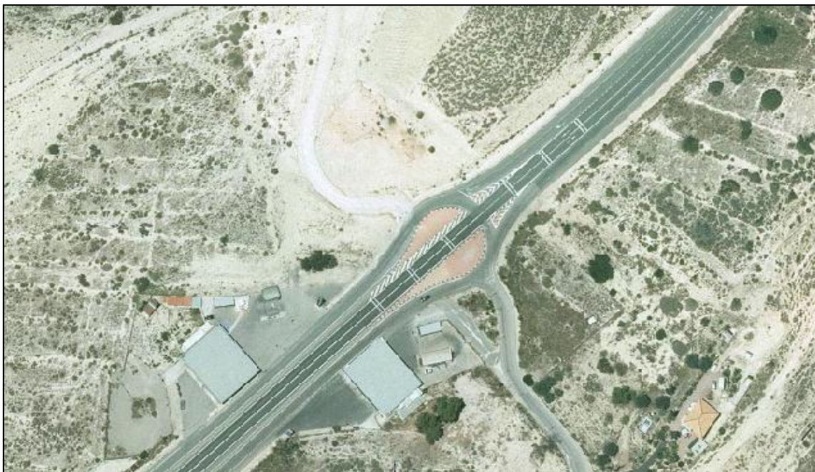
Figura 14.- Vista área de la glorieta partida (Fuente: Ortofoto PNOA)
