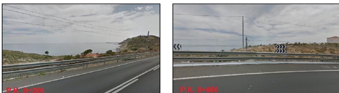
Imágenes 3-4.- Barrera metálica doble (Google Street View)
