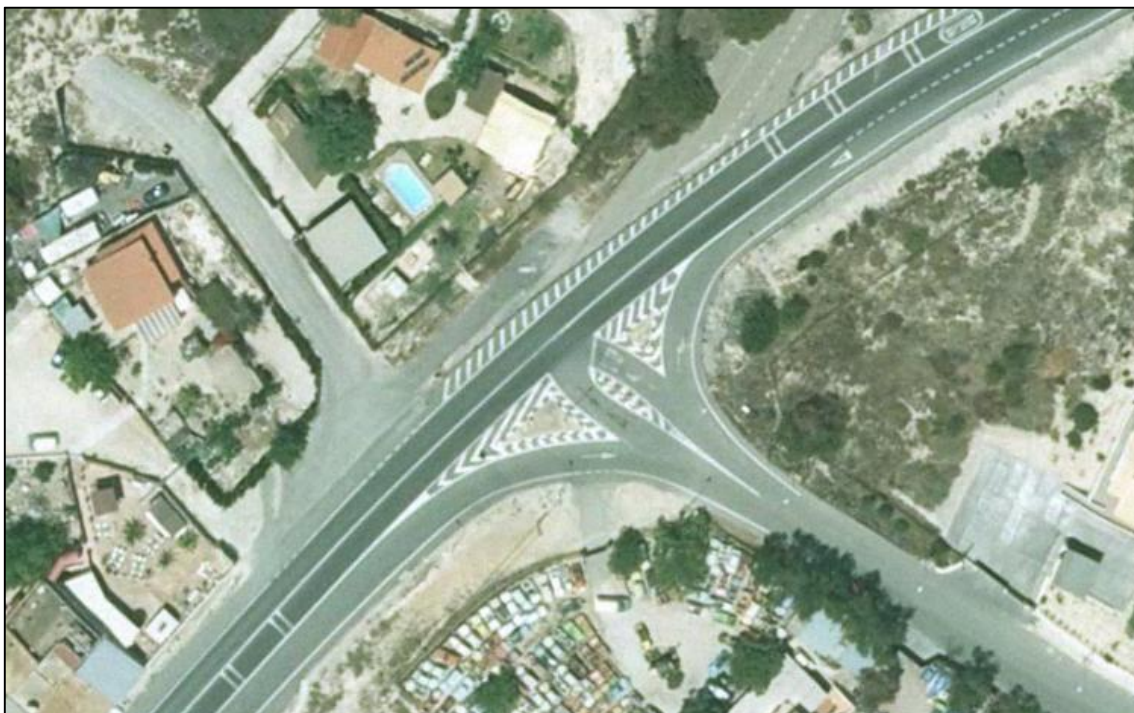
Figura 15.- Vista aérea de la Intersección 2 (Fuente: Ortofoto PNOA)
