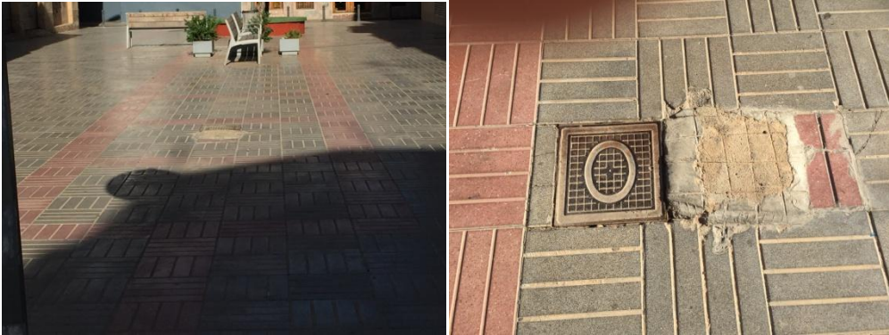
Imagen 45. Zona 1 de trabajo. Alcantarilla
