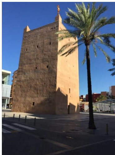
Imagen 4. Antigua Torre. Vista exterior
