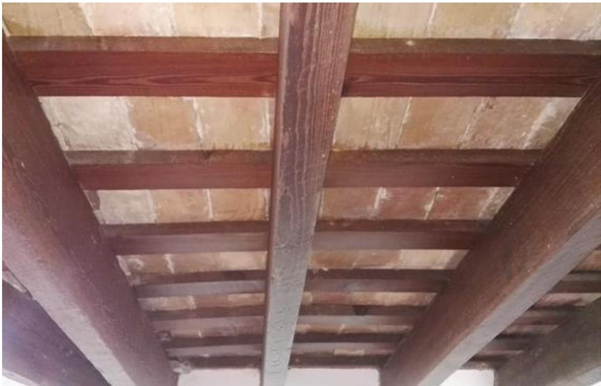
Ilustración 53. Disposición de viguetas y rastroles.
