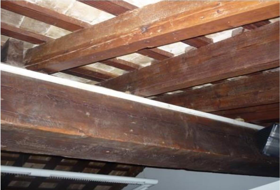
Ilustración 52. Viguetas apoyadas sobre viga de madera.
