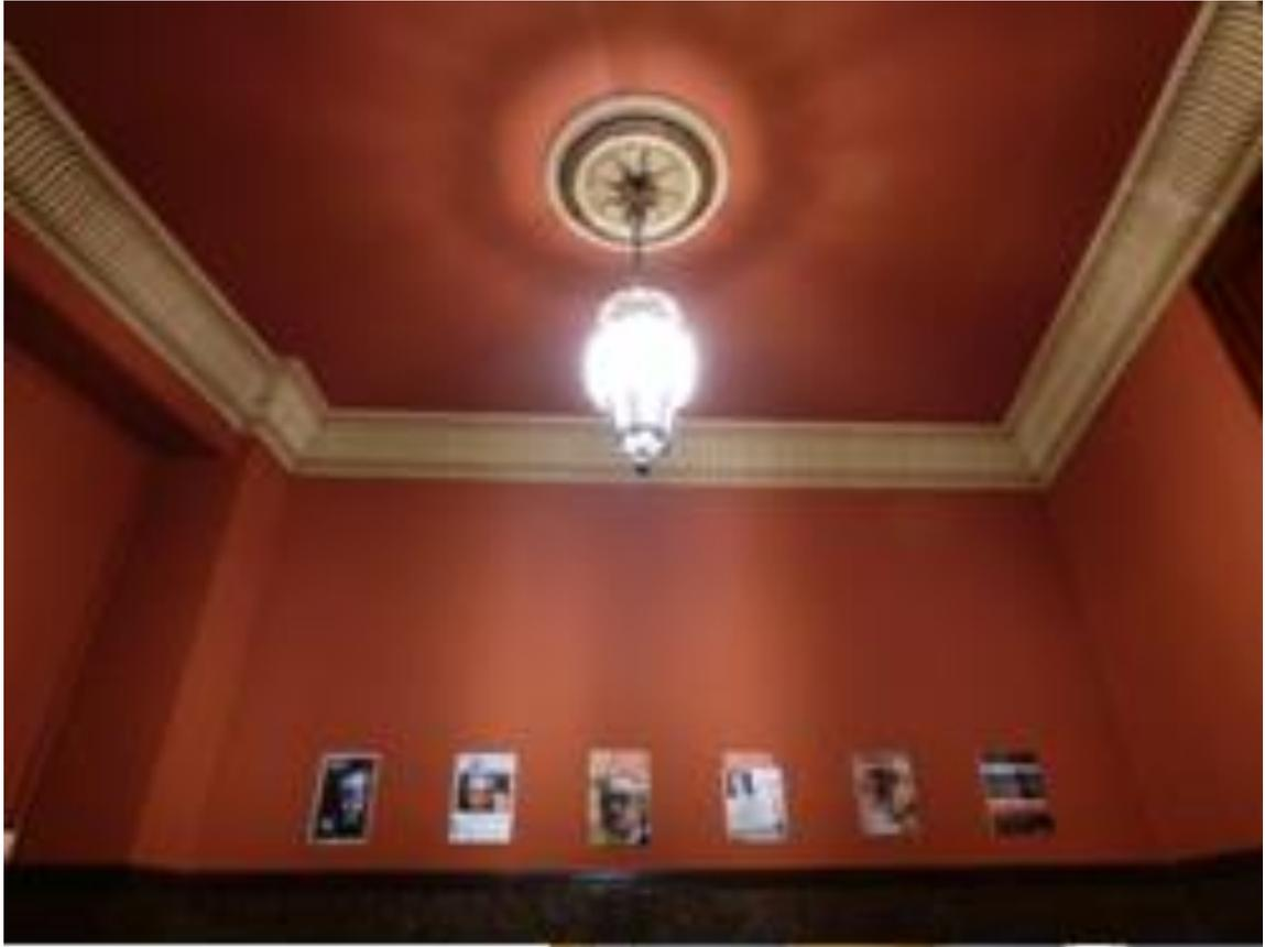
Ilustración 65. Molduras y escayola de la sala 2 de la planta baja.
