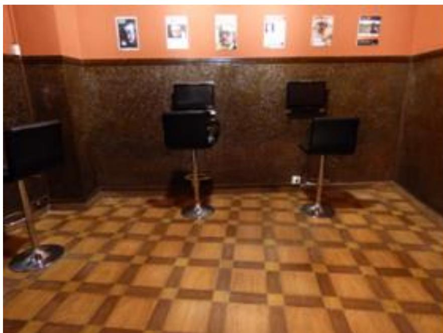
Ilustración 60. Pavimento hidráulico imitación madera del antiguo despacho.
