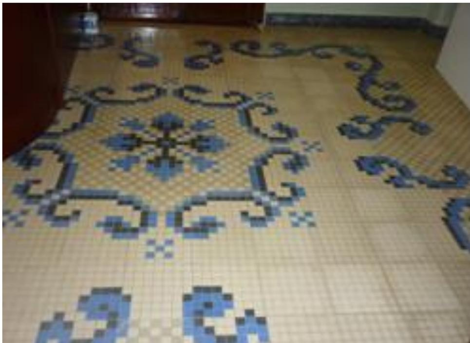
Ilustración 58. Pavimento hidráulico de la sala de la planta baja.
