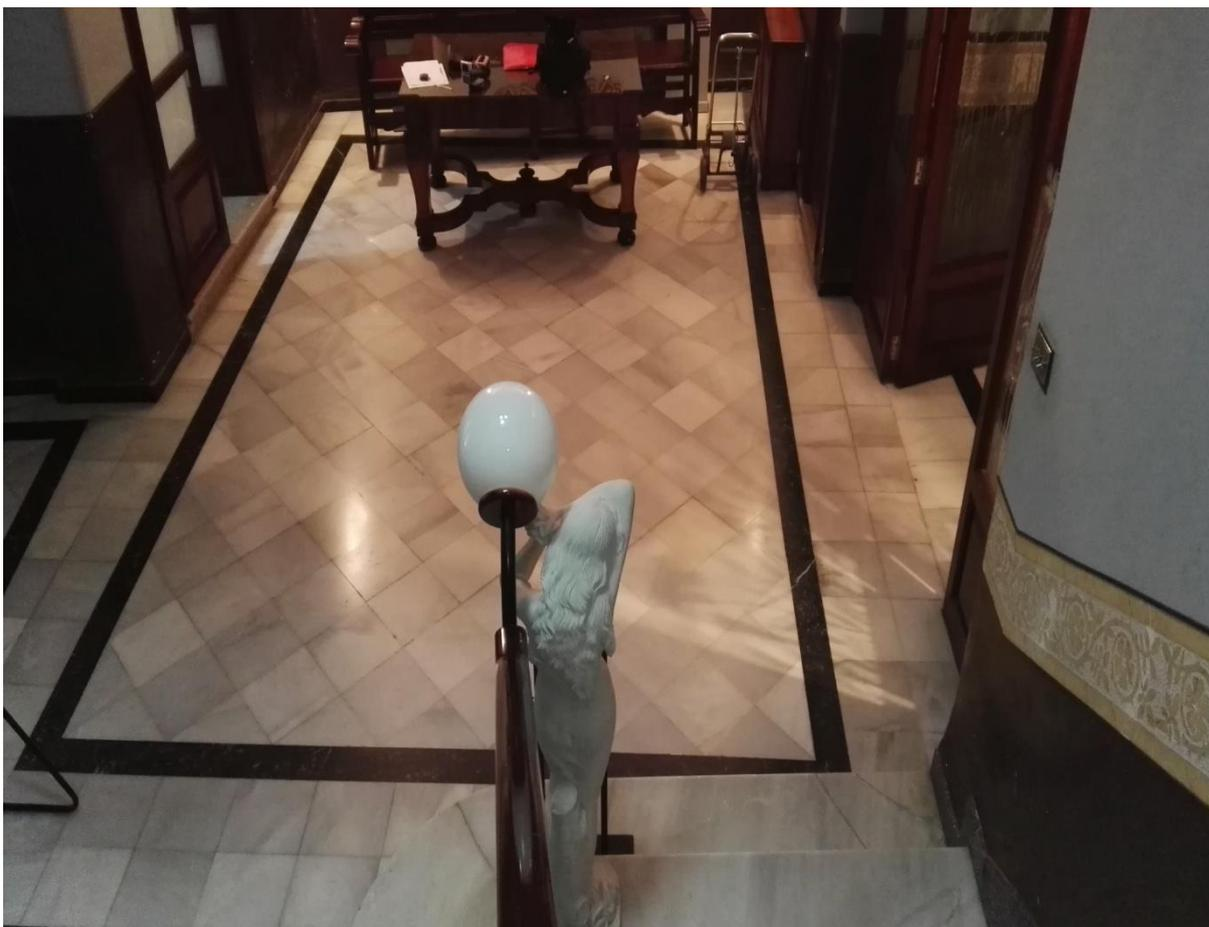
Ilustración 56. Pavimento de mármol correspondiente al comedor de la planta baja (1)
