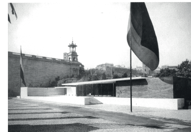
Figura 5.3_Vista exterior con el Palacio de Victoria Eugenia al fondo
