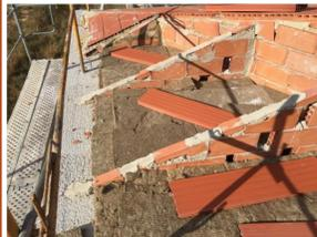
Ejecución cubierta mediante tabiquillo conejero y aislamiento mediante lana de roca.
