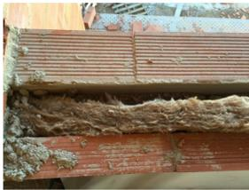
Ejecución cerramiento exterior mediante LH11 +aislamiento mediante lana de roca +LH7
