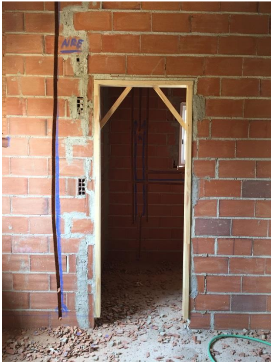
1.21 Colocación de premarco de madera, carpintería interior.
