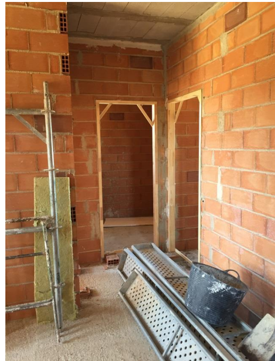
1.22 Colocación de premarco de madera, carpintería interior.
