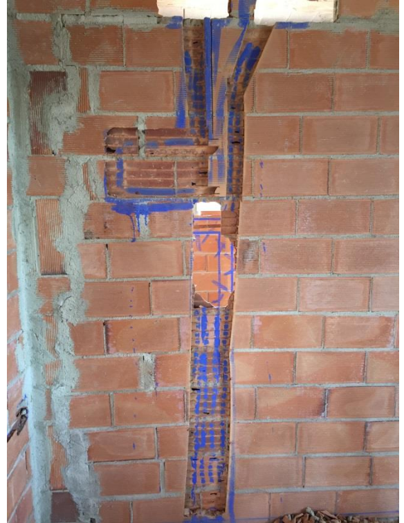
1.26 Rozas de instalaciones.
