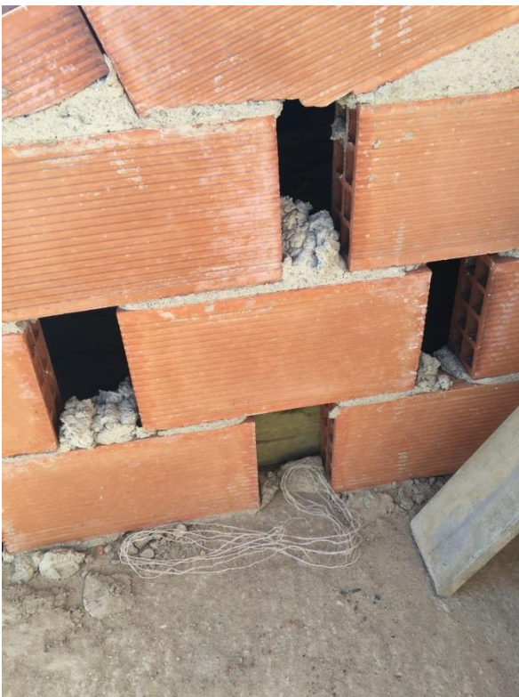
1.15 Comprobación aislamiento cubierta piso inferior. Y ejecución de la misma.
