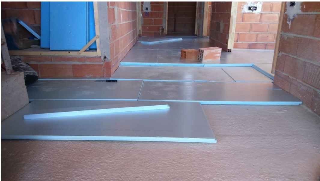
1.31 Colocación 8cm de XPS.
