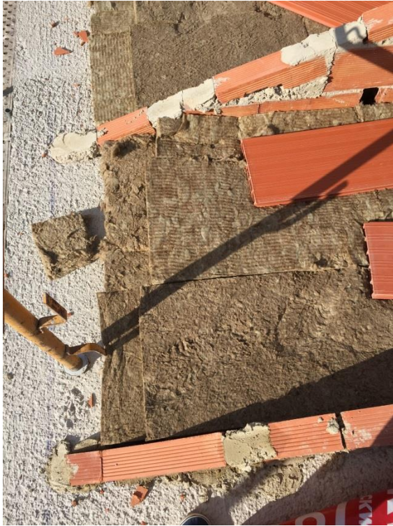
1.3 Vista de la de cubierta en la comprobación del espesor del aislamiento.
