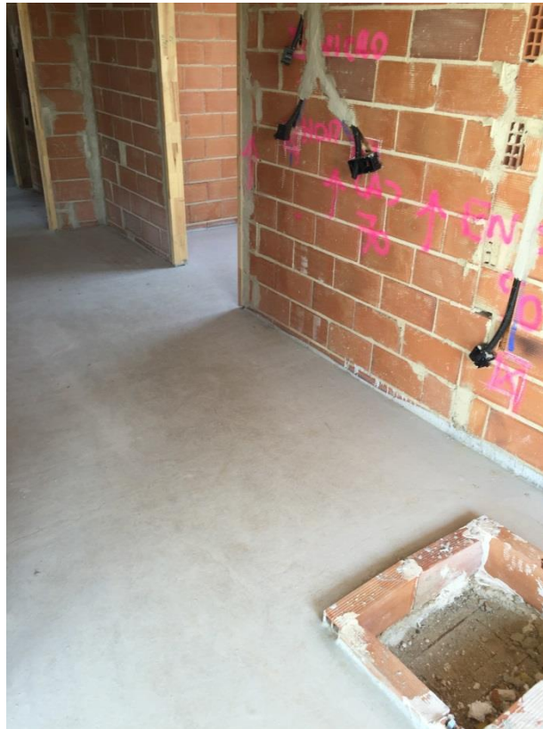
1.33 Mortero autonivelante de 4cm.
