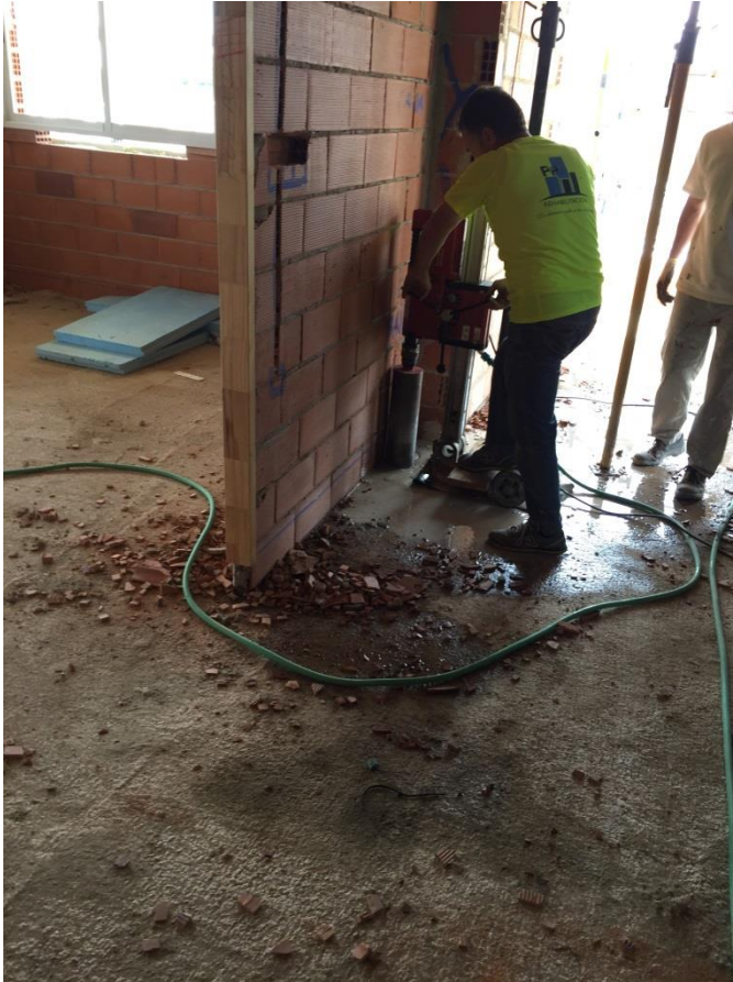
1.25 Perforación en el forjado sanitario.
