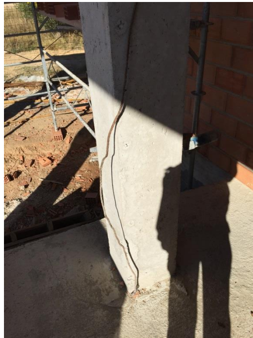
1.14 Comprobación de la toma de tierra.
