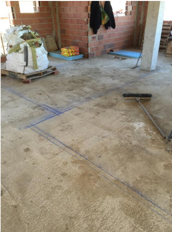
1.17 Proceso de replanteo tabiquería interior. Planta inferior.
