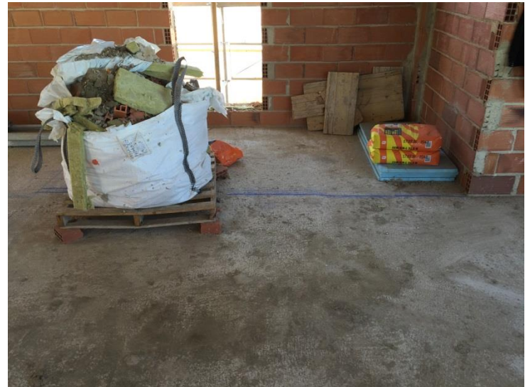
1.20 Mal acopio del escobro en la zona de replanteo.
