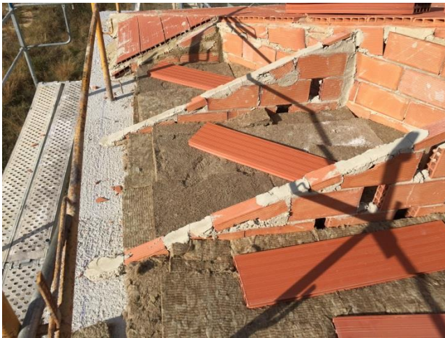
1.5 Vista de la de cubierta en la comprobación de ejecución.
