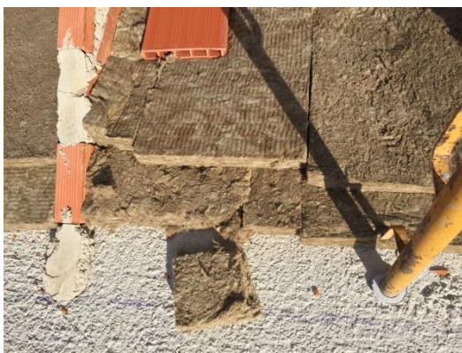
1.4 (Zoom) Vista de la de cubierta en la comprobación del espesor del aislamiento.
