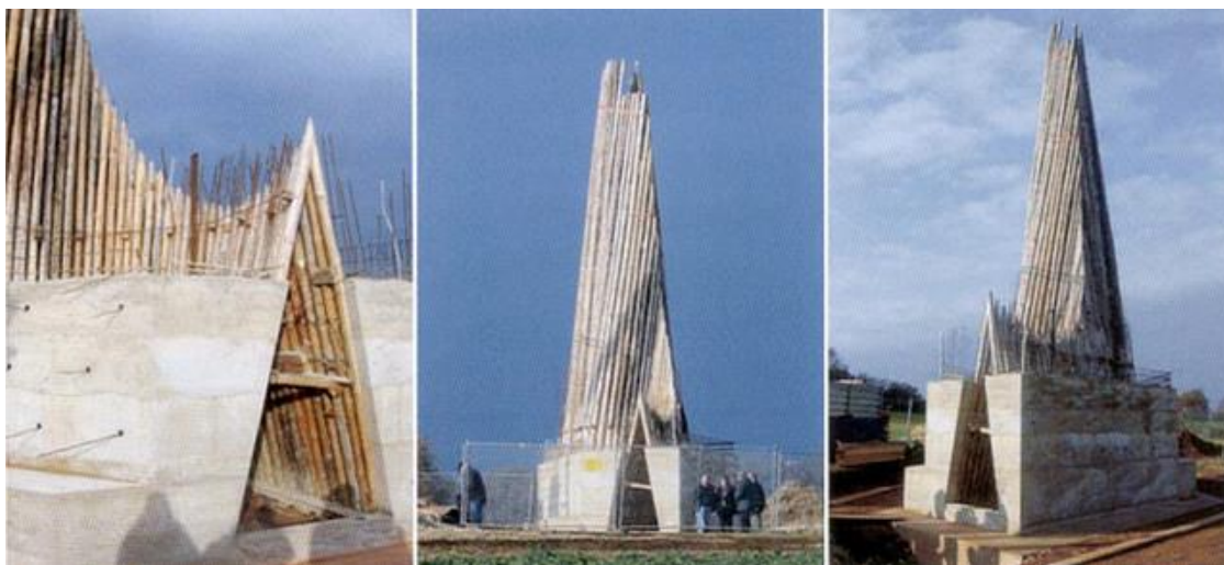
Ilustración 10: Durante su construcción. Tongadas de hormigón
