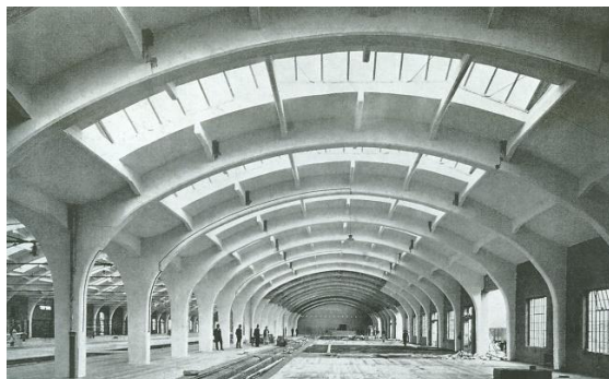
Ilustración 7: Hangar construido por Wayss & Freytag
