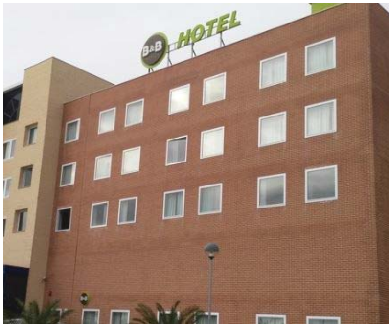
Ilustración 4-3. Fachada Sur-Este Hotel B&B. Fuente: Elaboración propia.
