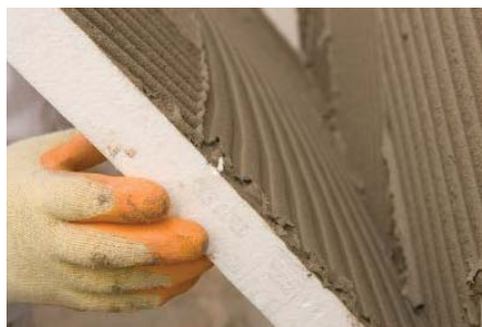
Ilustración 5-3. Montaje placas aislantes. Fuente: www.weber.es
