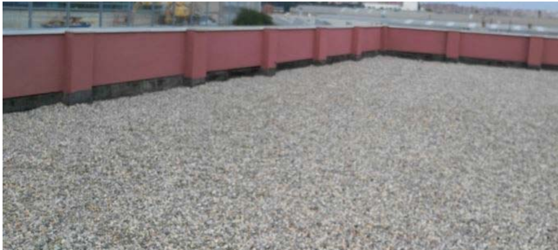
Ilustración 4-8. Cubierta 2 Hotel B&B. Fuente: Elaboración propia
