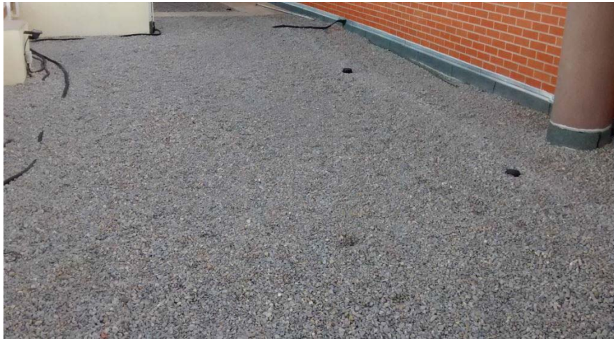
Ilustración 4-7. Cubierta 2 Hotel B&B. Fuente: Elaboración propia
