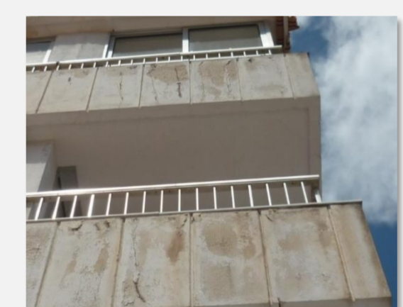
7. Aplacados de fachada en mal estado
