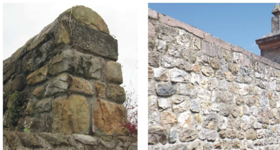
Imagen 21. Remates de muro acaballado y llano. 2006. Fuente: Propia
