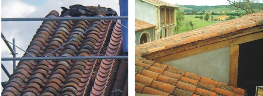
Imagen 45. Colocación de teja y aspecto conseguido. 2006. Fuente: Propia.
