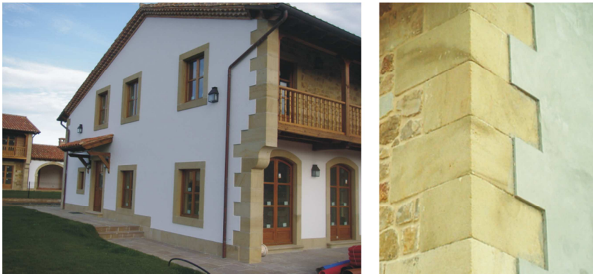
Imagen 35. Detalle del revoco en hastial. 2006. Fuente: Propia.
