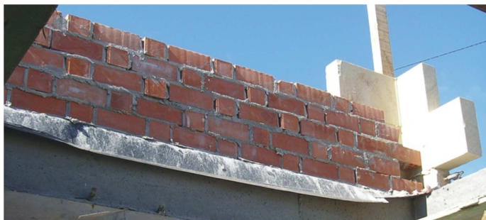
Imagen 34. Arranque de fachada en planta primera. 2006. Fuente: Propia.
