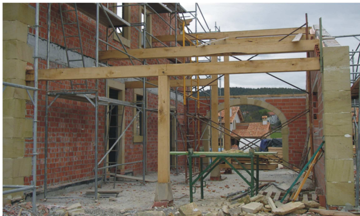
Imagen 46. Estructura de madera en anexo. 2006. Fuente: Propia.
