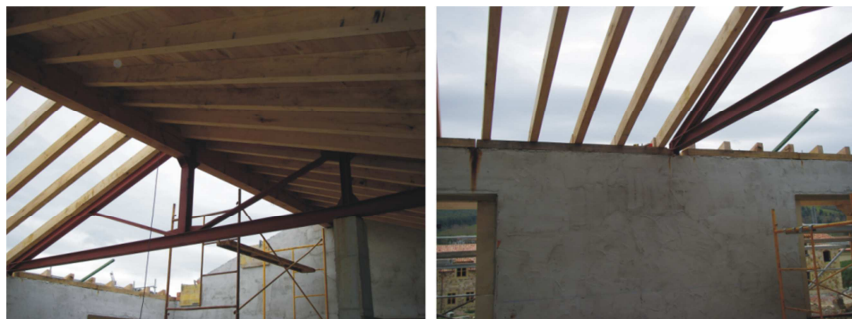
Imagen 25. Detalles de cercha metálica.2006.Fuente: Propia.
