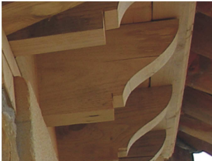
Imagen 32. Moldura y rebaje de canecillos. 2006. Fuente: Propia.
