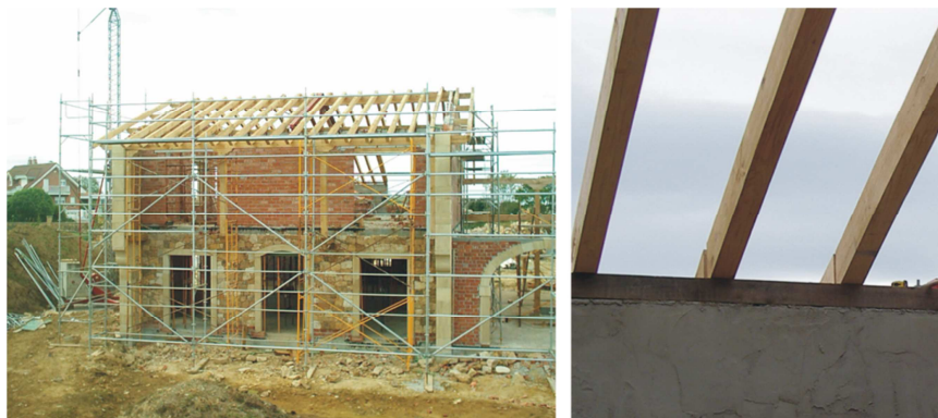
Imagen 26. Estructura de cubierta. 2006. Fuente: Propia.
