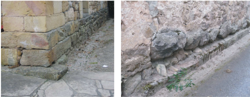
Imagen 9. Detalles de cimentación con piedra. 2016. Fuente: Propia.
