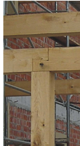
Imagen 47. Detalle de encuentro de vigas sobre poste. 2008. Fuente: Propia
