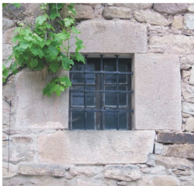
Imagen 13. Recercado de ventanuco en piedra.2006. Fuente: Propia.
