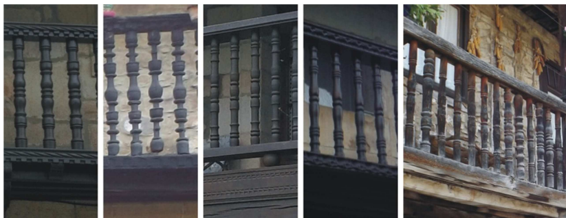
Imagen 20. Diferentes tornos en balaustres. 2016. Fuente: Propia.
