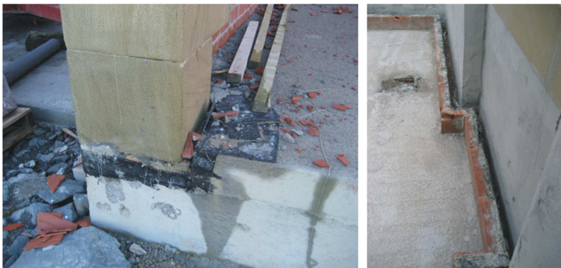
Imagen 33. Detalles de impermeabilización en arranque de fachada. 2006. Fuente: Propia.
