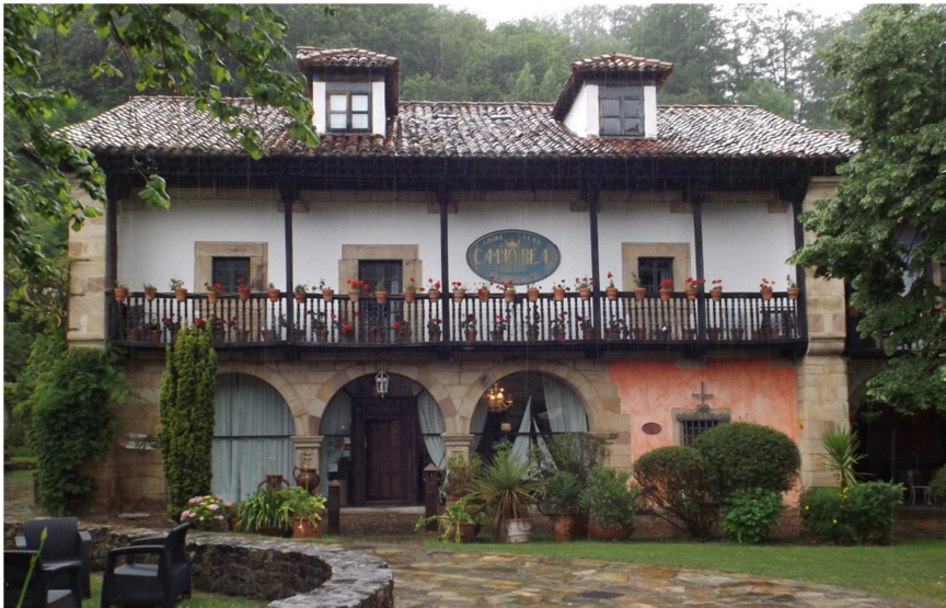
Imagen 3. Casona montañesa. 2016. Fuente: Propia.
