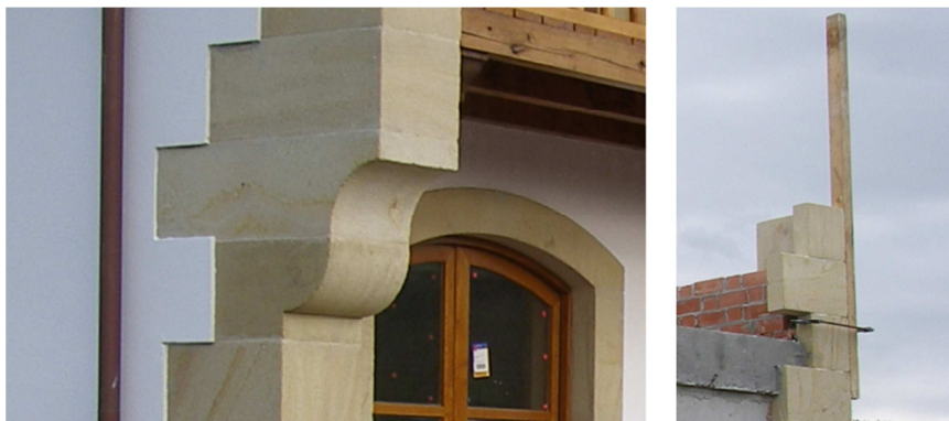
Imagen 28. Moldura en gola y esquinales. 2006. Fuente: Propia.
