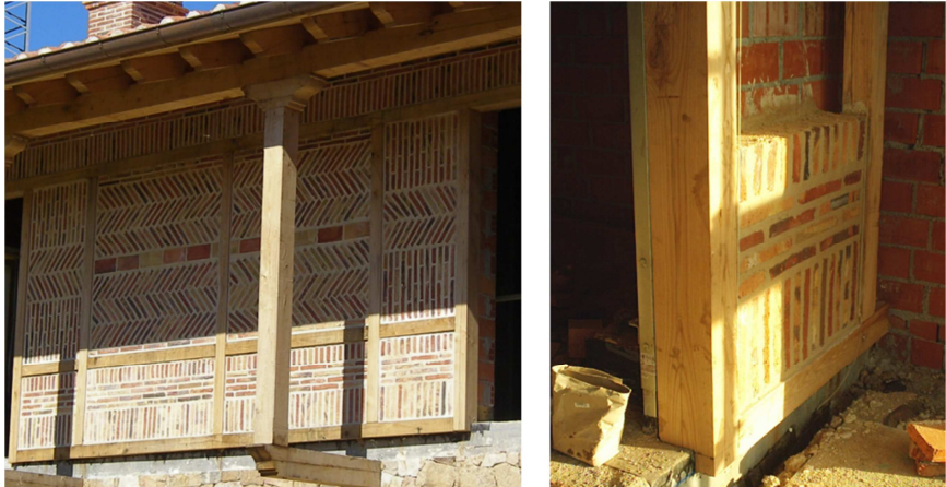
Imagen 39. Detalles de entramado de madera. 2006. Fuente: Propia.
