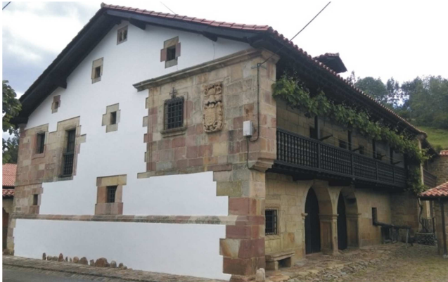
Imagen 11. Sillería a media fachada en muro lateral. 2016. Fuente: Propia.
