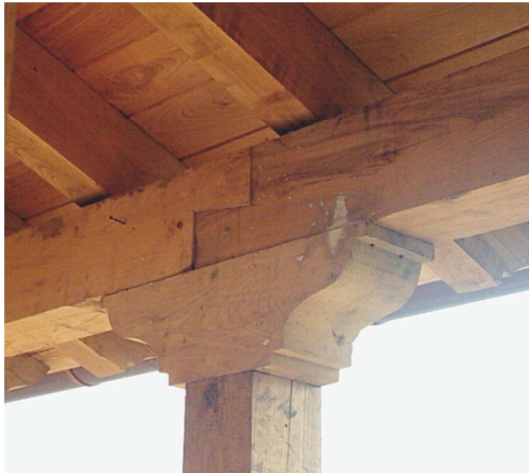
Imagen 47. Detalle de encuentro de vigas sobre poste. 2008. Fuente: Propia
