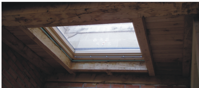
Imagen 48. Hueco para ventana en tejado. 2006. Fuente: Propia.
