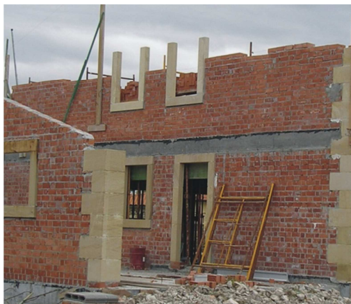
Imagen 36. Colocación de recercados. 2006. Fuente: Propia.
