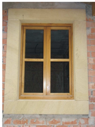
Imagen 36. Colocación de recercados. 2006. Fuente: Propia.
