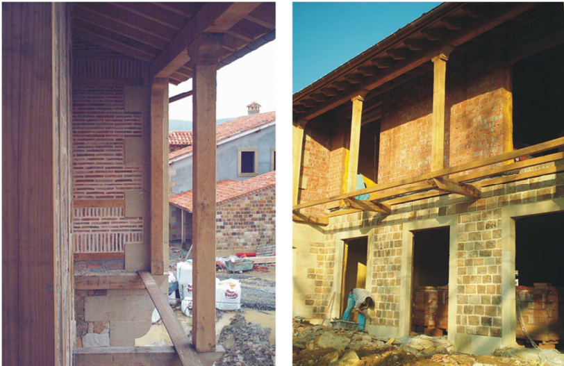
Imagen 41. Detalles de formación de solana. 2006. Fuente: Propia.
