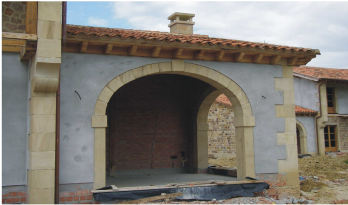
Imagen 29. Arco carpanel de piedra. 2006. Fuente: Propia.
