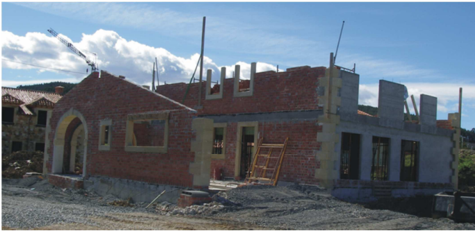
Imagen 24. Distintos muros de carga.2006. Fuente: Propia
