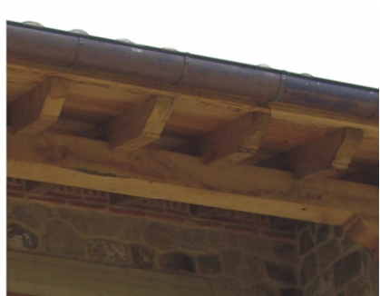
Imagen 32. Moldura y rebaje de canecillos. 2006. Fuente: Propia.
