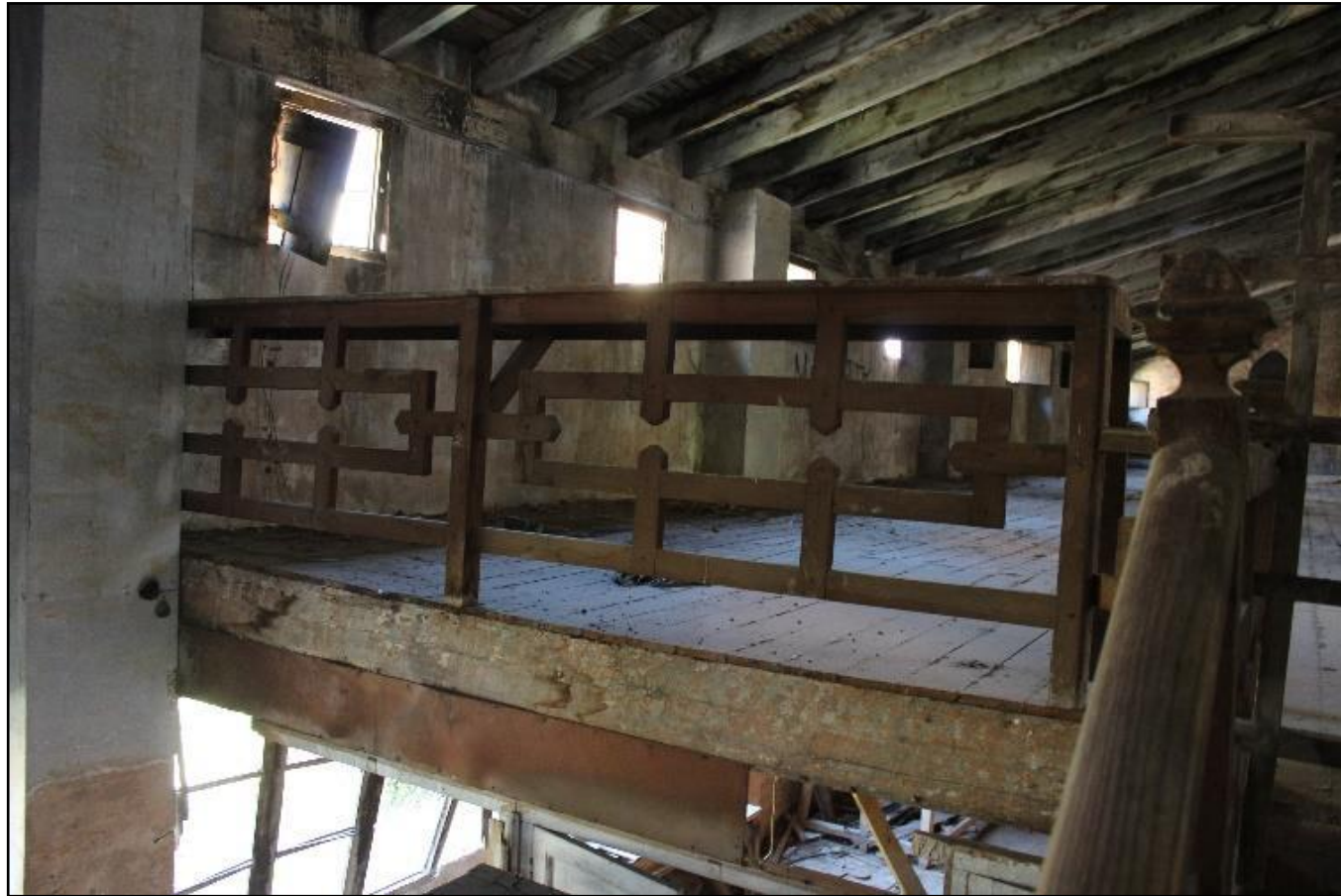
Ilustración 68 Barandilla escalera Fuente: Propia
