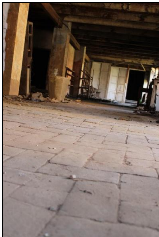
Ilustración 88 Solado P.Baja Fuente: Propia
