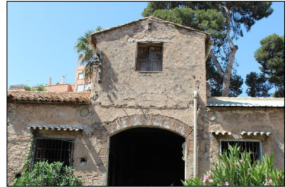
Ilustración 118 Distinción cubierta intervenida Fuente: Propia
