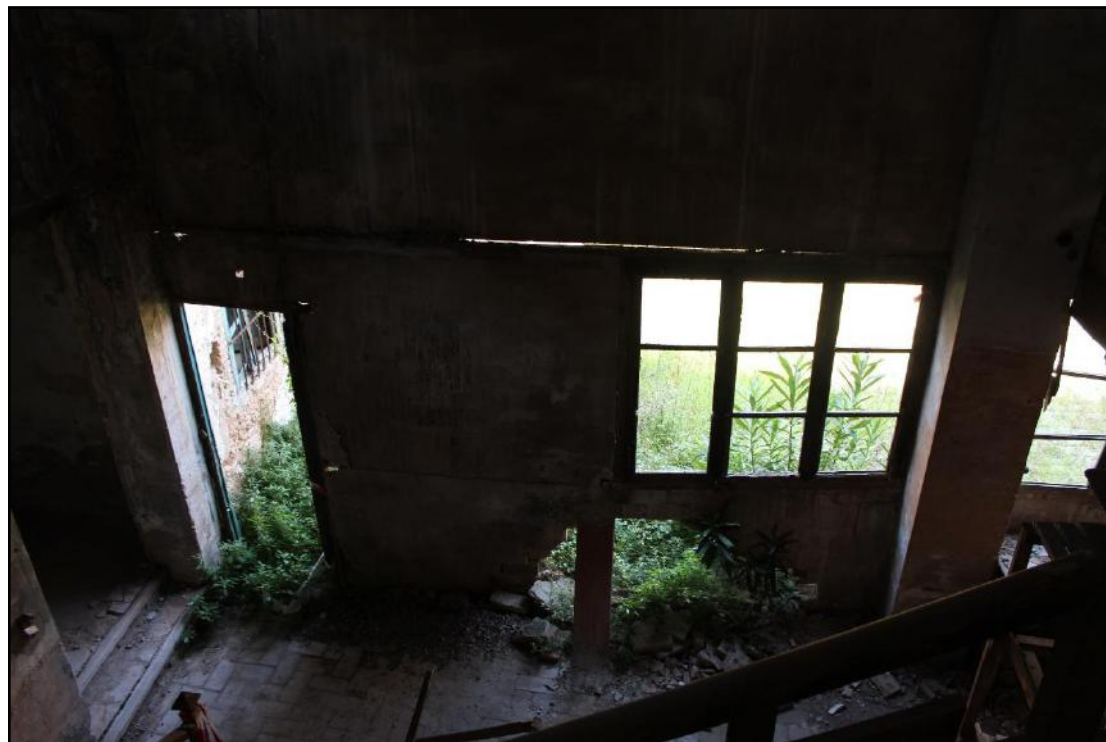
Ilustración 106 Grieta horizontal Fuente: Propia
