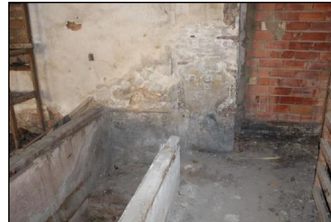
Ilustración 61 Acceso a escalera sótano Fuente: Propia
