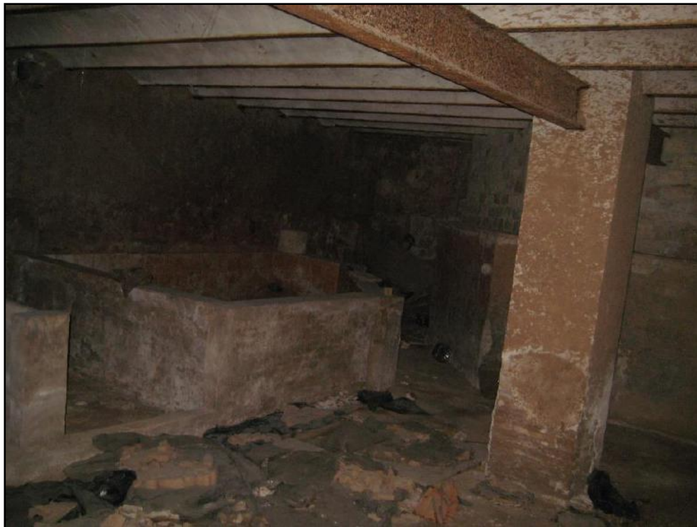
Ilustración 110 Forjado sótano Fuente: Propia
