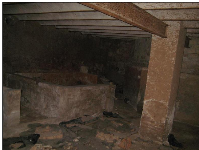
Ilustración 79 Forjado Sótano Fuente: Propia
