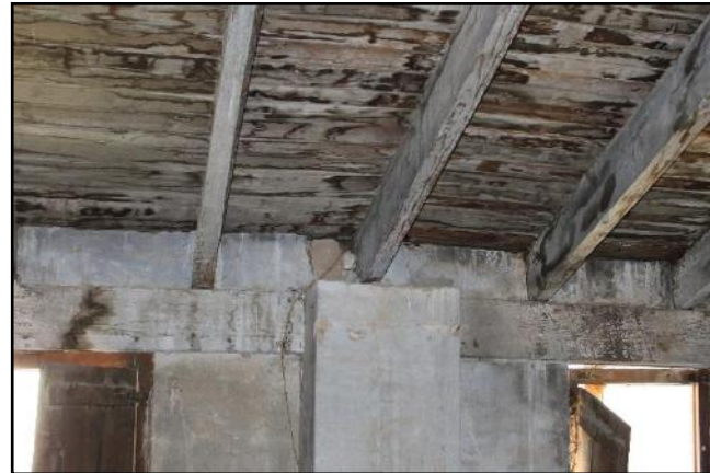
Ilustración 83 Encuentro Viga-Vigueta cubierta Fuente: Propia
