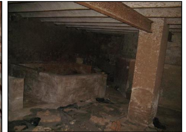
Ilustración 62 Sótano Fuente: Propia
