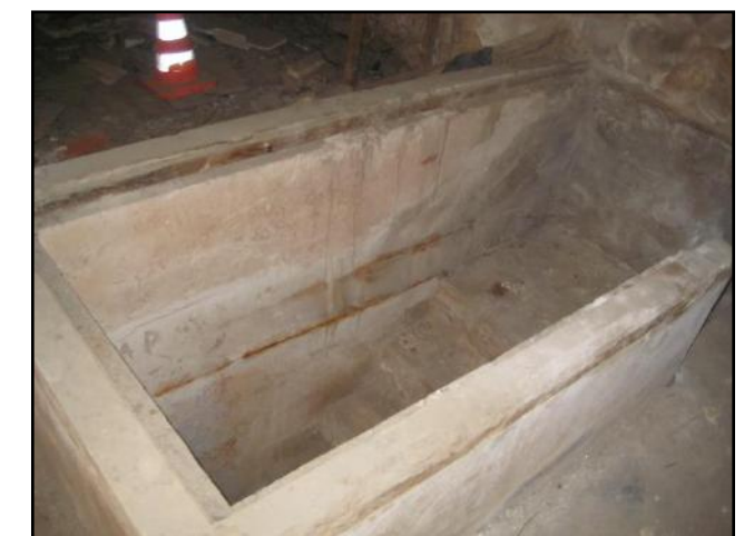
Ilustración 90 Entrada a escalera sótano Fuente: Propia
