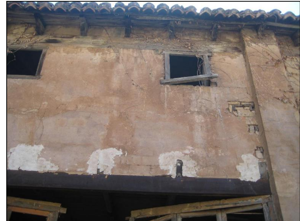
Ilustración 109 Intervenciones en viguetas Fuente: Propia
