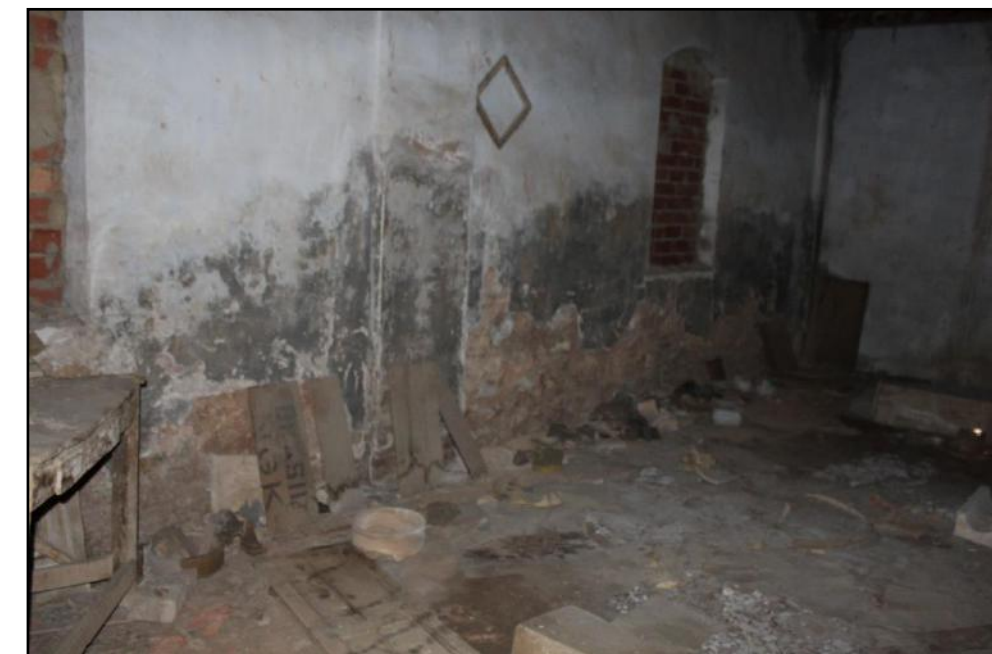
Ilustración 100 Paramento cuarto húmedo Fuente: Propia
