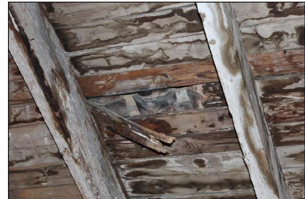
Ilustración 116 Rotura de listones Fuente: Propia
