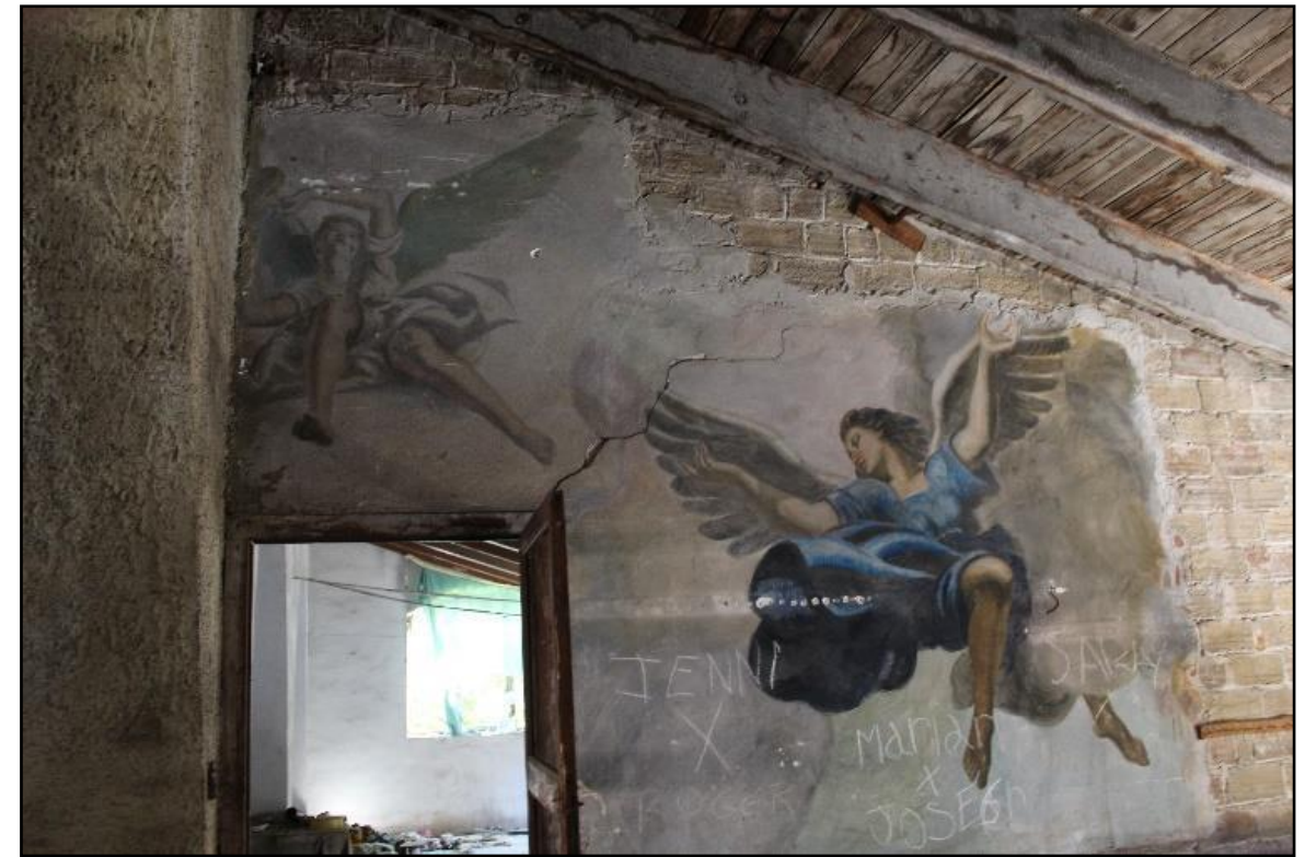
Ilustración 69 Pintura en paramento Fuente: Propia
