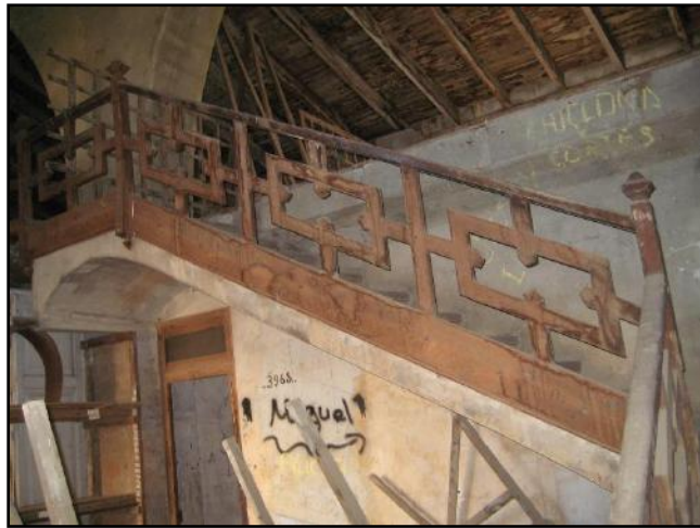
Ilustración 93 Escalera P.Primer Fuente: Propia
