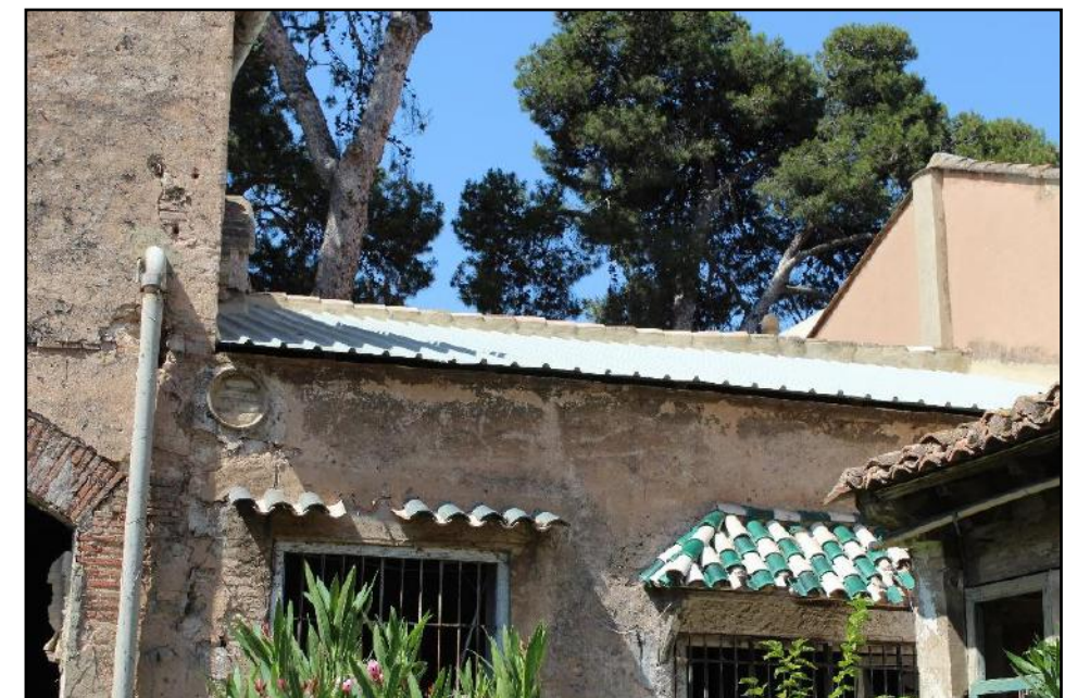
Ilustración 119 Cubierta intervenida Fuente: Propia
