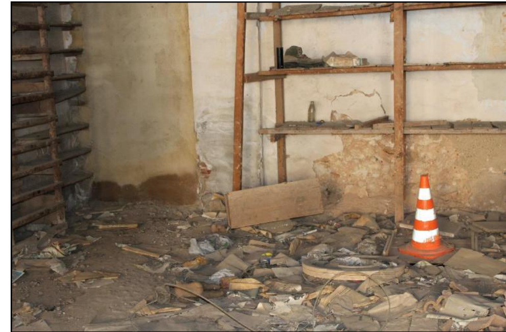
Ilustración 99 Paramento Fuente: Propia
