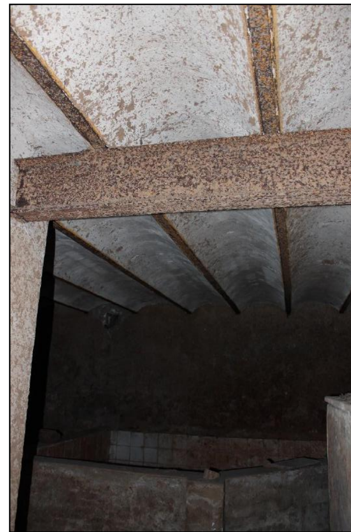
Ilustración 78 Forjado de sótano Fuente: Carmen Cárcel
