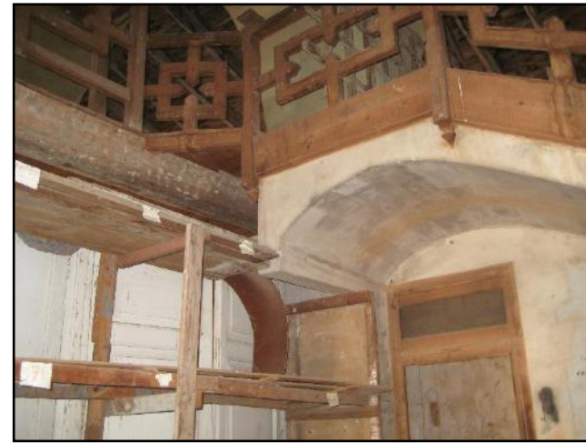
Ilustración 94 Escalera Fuente: Propia
