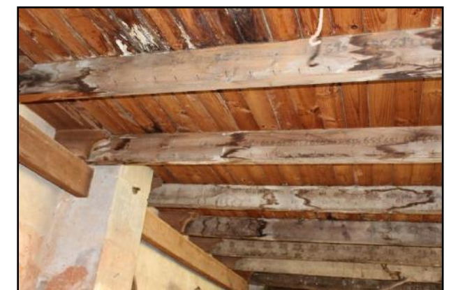
Ilustración 82 Forjado planta 1ª Fuente: Propia
