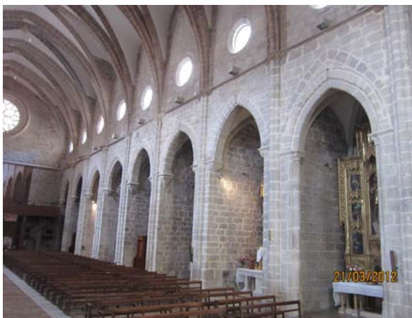
VISTA INTERIOR DE LAS CAPILLAS ENTRE CONTRAFUERTE
