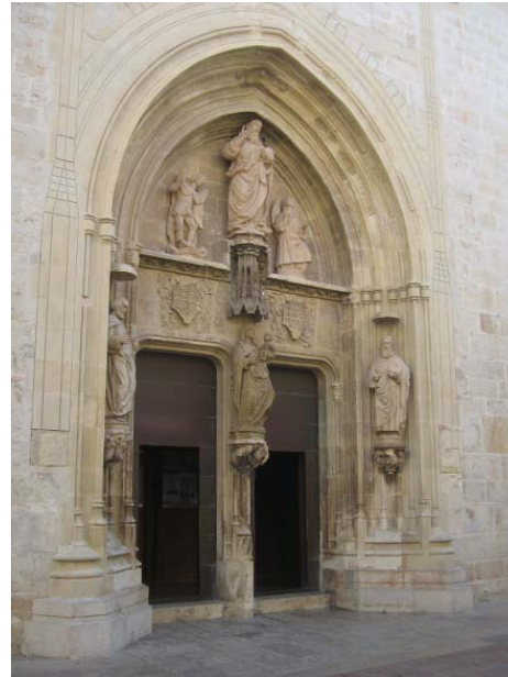
ACTUAL PUERTA DE LOS APÓSTOLES
