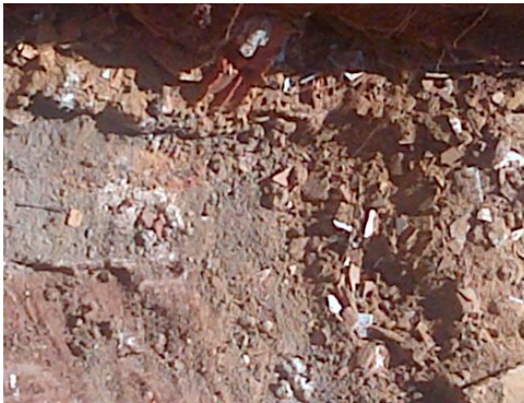
Ilustración 50. Foto Terreno Excavado para Cimentación.
