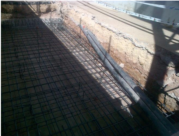
Ilustración 48. Foto Cimentación Escalera Exterior.
