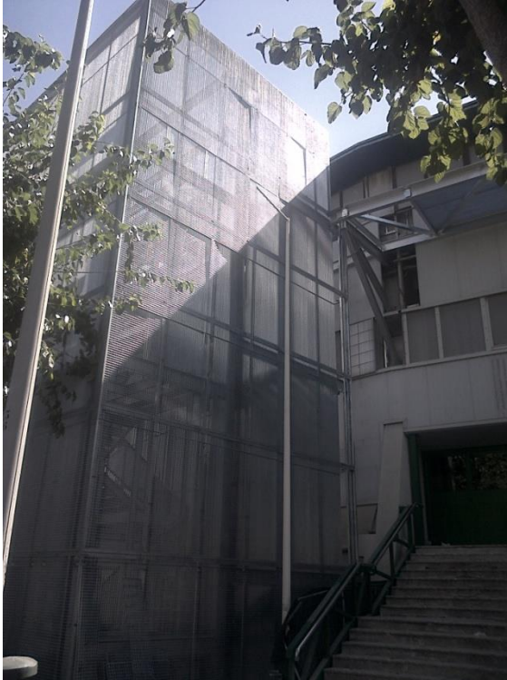
Il·lustració 58. Foto Revestiment de Tramex Metàlic Vertical.
