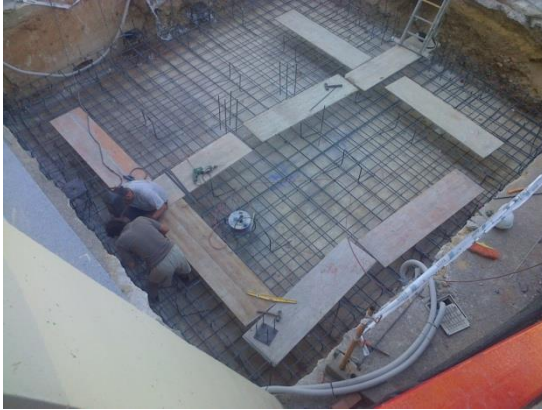
Ilustración 51. Foto Colocación del Acero en Cimentación.
