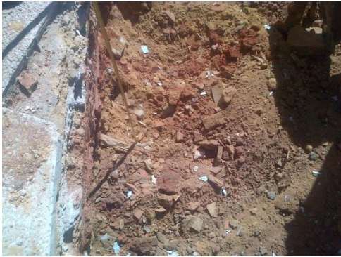
Ilustración 49. Foto Excavación de Cimentación.
