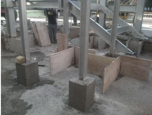
Ilustración 54. Foto Arranque de Pilares de Estructura Metálica.
