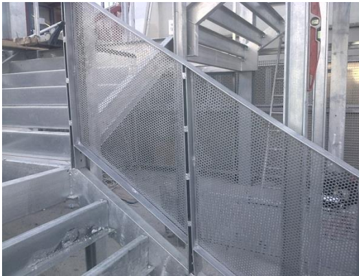
Ilustración 56. Foto de Zancas de Escalera y Barandilla.
