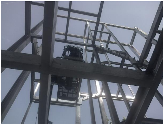
Ilustración 57. Foto Ejecución Estructura Metálica.
