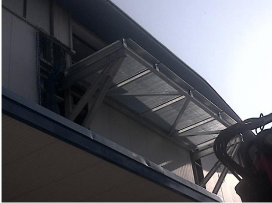
Il·lustració 60. Foto Unió Pasarela Metàlica con Estructura de Hormigón.
