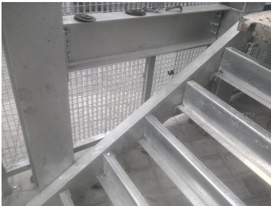
Ilustración 55. Foto de Zancas de Escalera.
