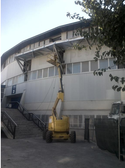
Il·lustració 63. Foto Pasarela Metàlica.
