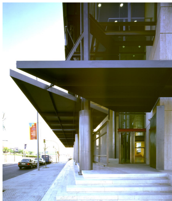
FOTO 2 Acceso Teosrería Sevilla
