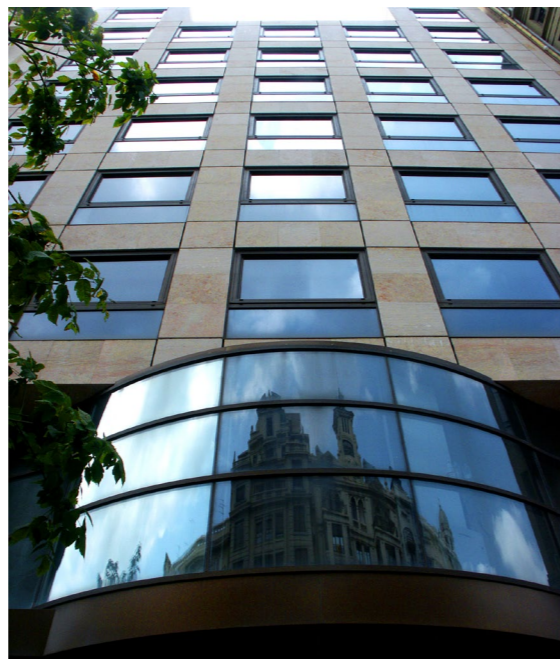
FOTO 1 Acceso del Edificio REX 1999, Valencia Proyecto de oficinas de Antonio Escario, de aspecto moderno pero relacionado con los edificios antiguos colindantes
