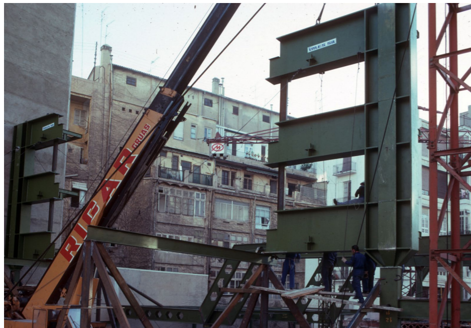
Anexo 1.3. Sede Promobanc, puesta en obra de las vigas de gran canto Cortesía del despacho
