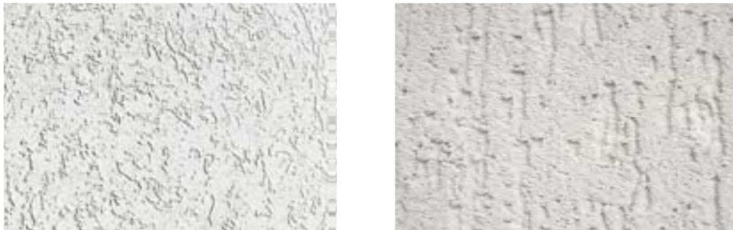
Imagen 74. Textura de un revoque acanalado remolinado y acanalado vertical.
