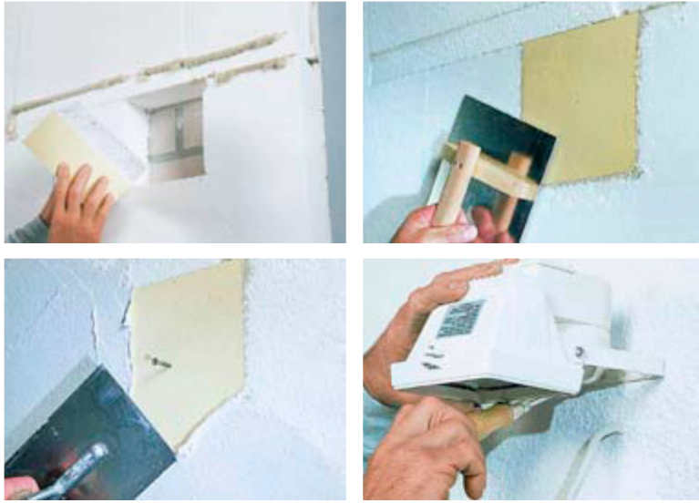
Imagen 83. Instalación de un elemento de fijación para una carga pesada.
