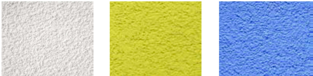
Imagen 73. Textura de un revoque rascado.
