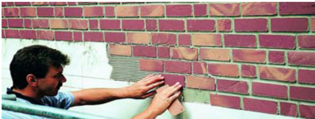
Imagen 79. Detalle de la instalación de un acabado de ladrillo sobre un SATE.
