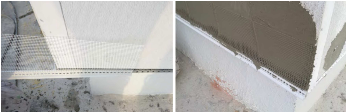
Imagen 60. Colocación perfil de arranque (izda) y posterior capa de mortero adhesivo (dcha).
