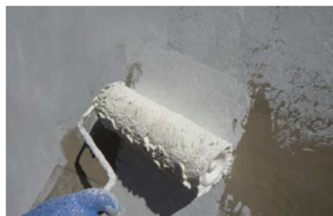
Imagen 72. Fotografía aplicación imprimación con rodillo.
