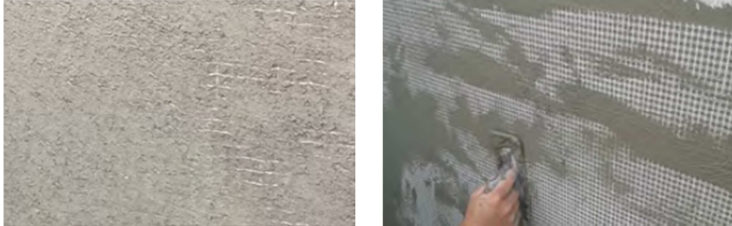
Imagen 68. Vista de la cuadrícula de la malla una vez seca la capa base de mortero.
