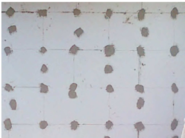
Imagen 46. Fotografía de la instalación de espigas en un edificio. Imagen 47. Sección constructiva de la instalación de una espiga.
