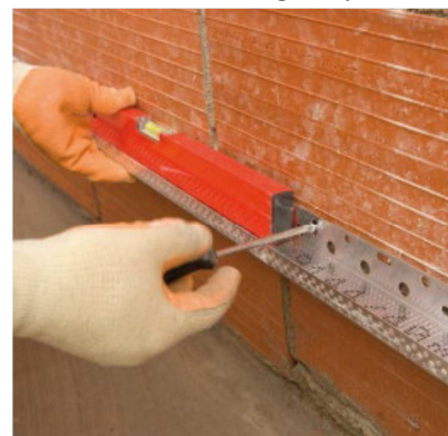
Imagen 11. Nivelación y atornillamiento a la base de los perfiles guía.
