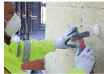
Imagen 18. Aplicación práctica del proceso de anclaje de las fijaciones mecánicas tipo espiga o roseta.
