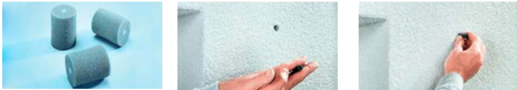
Imagen 84. Detalle de una tapa de anclaje y su correcta colocación.
