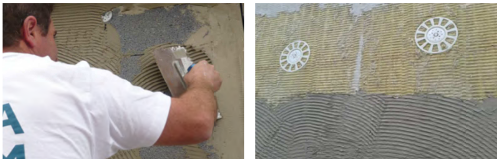
Imagen 65. Aplicación del mortero adhesivo sobre los paneles aislantes con llana dentada.
