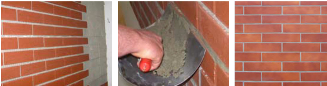
Imagen 78. Detalle de la instalación de un acabado de aplacado imitando ladrillo cara vista.
