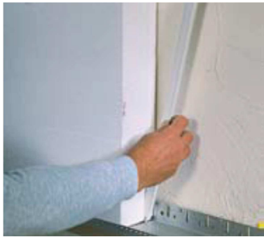
Imagen 53. Fotografía de la instalación de los listones de unión.
