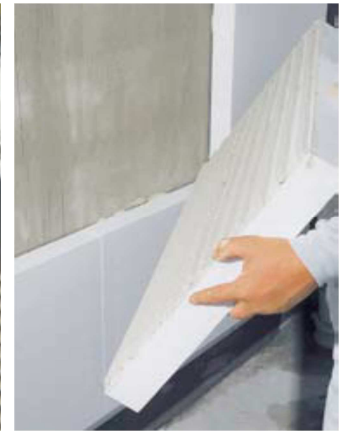
Imagen 14 y 15. Solución para jambas y dinteles.
