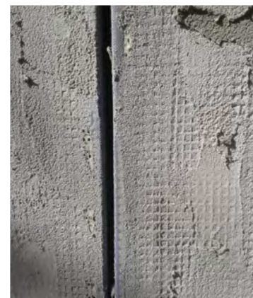
Imagen 64. Junta de dilatación
