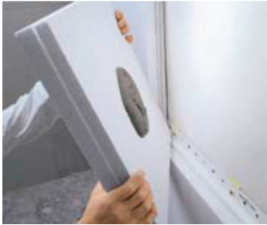
Imagen 52. Fotografía del pegado de los paneles aislantes.
