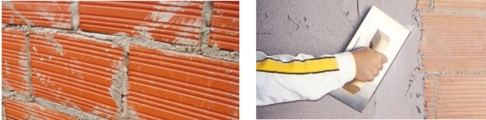
Imagen 28 y 29. Preparación del soporte
