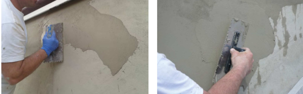
Imagen 70. Aplicación de segunda capa de mortero con llana lisa.
