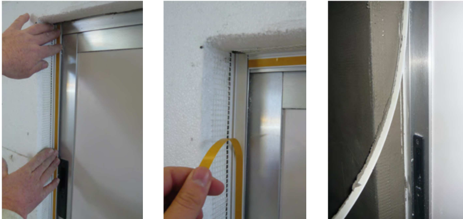
Imagen 62. Colocación perfil en el marco de la ventana.
