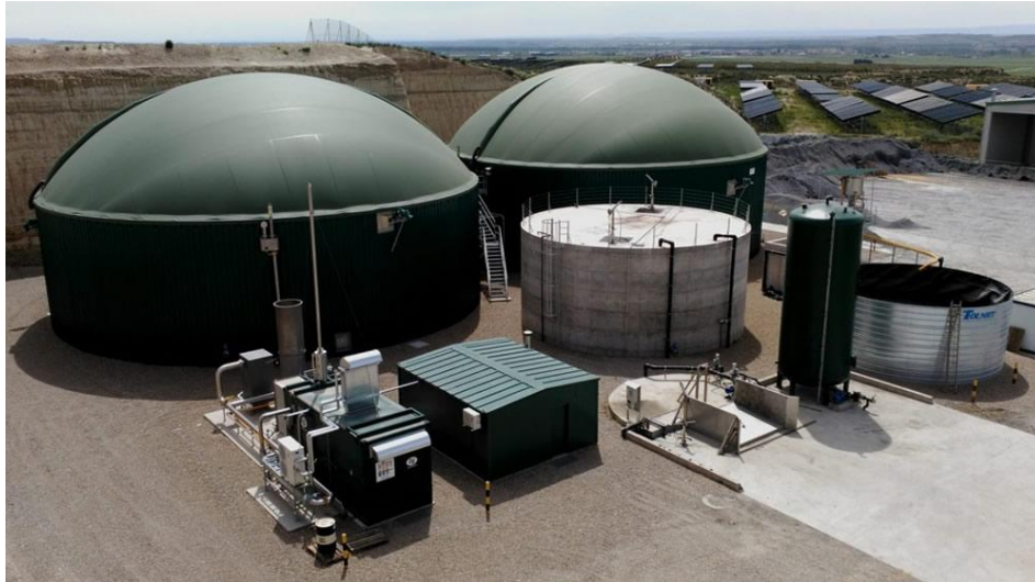
Figura 7. Planta de co-digestión anaerobia anexa a un complejo dedicado al compostaje. Está situada en la provincia de Zaragoza. (Fuente: Sitio web empresa Ecobiogas).
