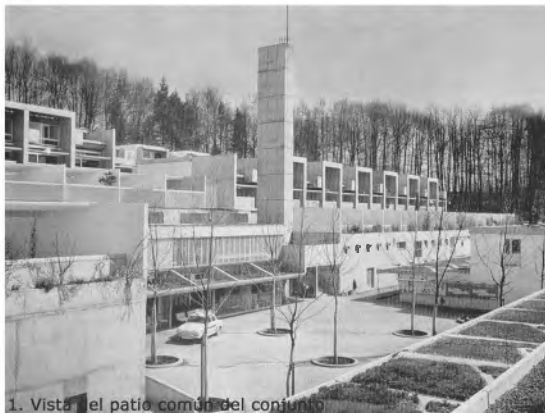
1. Vista del patio común del conjunto
