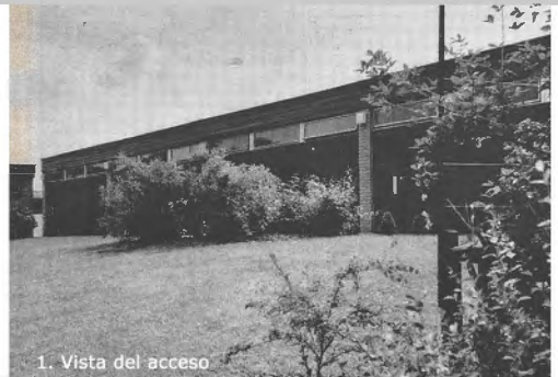
1. Vista del acceso
