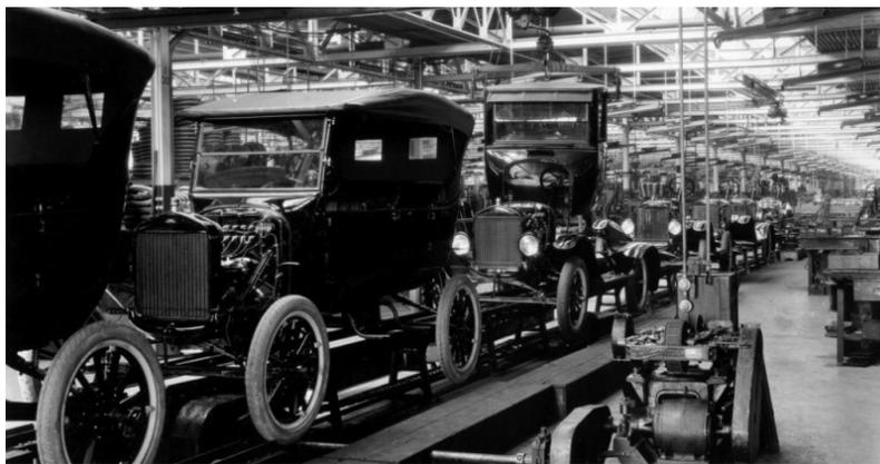
Ilustración 10. Cadena de montaje Ford Motor Company. Fuente: efemotor. (EFE MOTOR, 2013)
