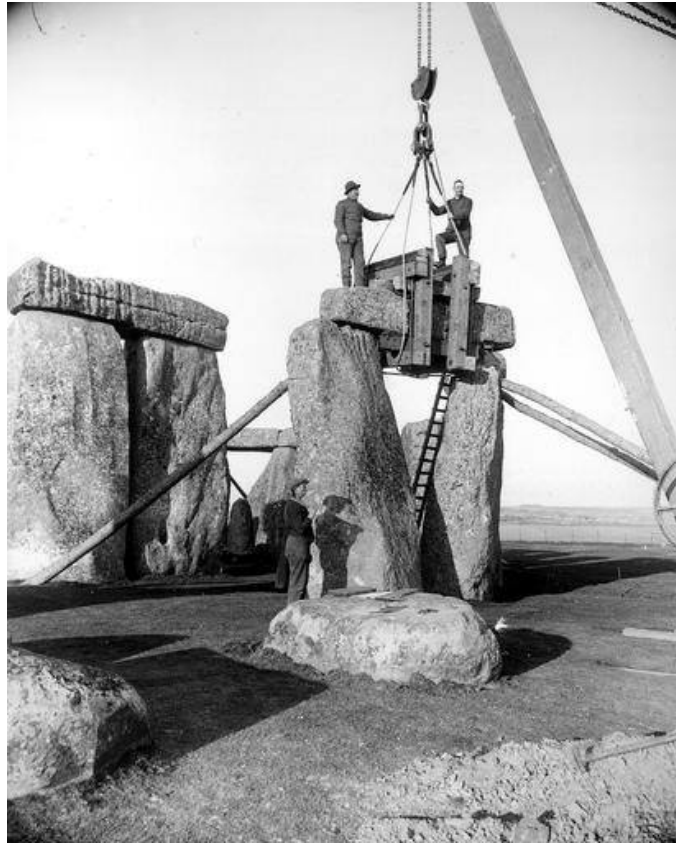
Fig. 15. La primera de las caídas de piedras documentada es la de enero de 1797 cuando se derrumbó un trilito. Desde entonces, la inestabilidad del monumento ha preocupado a todas las generaciones, llevándose a cabo trabajos de estabilización mediante puntales de madera. Además de la intervención de 1901, se realizó otra de gran envergadura en 1919 y que supuso la retirada de los puntales al estabilizar las piedras con hormigón. Finalmente, en 1958 se elevó el trilito caído en 1797.
