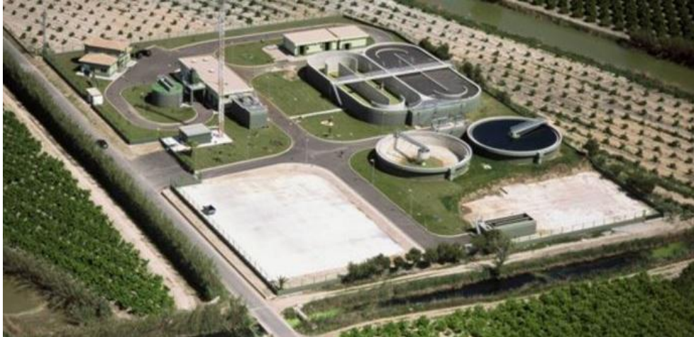
Figura 12: Imatge aèria de la instal·lació de la EDAR de Xeraco. Font: http://www.epsar.gva.es/instalaciones/edar.aspx?id=252
