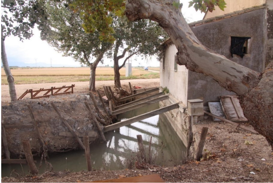
Ilustración 17: Motor y detalle de apuntalamiento
