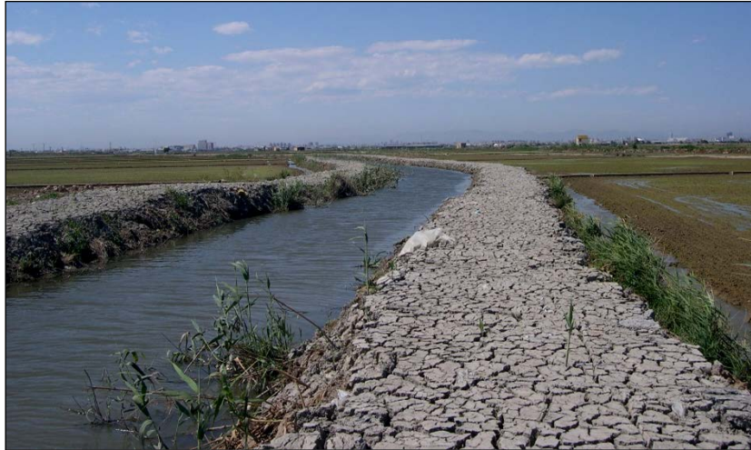
Ilustración 23: Detalle mota con material dragado. (COLLADO, 2010)
