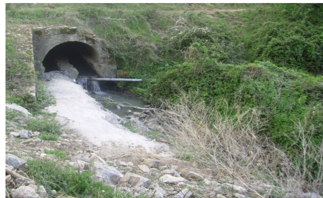
Localización y punto de vertido en el Barranco del Carraixet
