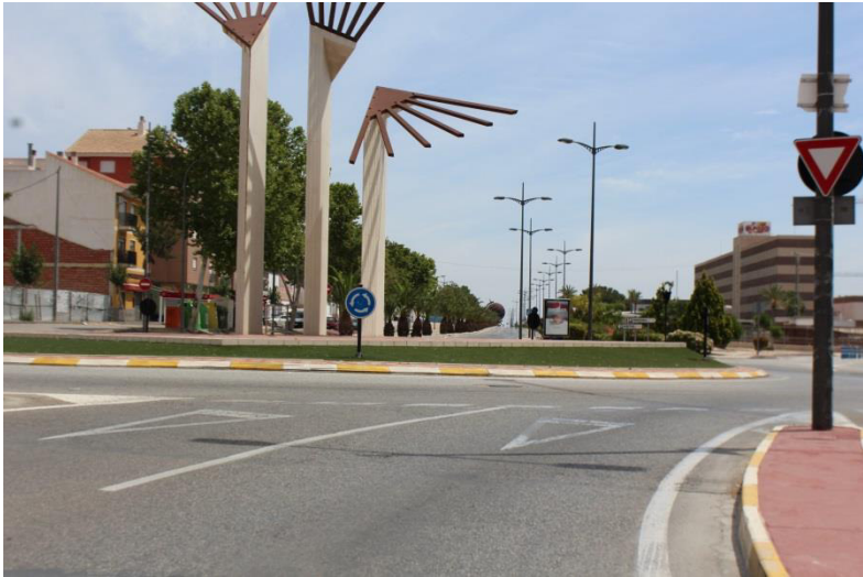
Figura 22. N-340 Alhama de Murcia. Fuente propia.
