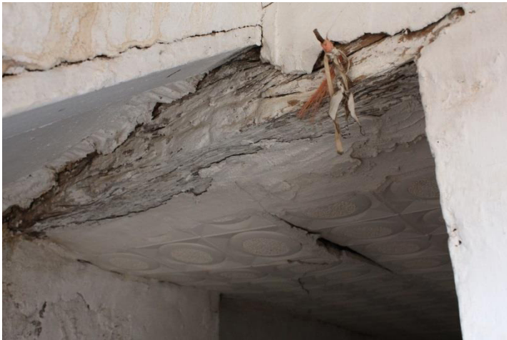
Figura 64 .Dintel de madera patio interior. Fuente propia.
