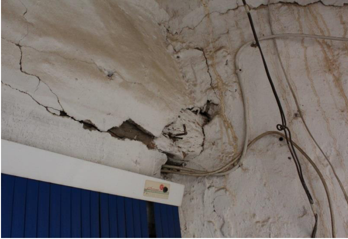
Figura 63 .Dintel de madera patio interior. Fuente propia.
