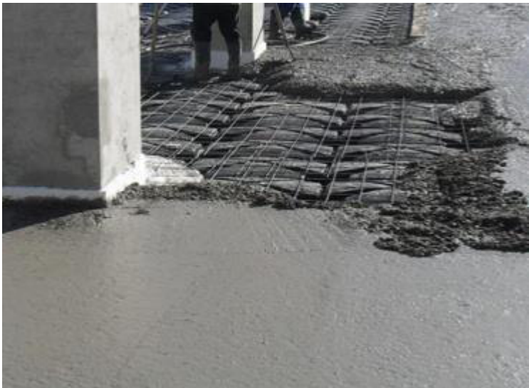
Figura 131 .Hormigonado solución Caviti. www.caviti.es
