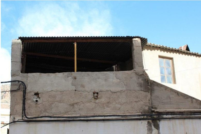
Figura 137. Pilares Primera Planta. Fuente propia.
