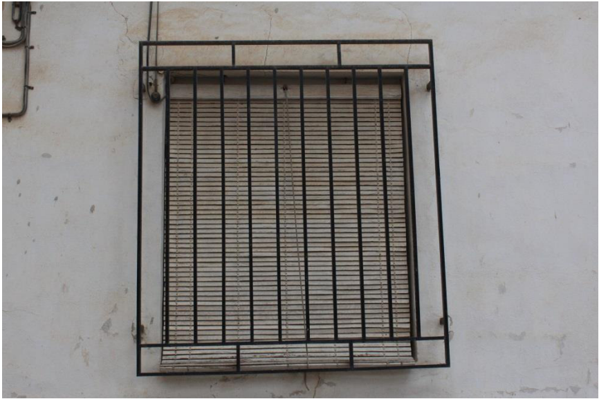
Figura 58. Rotura por dilatación y retracción térmica. Fuente propia.
