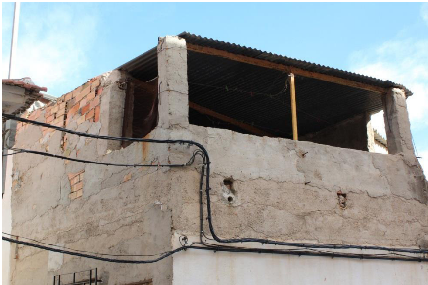
Figura 136. Pilares Primera Planta. Fuente propia.
