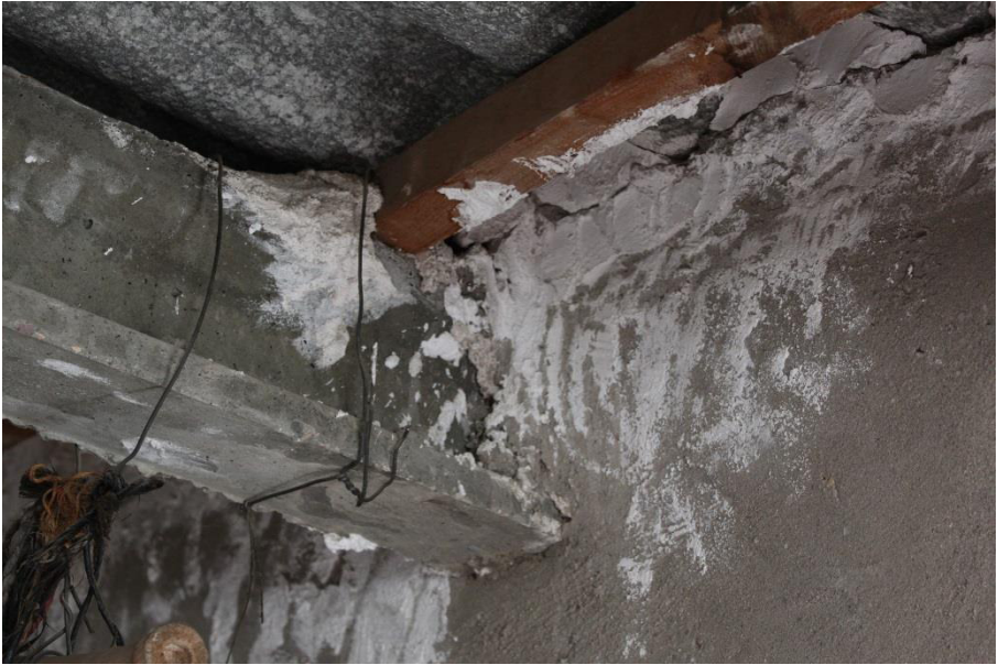
Figura 145. Encuentro con cerramiento vigueta planta primera. Fuente propia.
