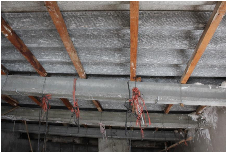
Figura 144. Encuentro con cerramiento vigueta planta primera. Fuente propia
