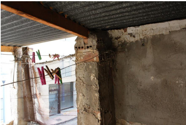
Figura 138. Pilares Primera Planta. Fuente propia.
