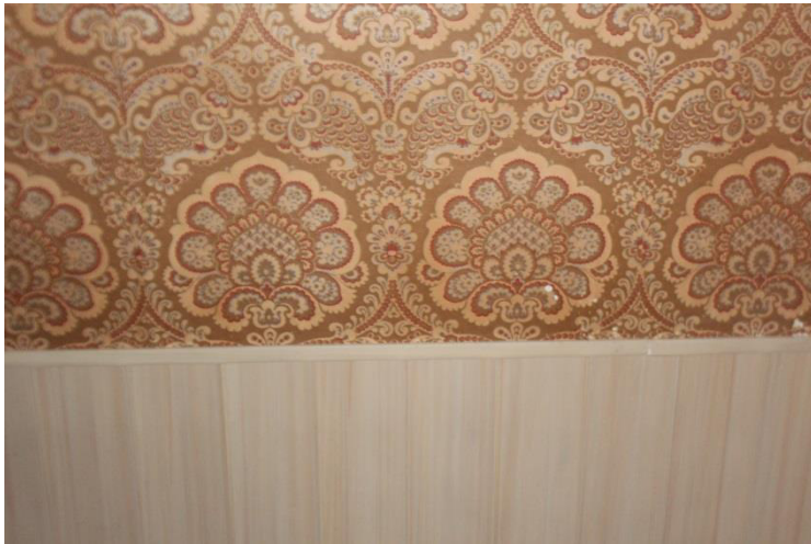
Figura 39. Revestimiento principal Vivienda a estudio. Fuente propia.
