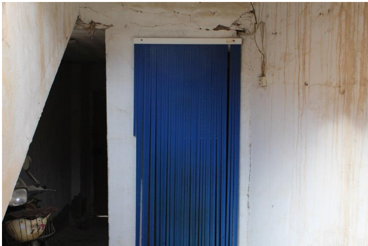
Figura 62 .Dintel de madera patio interior. Fuente propia.
