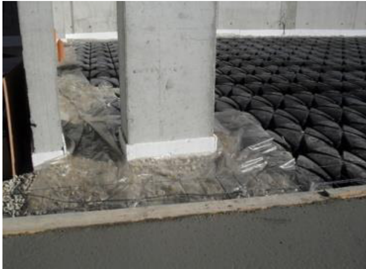
Figura 130. Hormigonado solución Caviti. www.caviti.es
