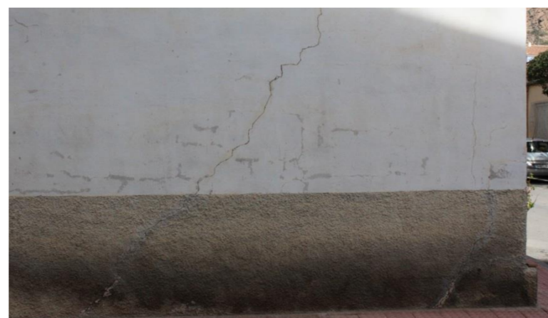
Figura 10. Arco de descarga en esquinas
