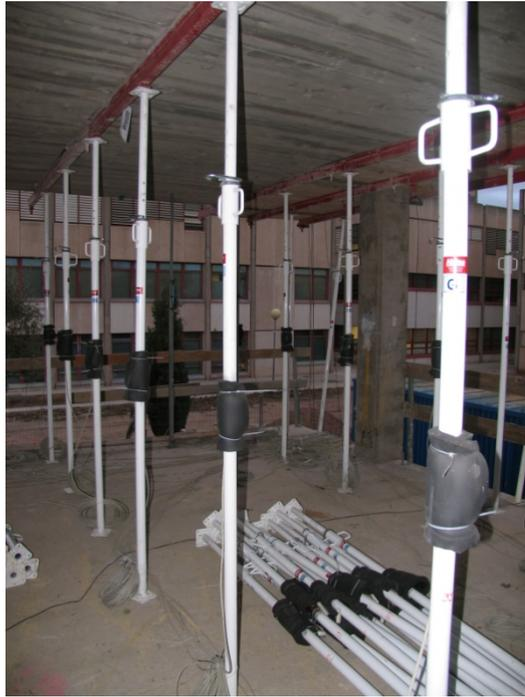
Fig. II.26 Clareado del forjado 2 (11/12/2006)
