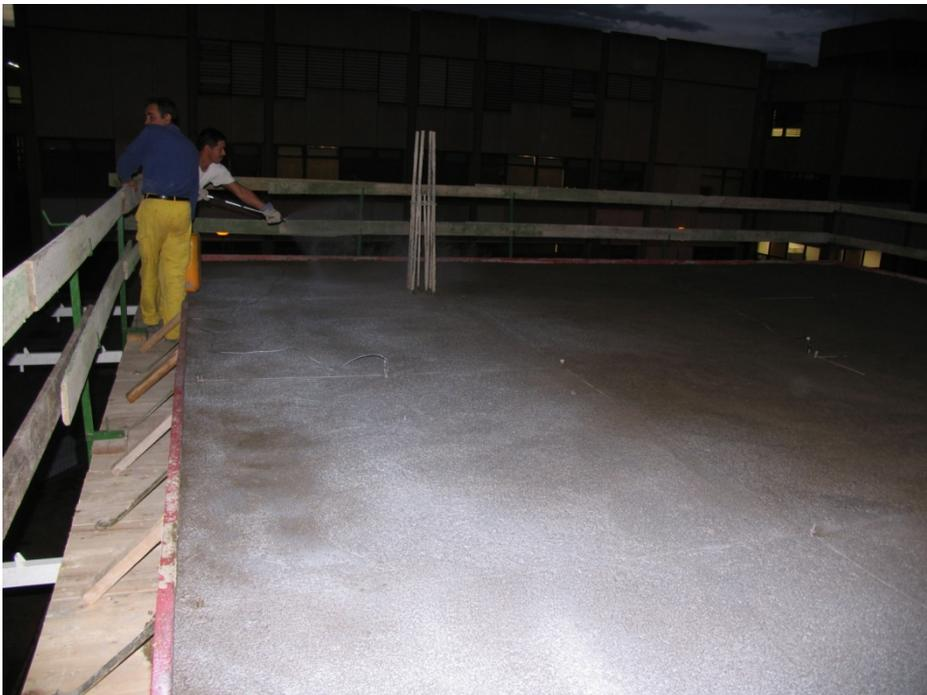
Fig. II.23 Curado del forjado 2 (05/12/2006)
