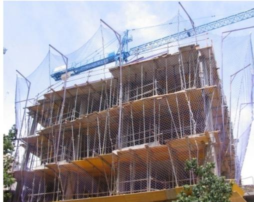
Fig. 2.5 Proceso de cimbrado y descimbrado
