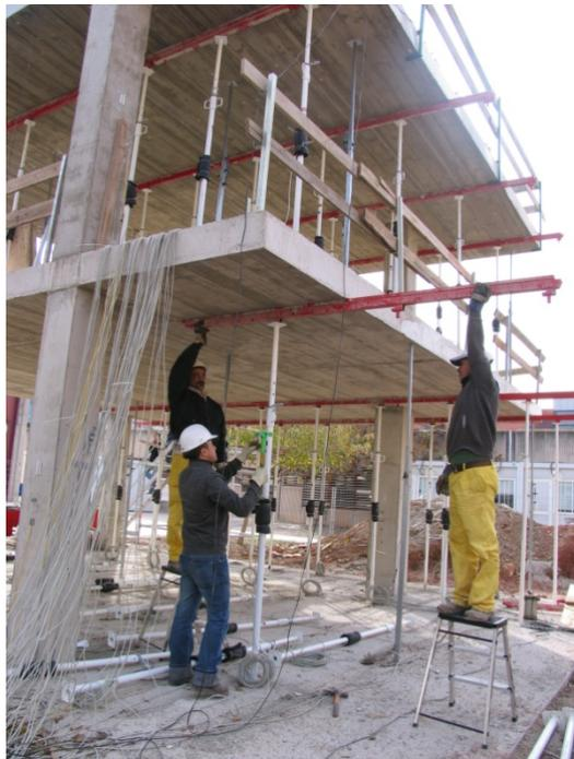
Fig. II.27 Descimbrado del forjado 1 (12/12/2006)
