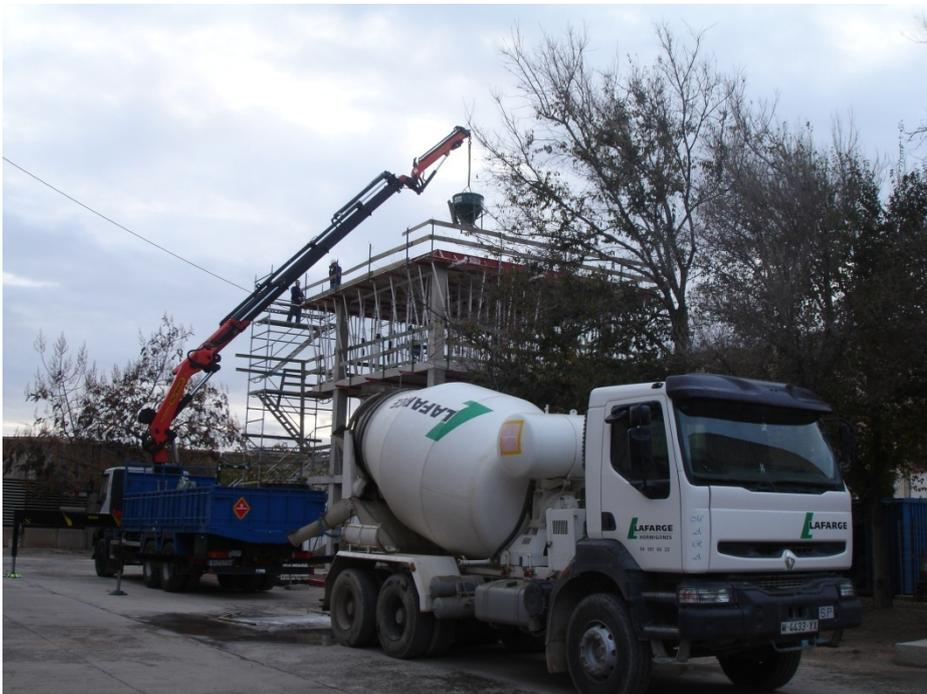
Fig. II.31 Hormigonado del forjado 3 (15/12/2006)
