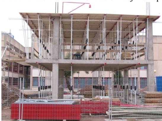
Fig. 2.7 Proceso de cimbrado, clareado y descimbrado
