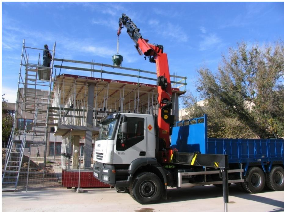
Fig. II.21 Hormigonado del forjado 2 (05/12/2006)
