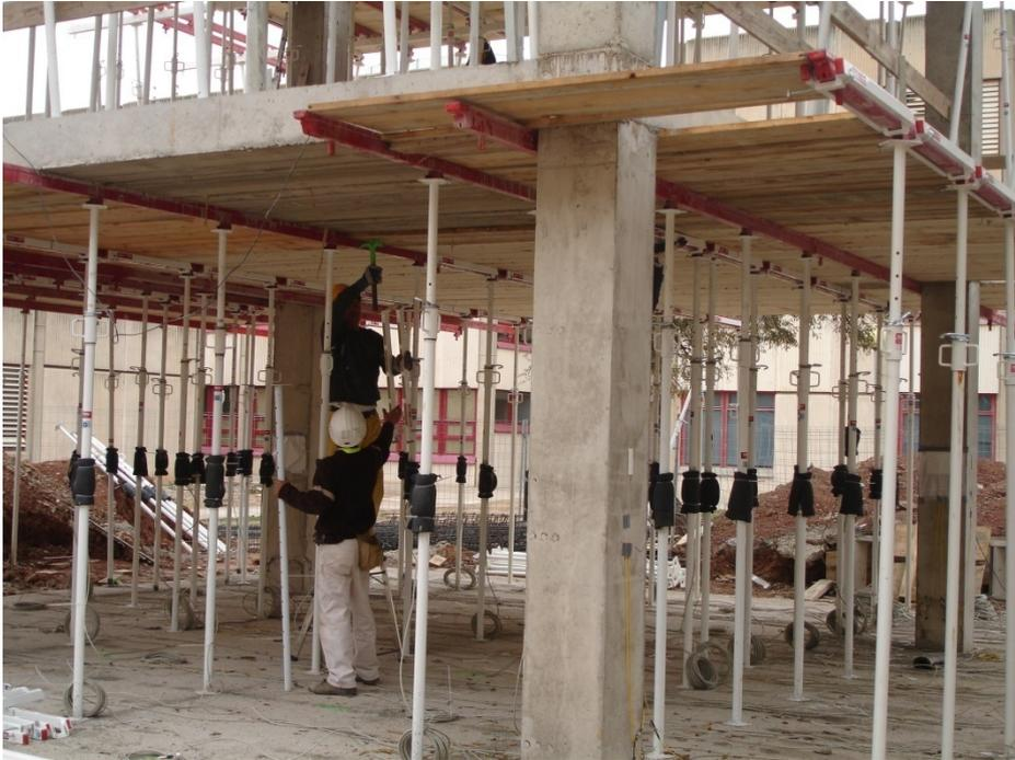
Fig. II.18 Clareado del forjado 1 (01/12/2006)
