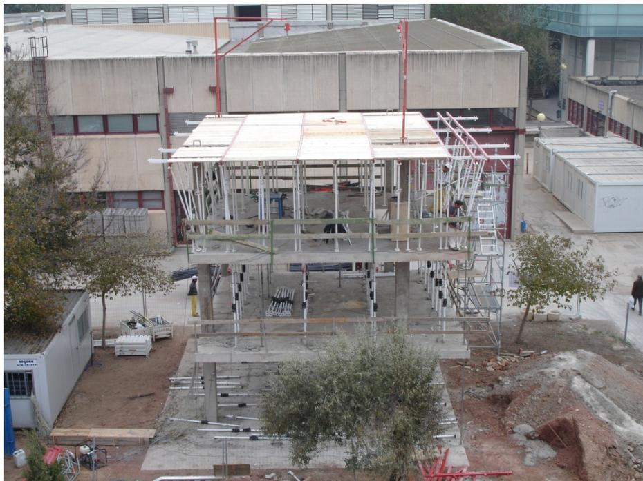
Fig. II.29 Instalación del sistema de cimbrado del forjado 3 (13/12/2006)
