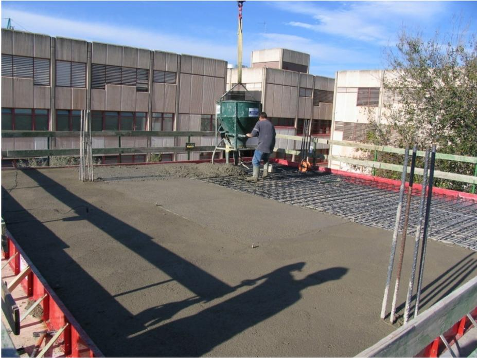
Fig. II.22 Hormigonado del forjado 2 (05/12/2006)
