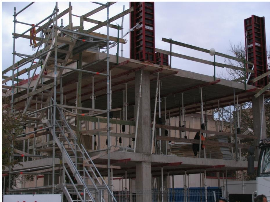
Fig. II.25 Clareado del forjado 2 (11/12/2006)
