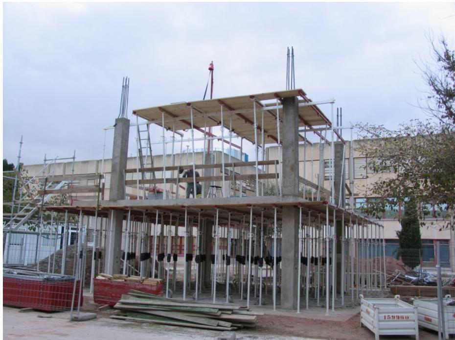
Fig. II.17 Instalación del sistema de cimbrado del forjado 2 (30/11/2006)
