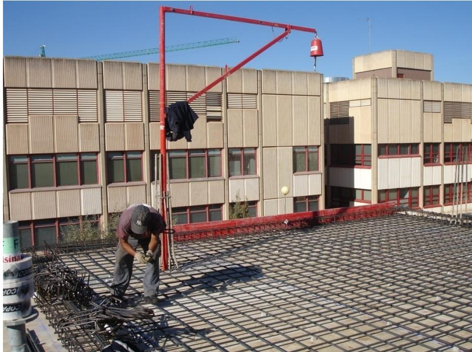
Fig. II.20 Armado del forjado 2 (04/12/2006)
