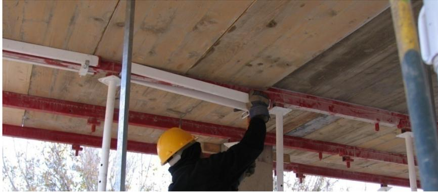
Fig. 3.14 Extracción del basculante de las sopandas principales
