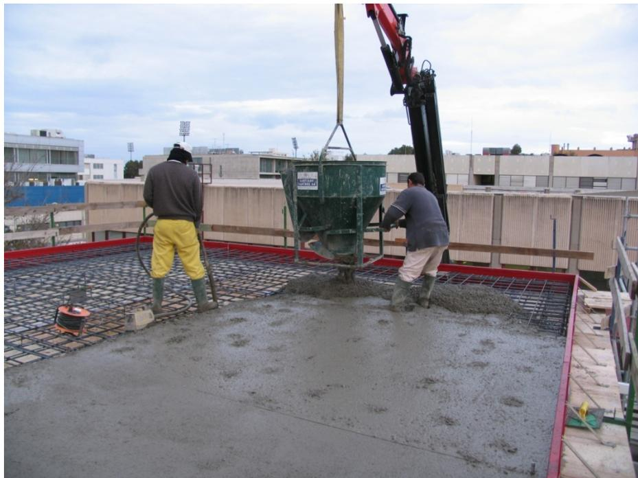
Fig. II.32 Hormigonado del forjado 3 (15/12/2006)
