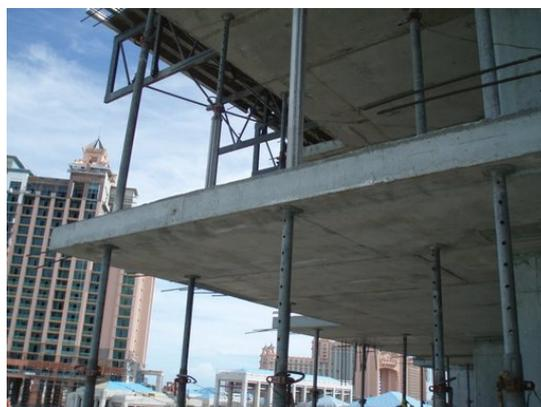
Fig. 2.6 Proceso de cimbrado, recimbrado, descimbrado
