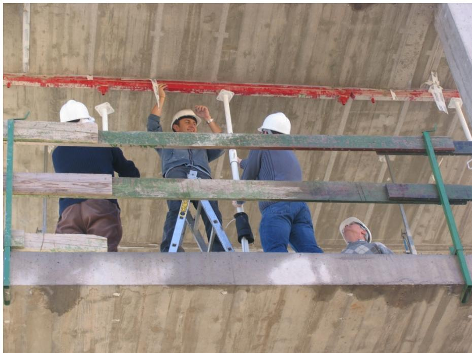
Fig. II.41 Descimbrado del forjado 2 (23/12/2006)
