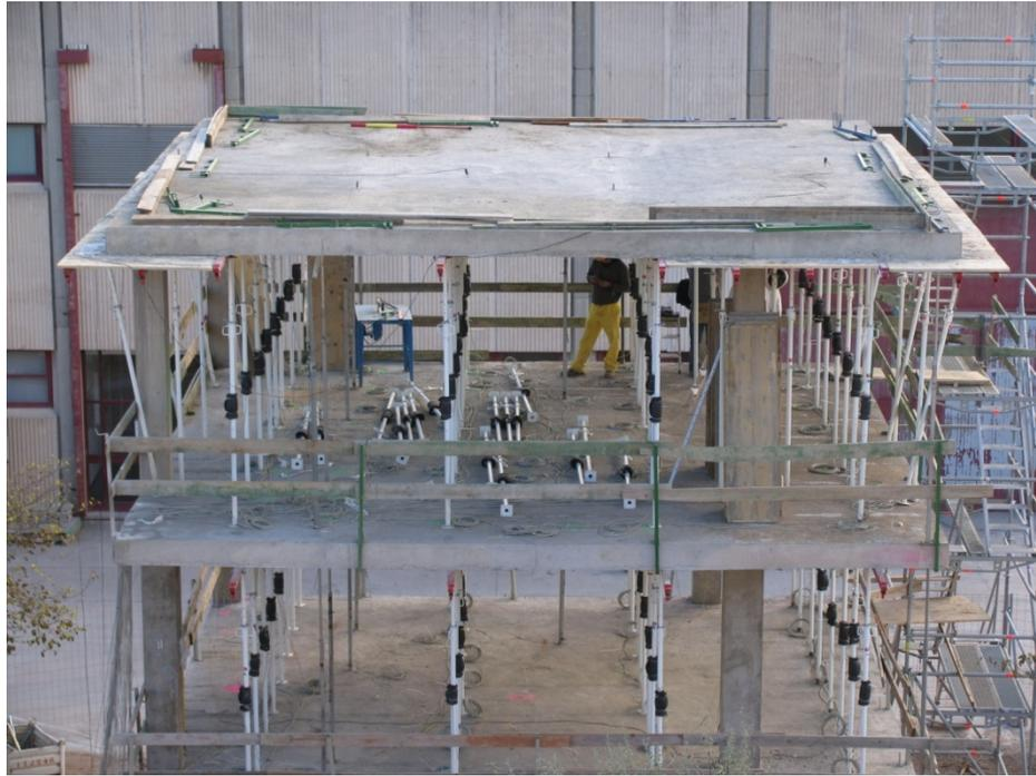
Fig. II.36 Clareado del forjado 3 (18/12/2006)
