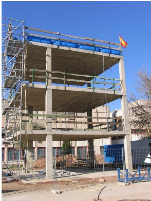
Fig. II.43 Descimbrado del forjado 3 (26/12/2006)
