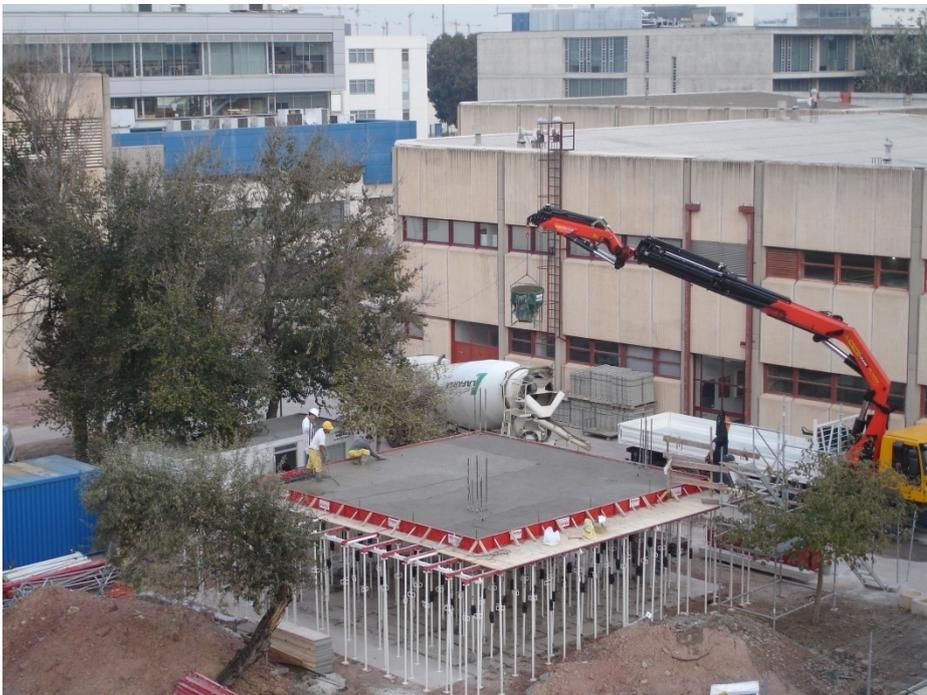
Fig. II.15 Hormigonado del forjado 1 (28/11/2006)
