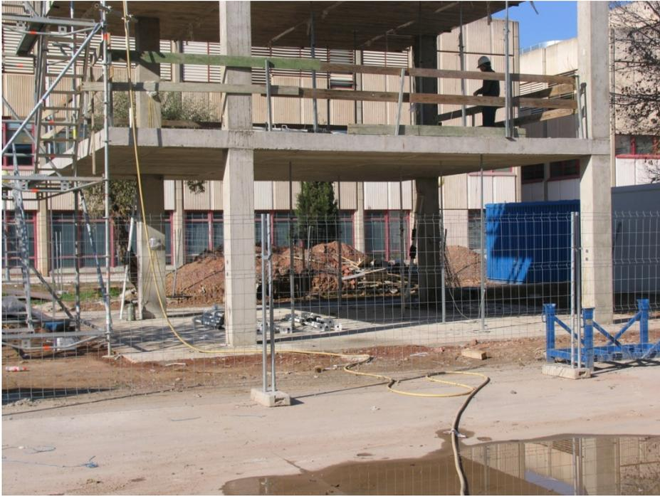
Fig. II.42 Descimbrado del forjado 2 (23/12/2006)
