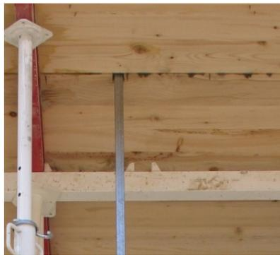
Fig. III.5 Tablero de encofrado perforado para montaje de pértiga
