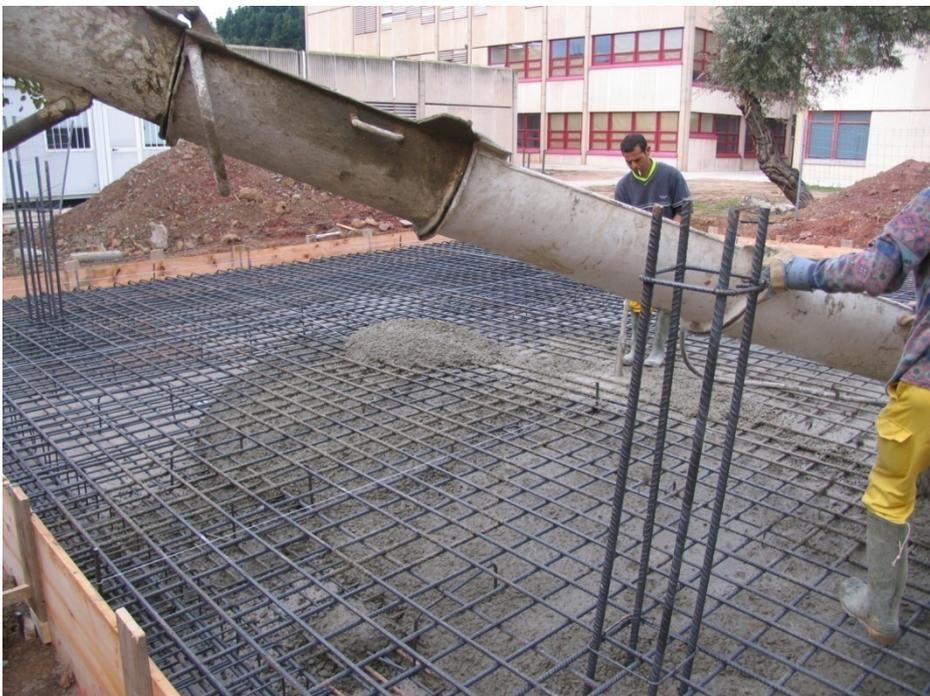
Fig. II.3 Hormigonado de la losa de cimentación (16/11/2006)
