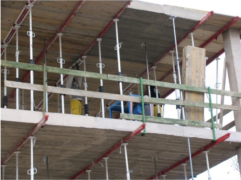
Fig. II.34 Clareado del forjado 3 (18/12/2006)
