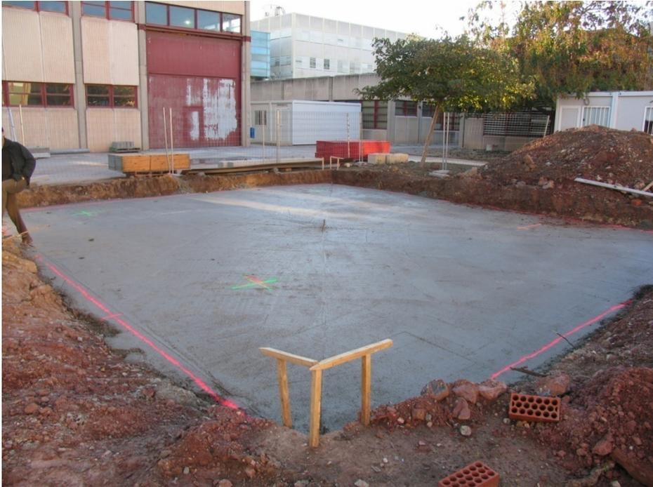
Fig. II.2 Hormigón de limpieza y replanteo de la cimentación (14/11/2006)
