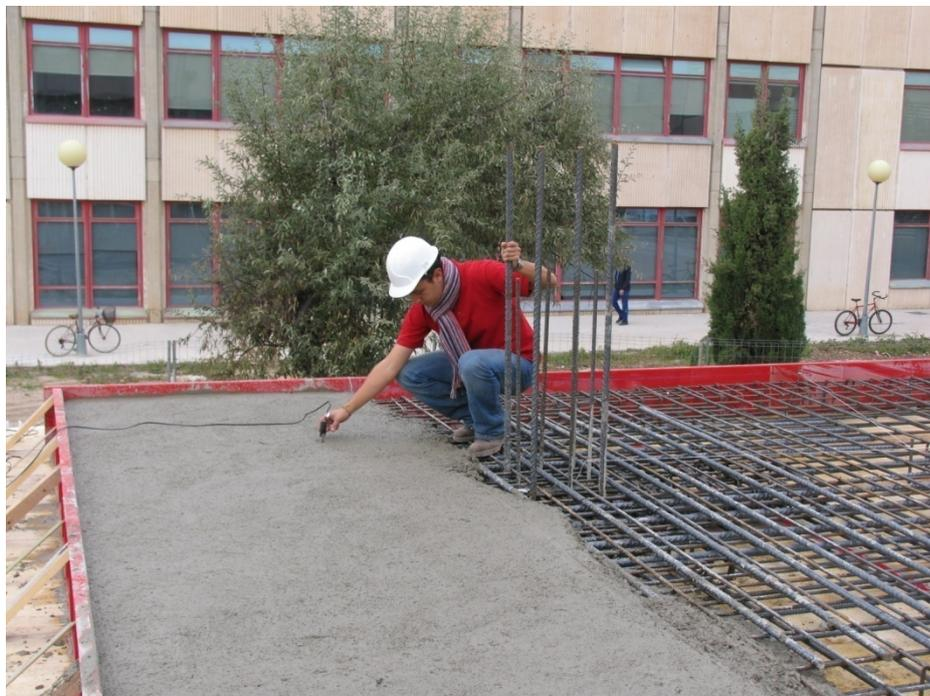
Fig. II.13 Instalación de termopares en el hormigón del forjado 1 (28/11/2006)
