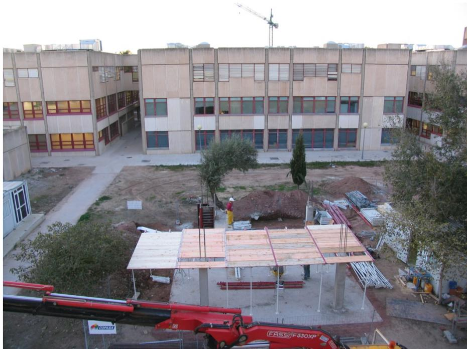
Fig. II.5 Instalación del sistema de cimbrado del forjado 1 (20/11/2006)
