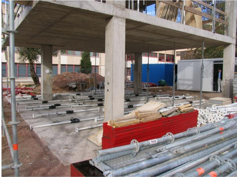
Fig. II.28 Descimbrado del forjado 1 (12/12/2006)
