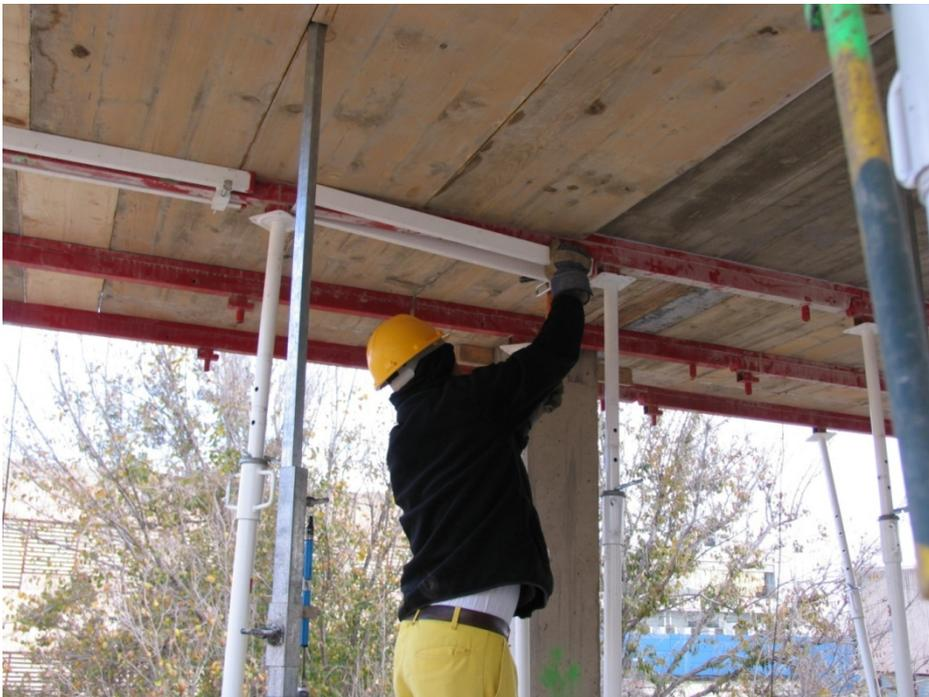
Fig. II.35 Manipulación del basculante de las sopandas principales durante la operación de clareado (18/12/2006)
