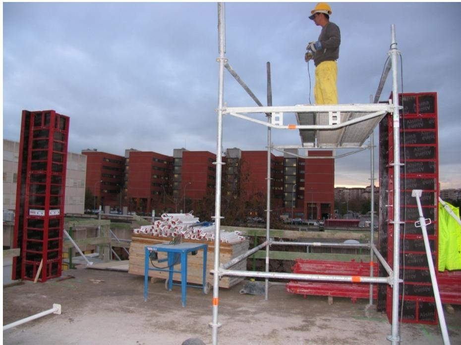
Fig. II.24 Hormigonado de los pilares del forjado 3 (11/12/2006)
