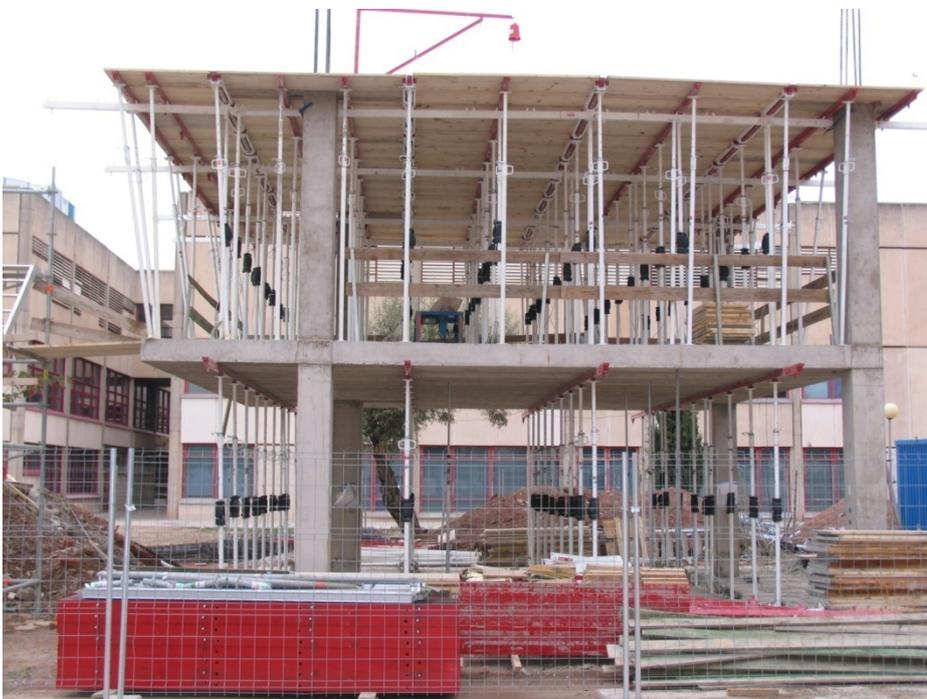
Fig. II.19 Clareado del forjado 1 (01/12/2006)
