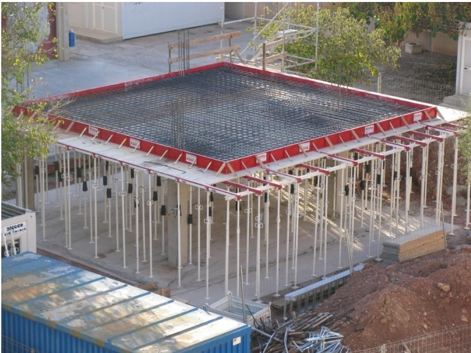
Fig. II.7 Armado del forjado 1 (22/11/2006)
