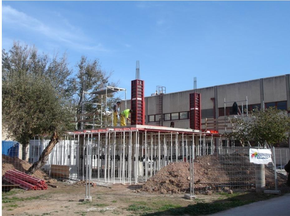
Fig. II.16 Montaje del encofrado de los pilares del forjado 2 (29/11/2006)
