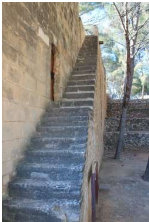
Figura 24. Torre Roja. Acceso. A. Ronda
