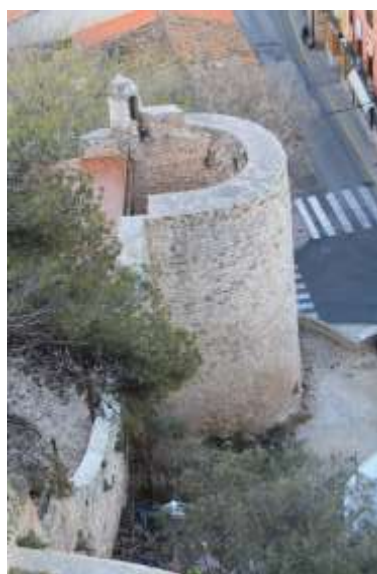
Figura 41. Torre del Galliner. A. Ronda
