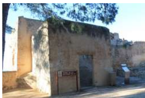
Figura 29. Torre de la Pólvara. A. Ronda
