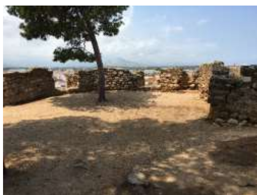
Figura 32. Fort de la Redondela. A. Ronda
