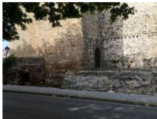
Figura 39. Torre del Galliner. A. Ronda
