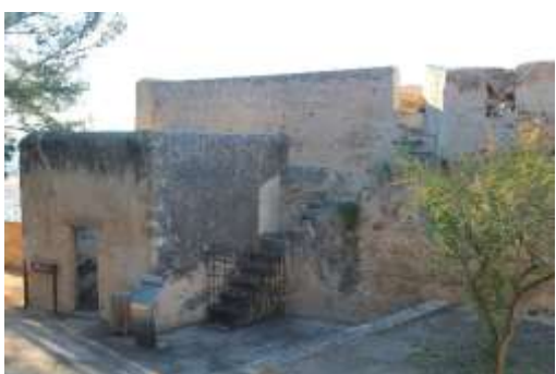
Figura 28. Torre de la Pólvara. A. Ronda
