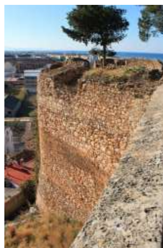
Figura 35. Fort de la Redondela. A. Ronda
