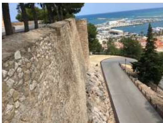
Figura 50. Bateria Sud. A. Ronda
