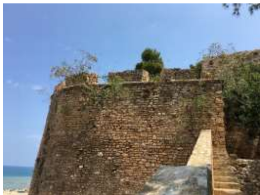
Figura 61. Torre Nord. A. Ronda
