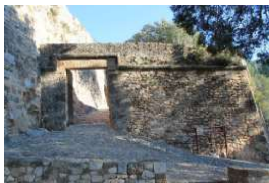
Figura 58. Acceso al Baluart. A. Ronda
