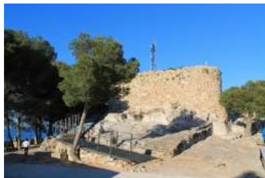
Figura 54. Torre Palau Vell. A. Ronda
