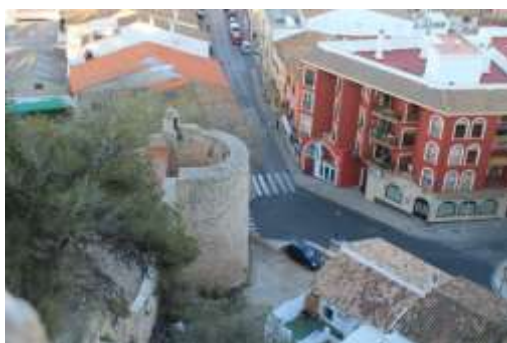
Figura 38. Torre del Galliner. A. Ronda
