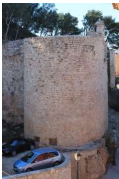
Figura 40. Torre del Galliner. A. Ronda
