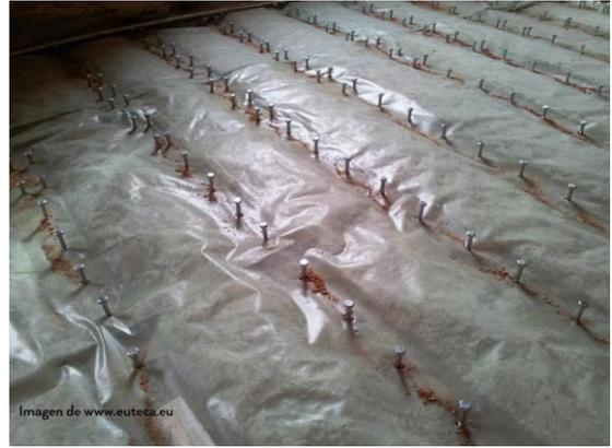
*Fig. 4 6 Colocación de conectores y capa protectora. 2016. www.euteca.eu*
