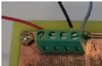
Figura 85. Colocación de los cables de alimentación de la placa.
