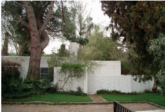
Figura 6. Acceso a la vivienda.
