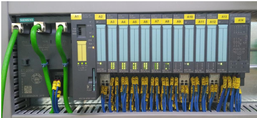
Imagen 6: IM151-8F PN y cartas de comunicación I/O
