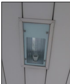
Figura 20: Iluminación de vapor de sodio del exterior.
