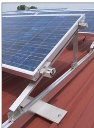
Figura 43: Detalle fijación a realizar.
