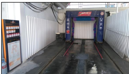
Figura 24: Túnel de lavado de la estación.
