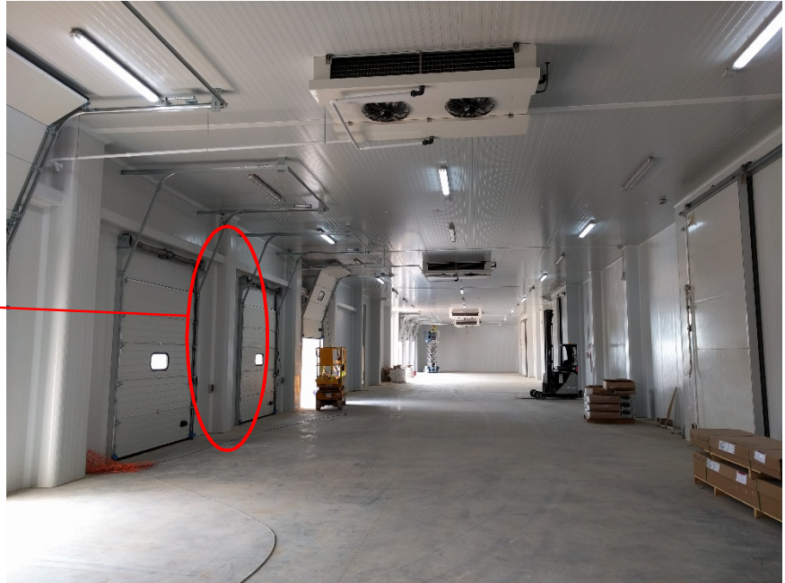
Ilustración 51. Cajeados pilares con panel frigorífico
