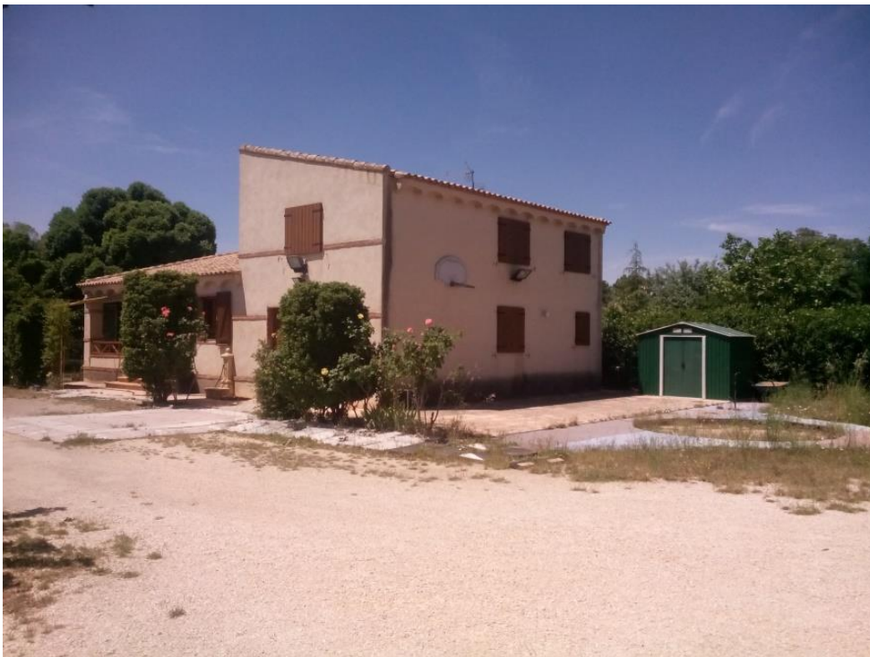
Estado actual de la zona en que se situaría la zona chill out y la piscina.
