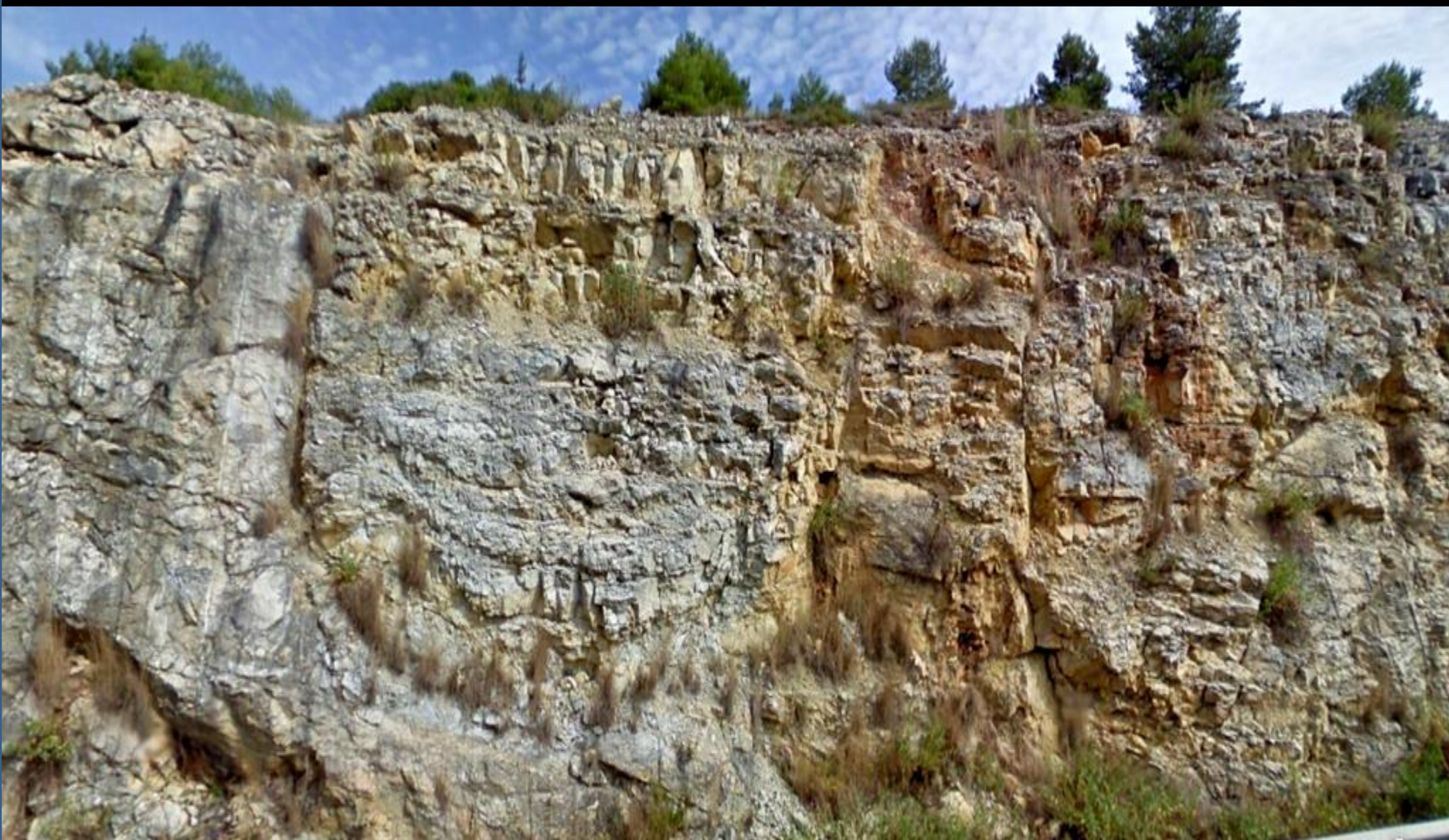
Tectónica intensa en un talud de calizas y margas Albiense-Cenomaniense, Cretácico. Al W de Gata de Gorgos. Autovía del Mediterráneo.
