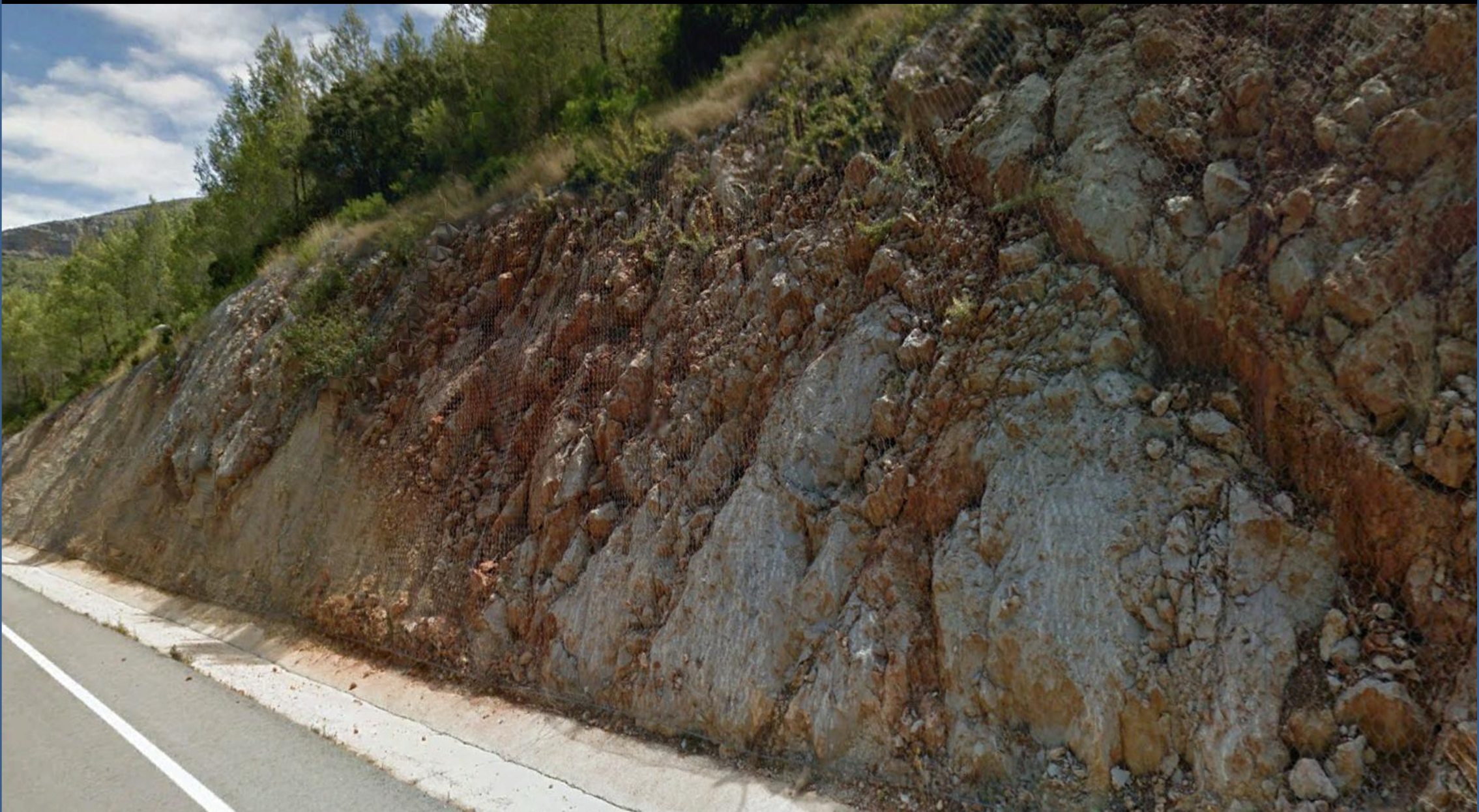
Mallazo en las calizas- fracturadas y con terra rossa- y margas, del Barremiense, Cretácico Inf. E de Castell de Castells, Alicante, carretera junto al río Jalón o Gorgos. NW Hoja de Benisa.
