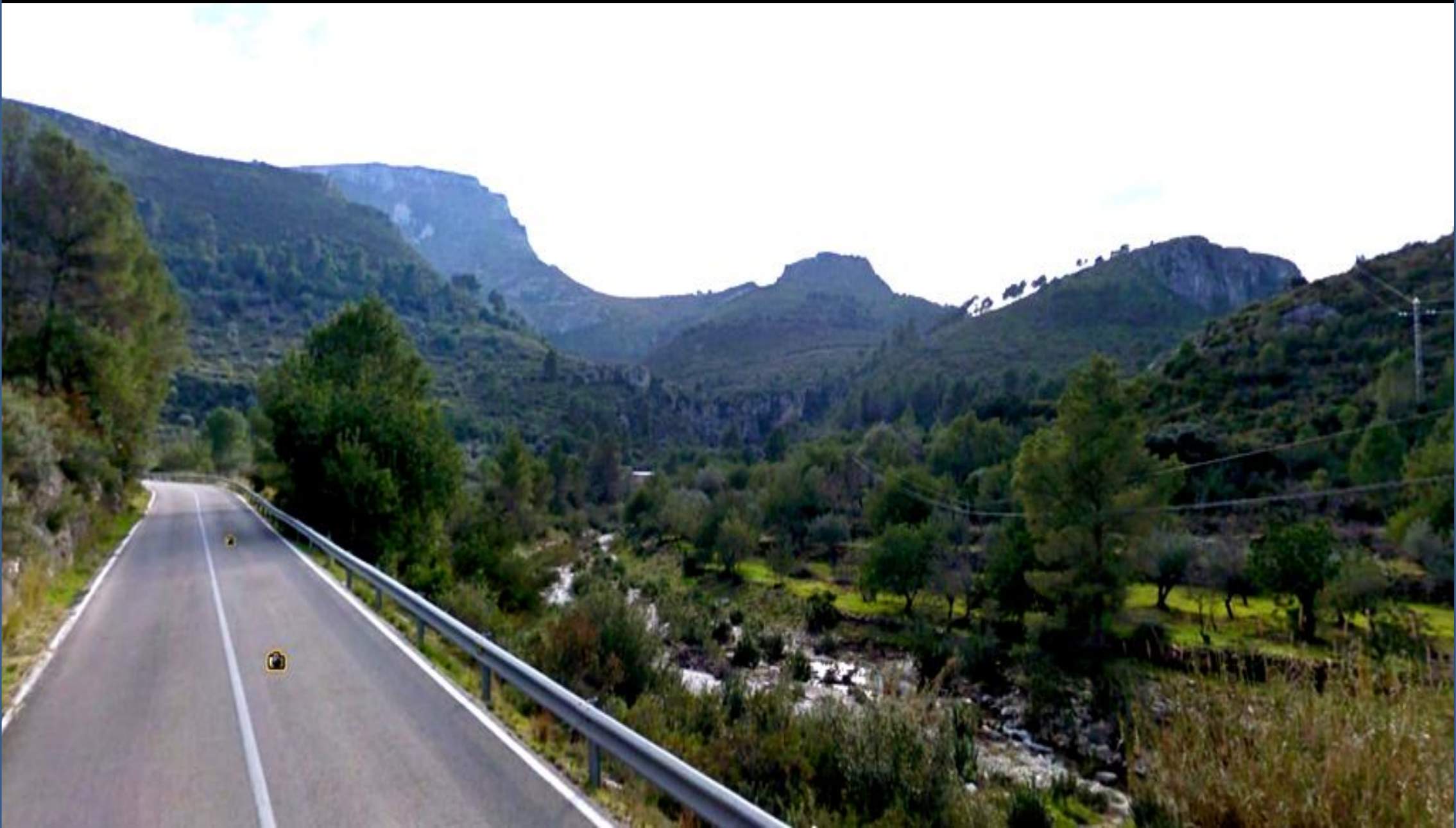
En el barranco de la Rambla de Gallinera, al NW de Adsubia. SW Hoja de Gandía.
