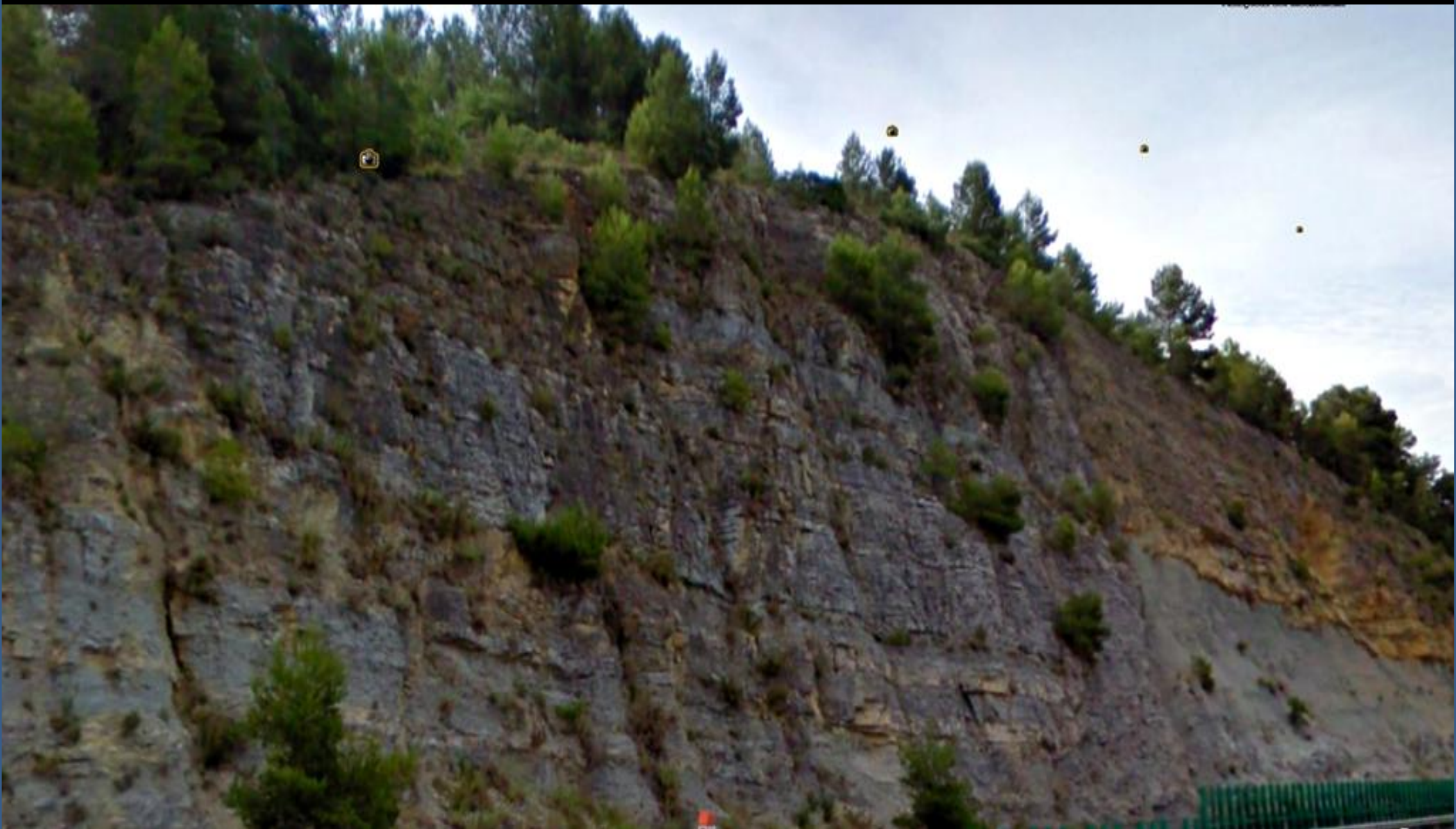
Talud de calizas y margas Albiense-Cenomaniense, Cretácico. Falla. La Solaneta. Al SW de Gata de Gorgos. Autovía del Mediterráneo.
