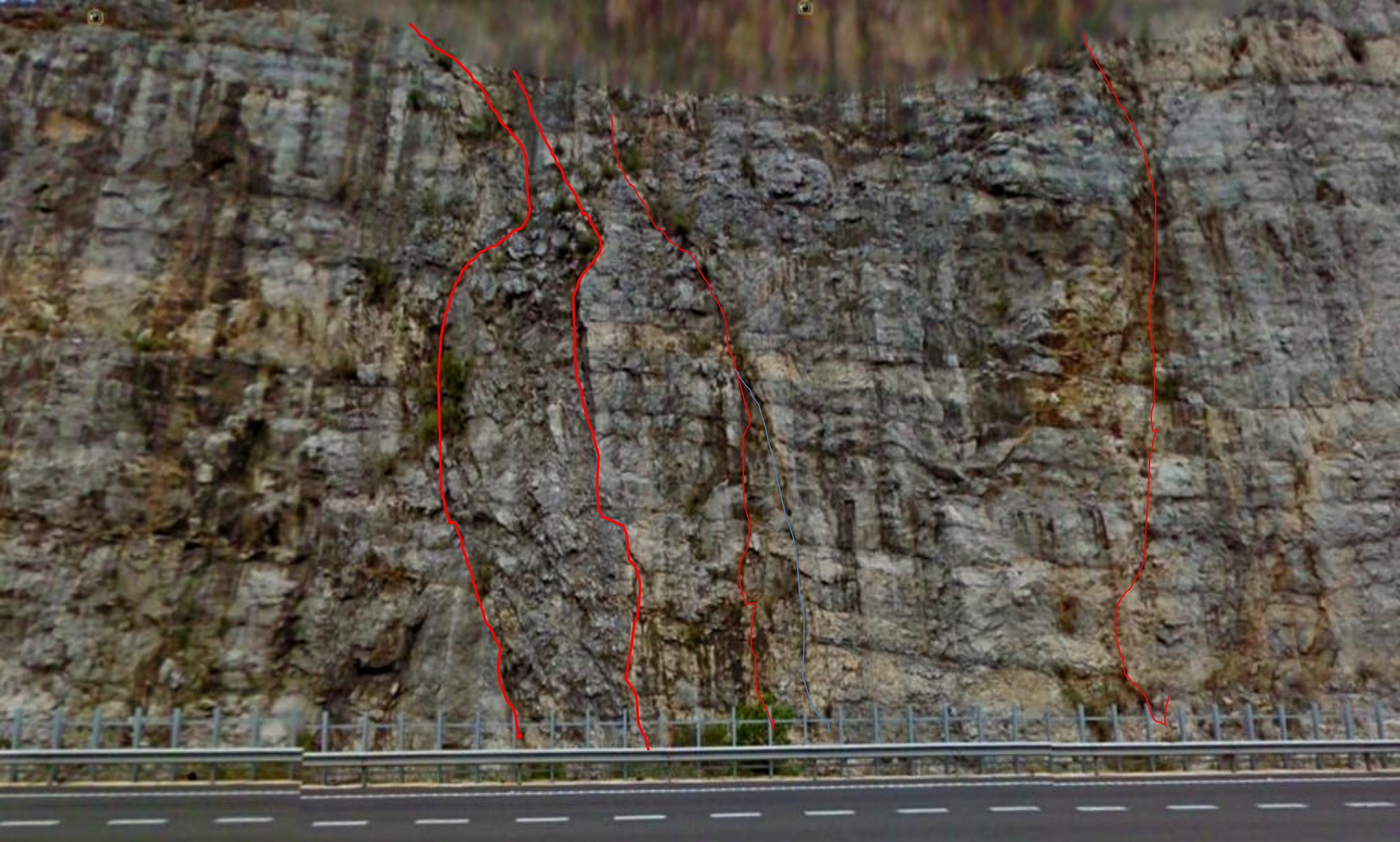
Detalle de la intensa fracturación en talud de imagen anterior de Calizas y alguna marga del Aptiense- Albiense, Cretácico Inf. Al SW de Gata de Gorgos, N de Senija, Alicante. Autovía del Mediterráneo. SE Hoja de Benisa.
