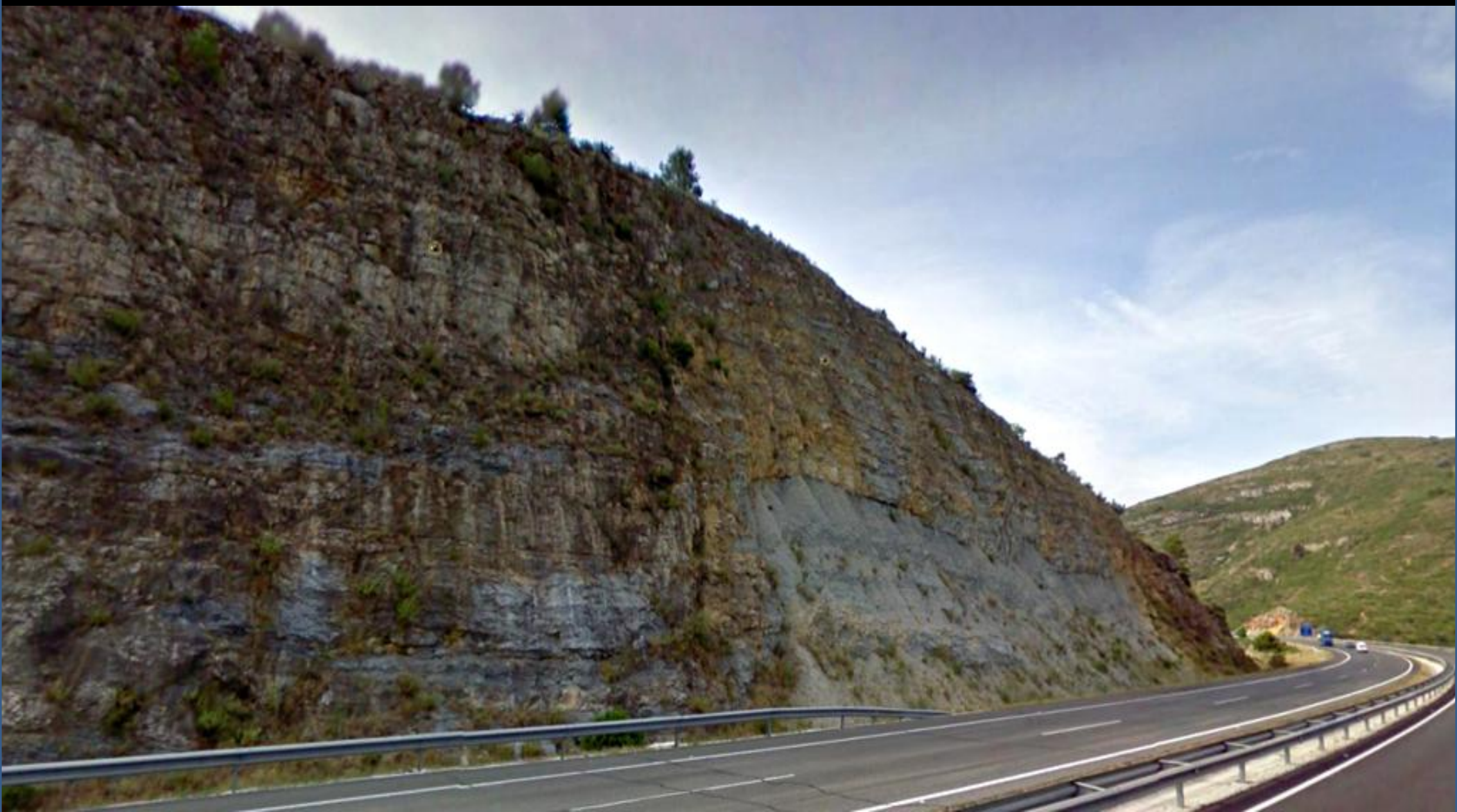
Tectónica intensa en un talud de calizas y margas Albiense-Cenomaniense, Cretácico. S de La Solaneta. Al SW de Gata de Gorgos. Autovía del Mediterráneo.
