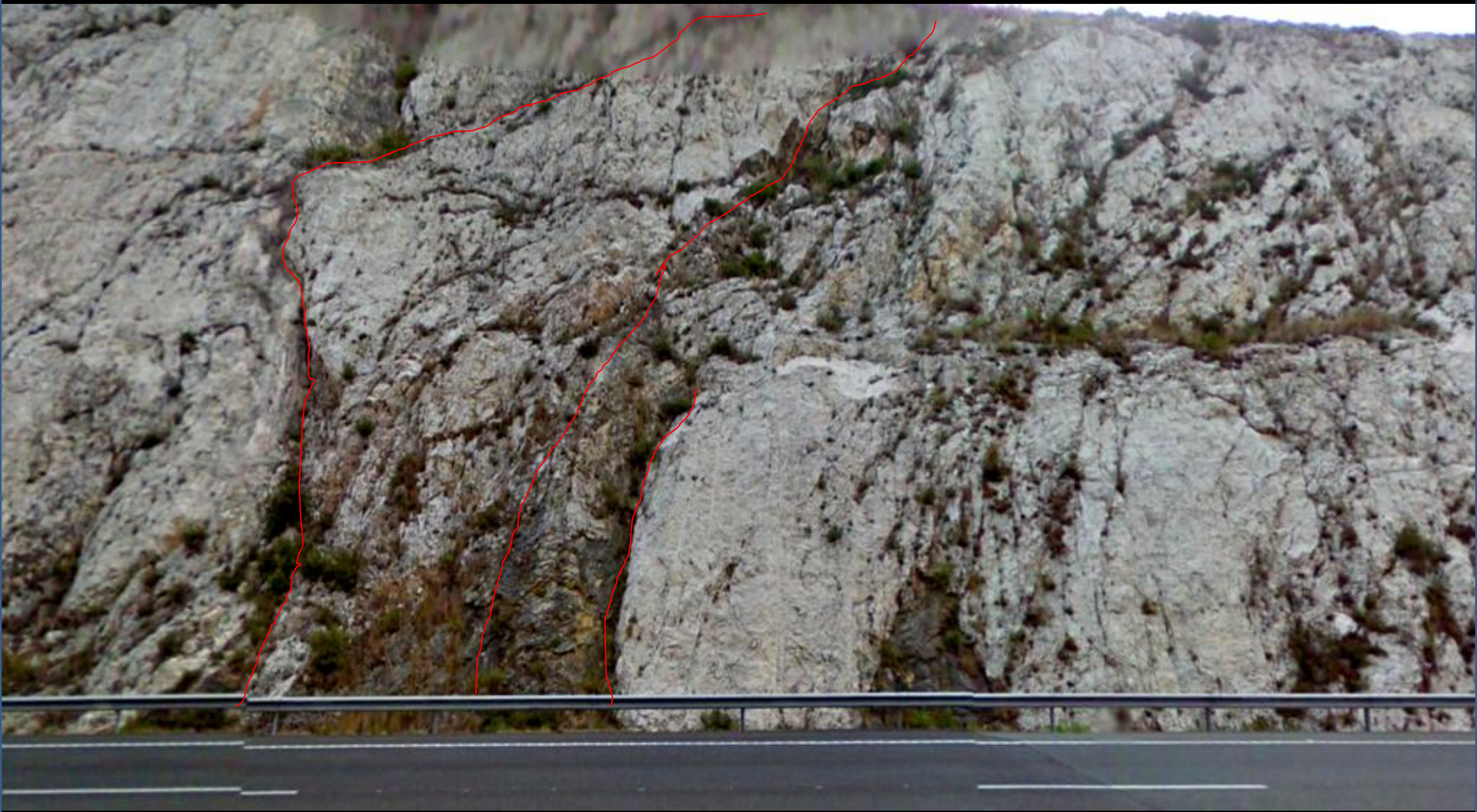
Fracturación intensa, fallas y cierto karst en talud de calizas del Cretácico Sup. Al NW de Gata de Gorgos. Autovía del Mediterráneo. NE Hoja de Benissa.
