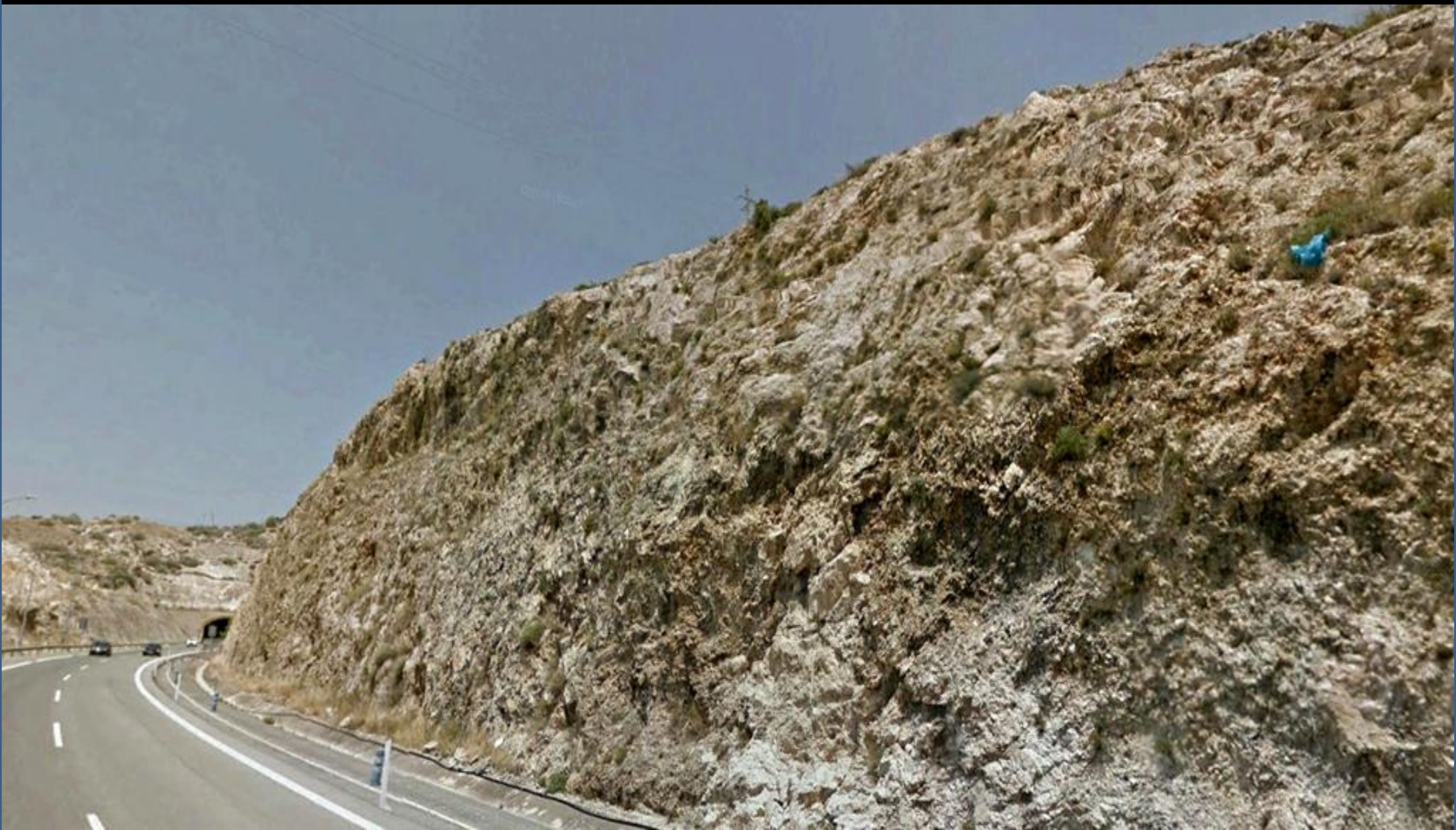
Calizas del Cretácico Sup., muy tectonizadas. Al E de Villena en la Autovía de Alicante. NE Hoja de Yecla – NW Hoja de Castalla.
