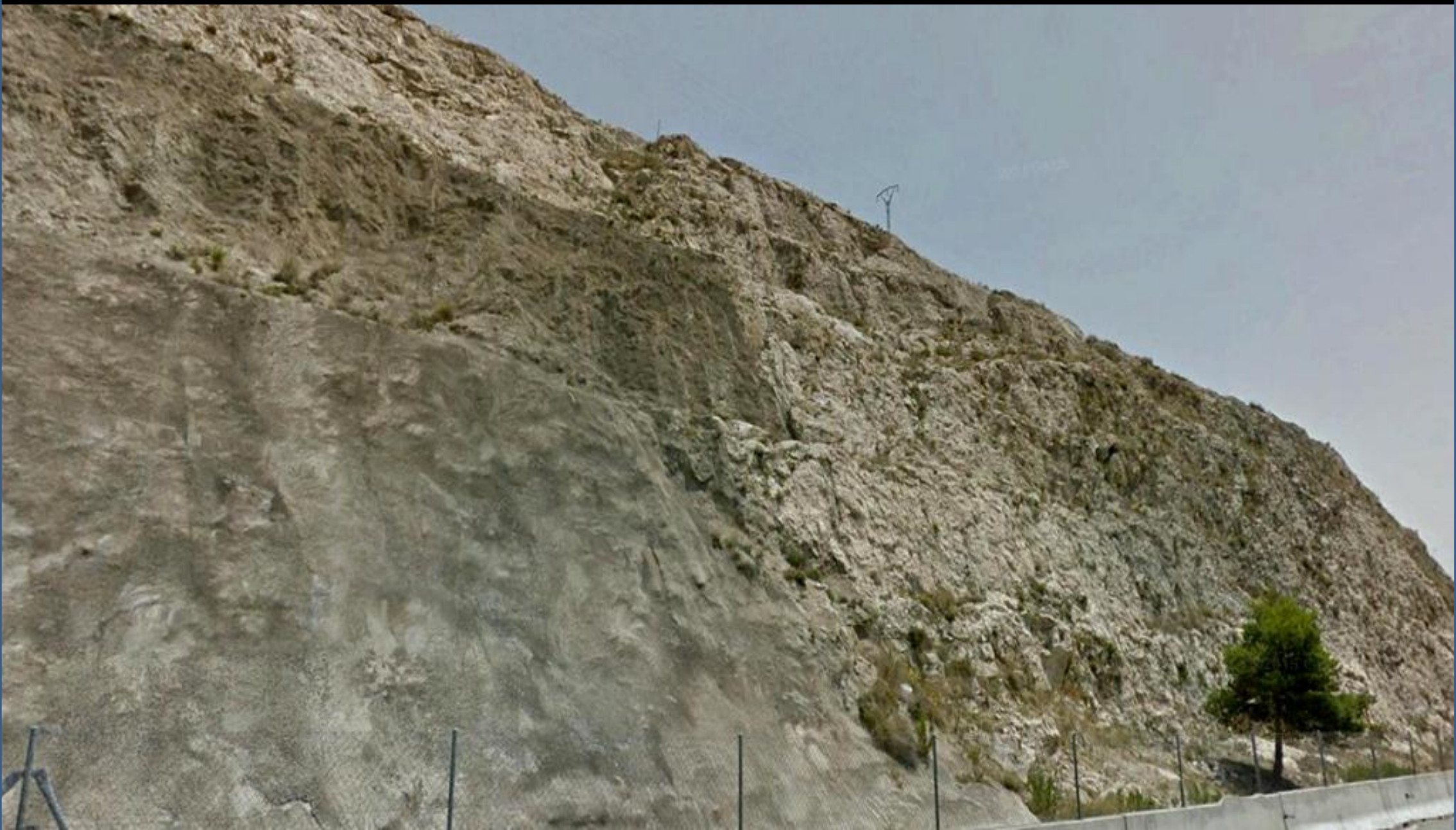
Calizas del Cretácico Sup., muy tectonizadas. Gunitado de parte del talud. Al E de Villena en la Autovía de Alicante. NE Hoja de Yecla.
