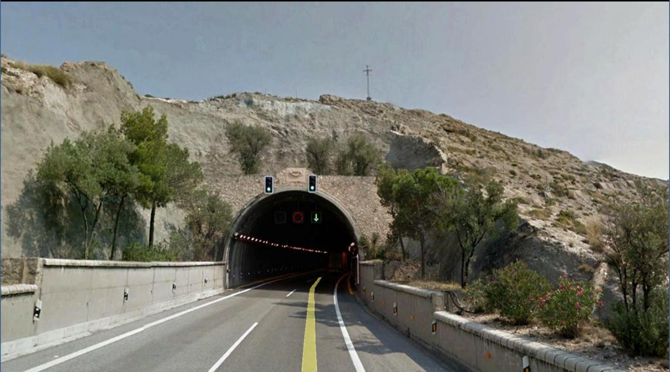
Salida S túnel autovía de Alicante, al SE de Villena, Alicante. Gunitado en las calizas del Cretácico Sup. Cerro de La Umbría de La Celada, NE Hoja de Yecla.
