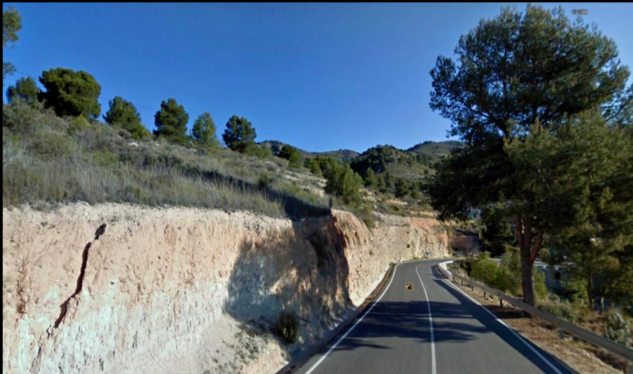
Talud de margas blanquecinas del Mioceno Medio, Terciario, coronado de Cuaternario- en color salmón-. Al N de Tibi. SE Hoja de Castalla
