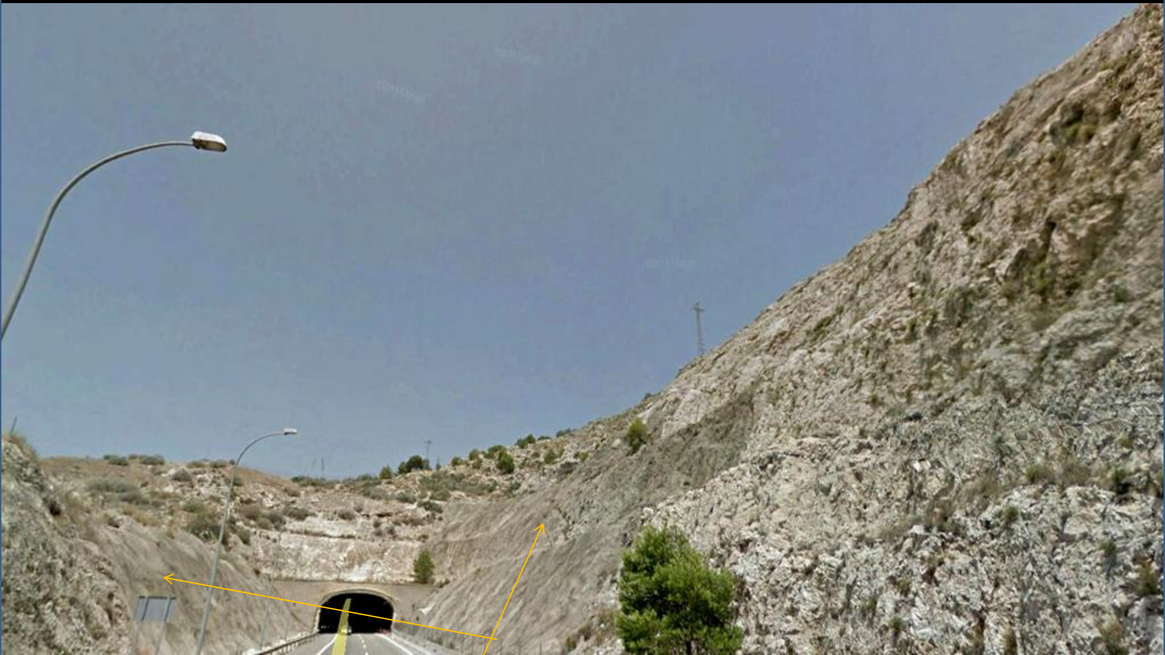
Salida S del túnel de la anterior: Dolomías Cenomaniense-Turonense, Cretácico Sup. Gunitado. Autovía de Alicante, E de Villena.
