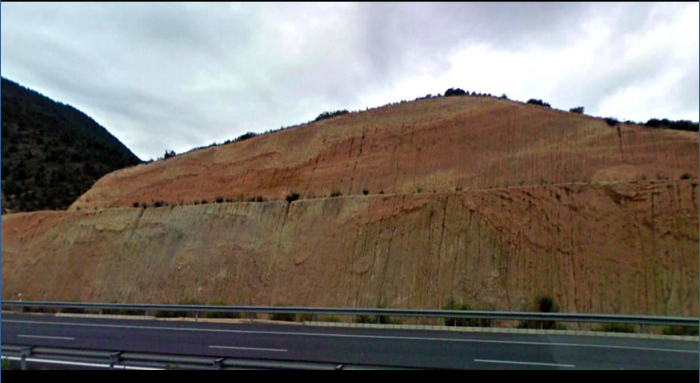
Talud en arcillas versicolores y yesos del Keuper, Triásico Sup. Al N de Agost. Autovía del Mediterráneo. SE Hoja de Castalla
