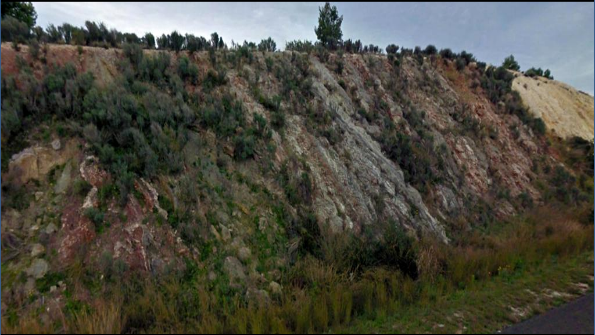
Talud menor de la Autopista del Mediterráneo de arcillas y yesos del Keuper, Triásico. Al SW de Altea, Centro W Hoja de Benidorm
