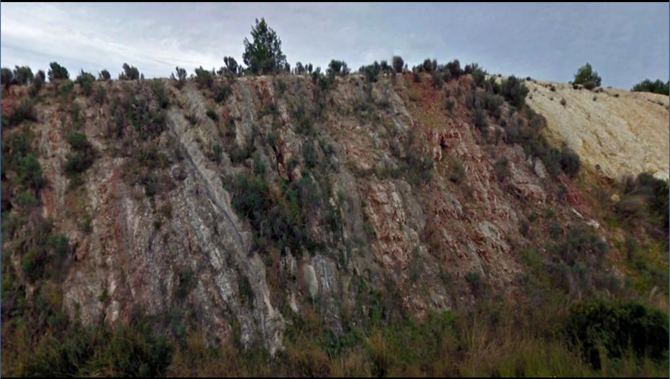
Detalle de la Imagen anterior: Talud menor de la Autopista del Mediterráneo de arcillas y yesos del Keuper, Triásico. Al SW de Altea, Centro W Hoja de Benidorm
