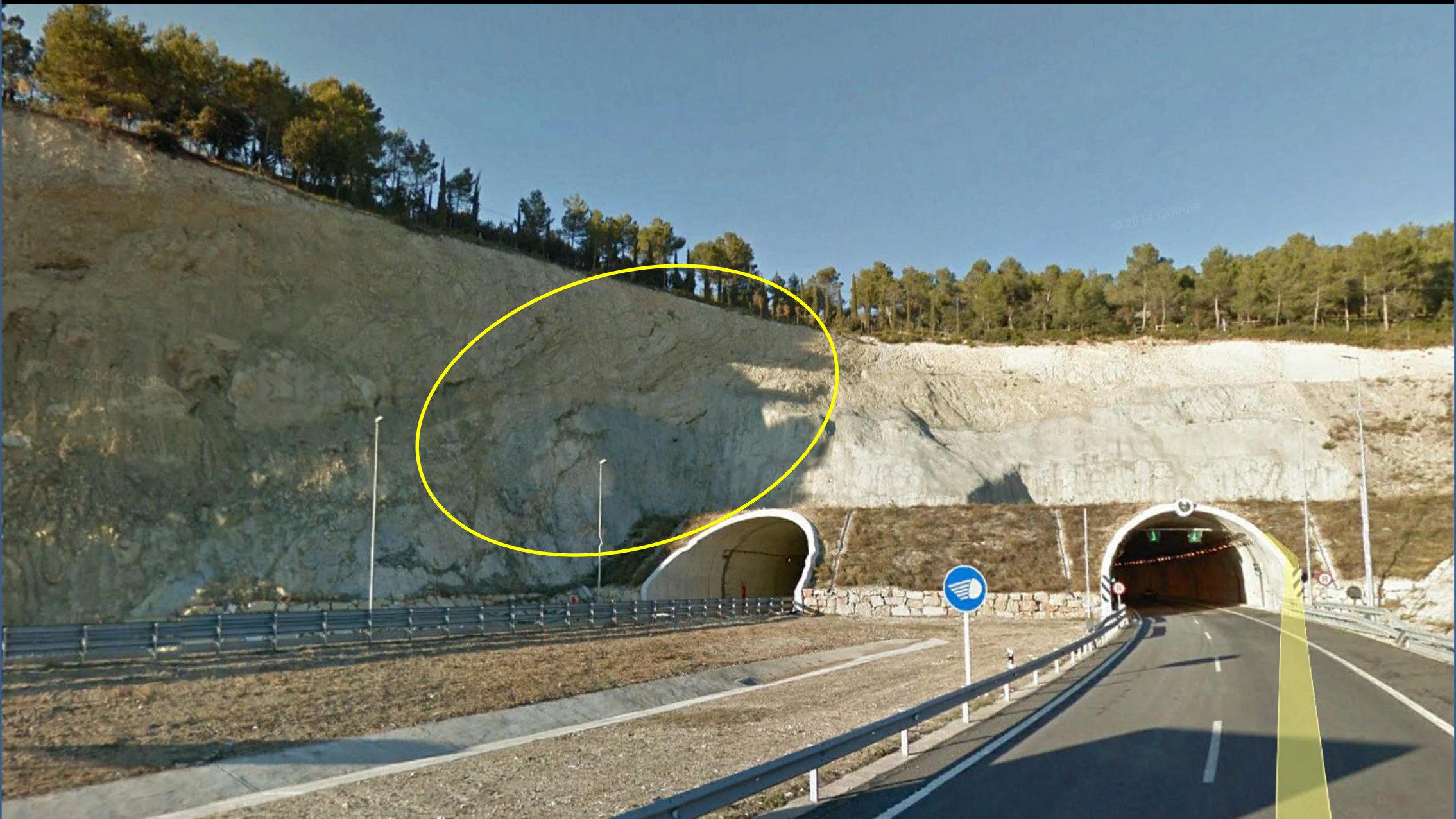
Detalle en la anterior: Túneles en la Autovía A7 . Margas blancas- tectonizadas y con gunitado gris- del Serravaliense- Tortoniense, Mioceno Med.-Sup. Terciario. S de Alcoy, Alicante. NW Hoja de Villaj
