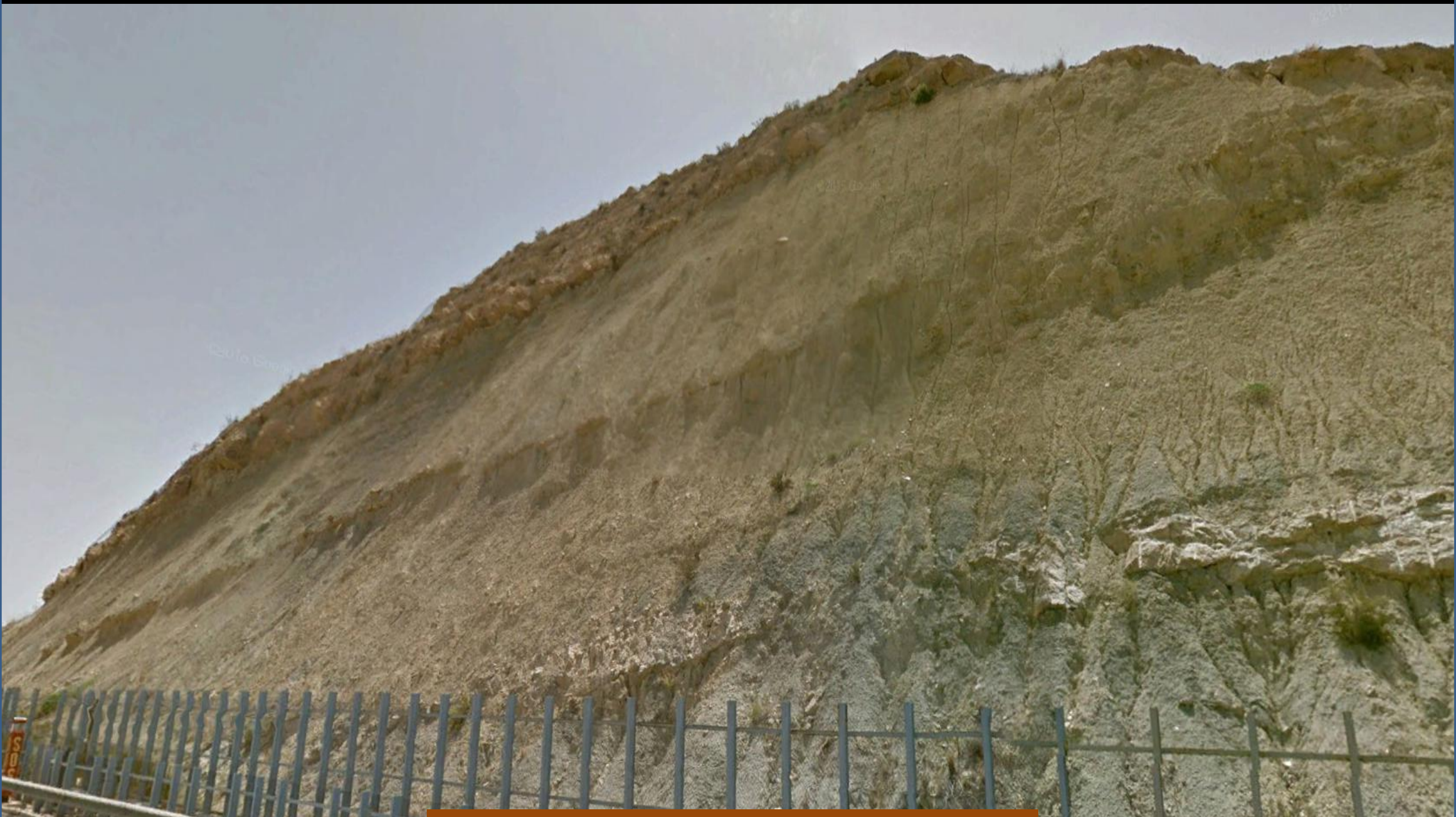
Flysch de margas, calizas y areniscas del Paleógeno - Mioceno Inf. Terciario. Autopista del Mediterráneo, por el NE de Campillo, Alicante. NE Hoja.
