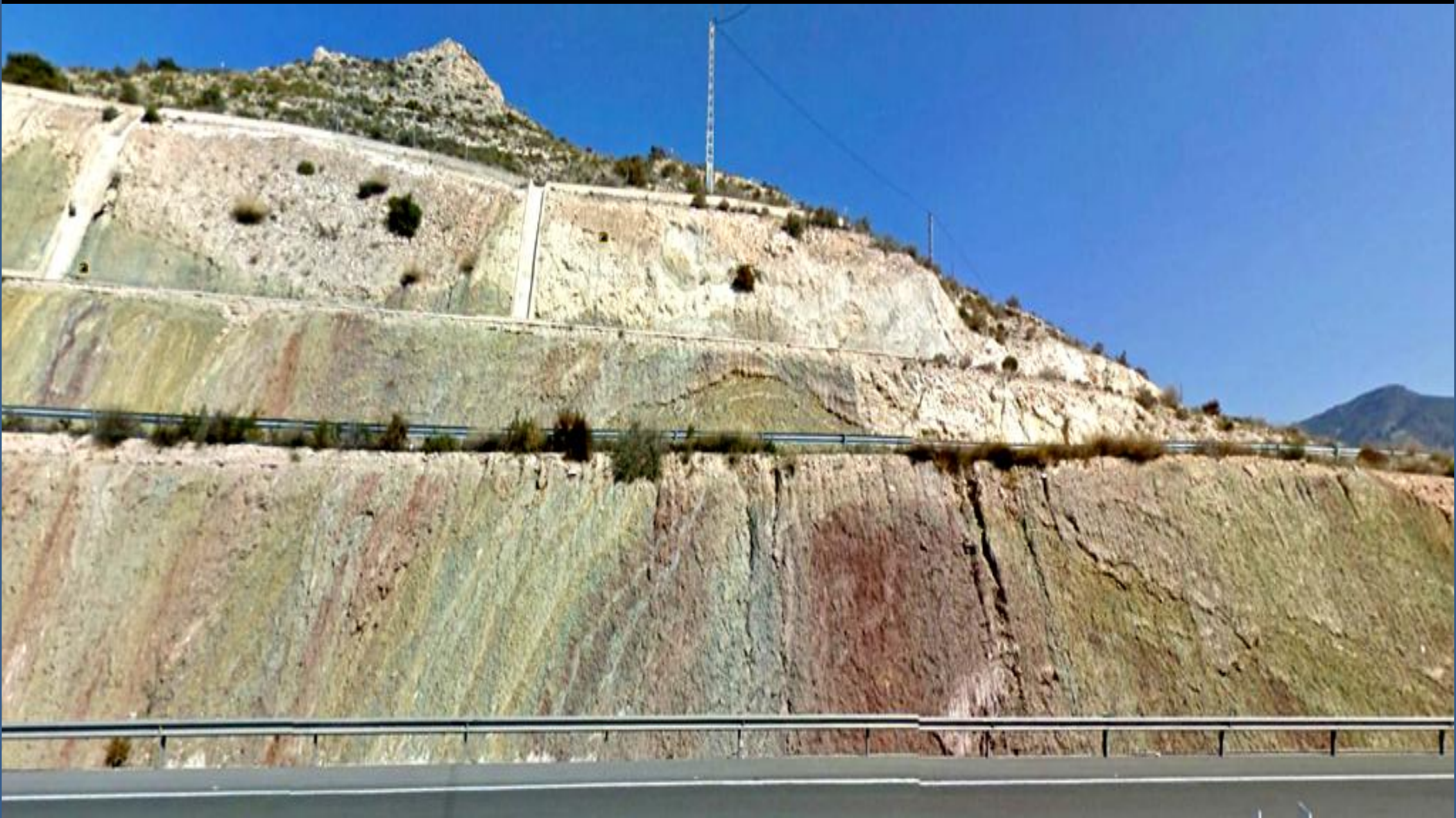
Detalle de imagen anterior: Contacto discordante. Arriba, calizas margosas del Burdigaliense-Langhiense, Mioceno Inf.-Med. Terciario. Debajo, halocinesis en las arcillas y yesos del Keuper, Triásico. Autopista Mediterráneo Al N –junto- a Elda, Alicante. W Hoja.
