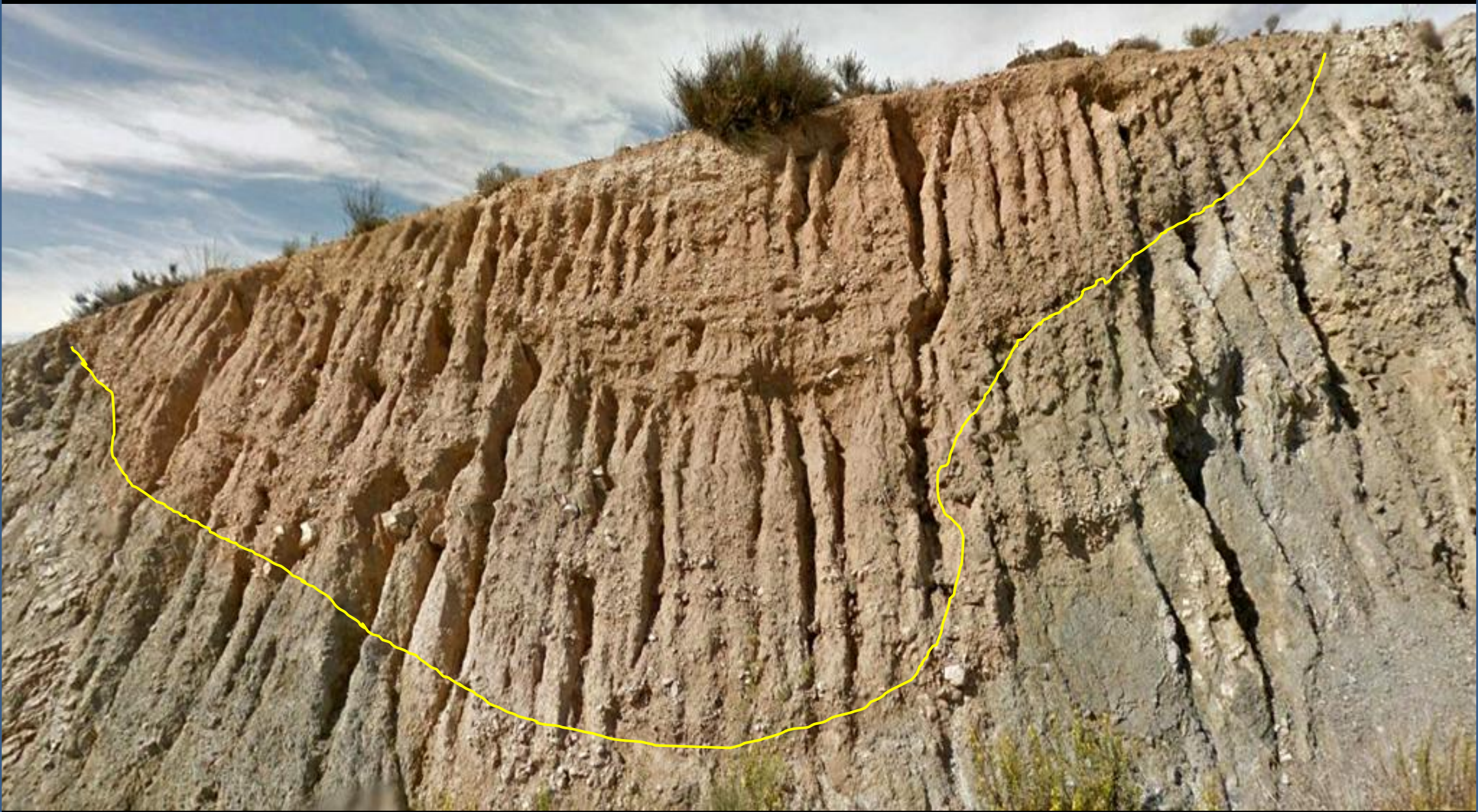
Comienzo del acaravado sobre un paleocauce- Cuaternario- desarrollado entre yesos del Keuper, Triásico Sup. S de Castalla, Alicante, junto a la A7. NE Hoja de Elda.
